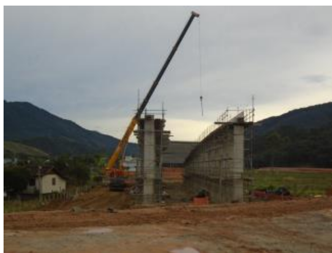
Figura 06 – Vista Geral, km 212+180
