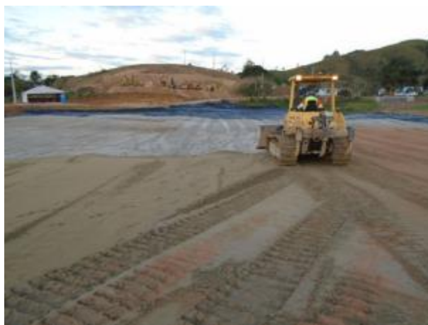
Figura 14 - Execução de camada drenante- km 181+120
