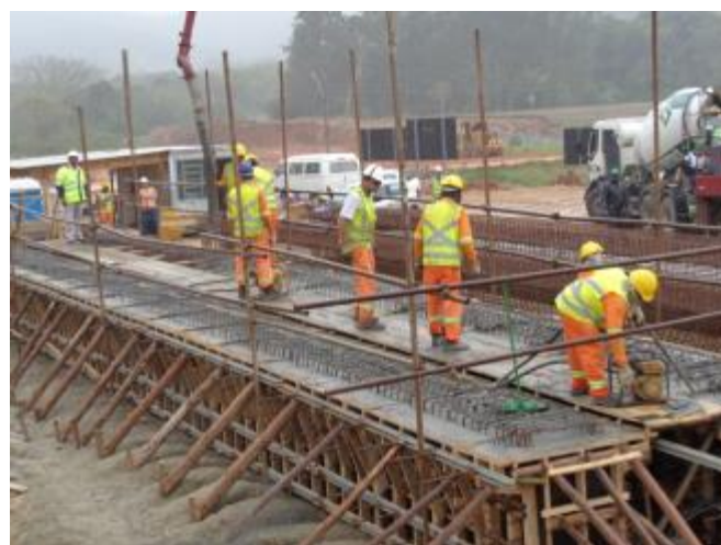
Figura 12 - Concretagem das Vigas Longarinas- km 216+665
