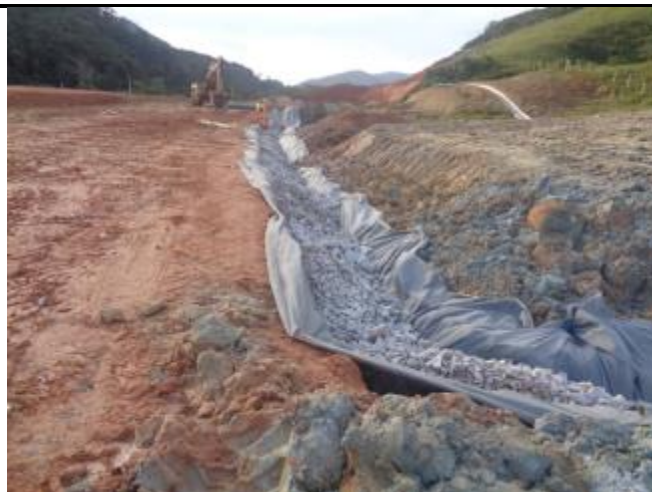
Figura 04 – Execução de DPL (Dreno Profundo Longitudinal), km 215+150
