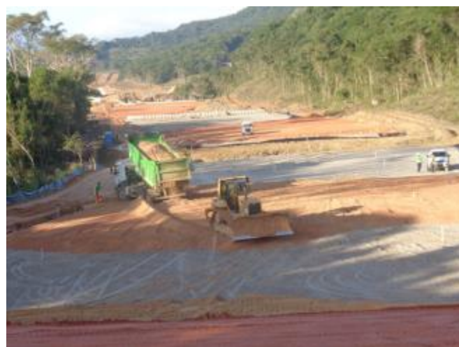
Figura 11 – Execução de Corpo de Aterro - km 216+180
