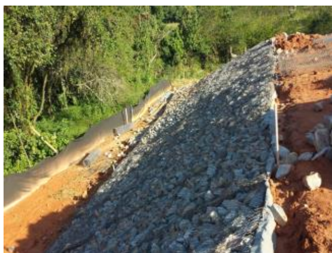
Figura 09 – Execução de Colchão Reno- Ramo 500, km 215+400
