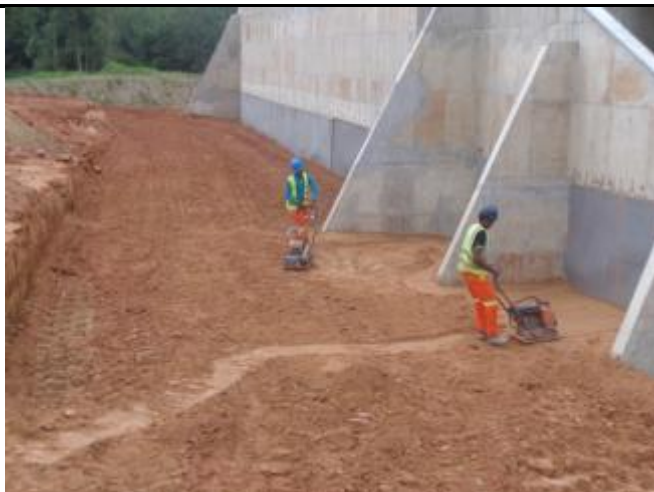
Figura 07 – Compactação Manual de Aterro (Encontro), km 213+720
