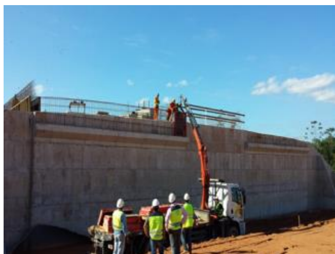
Figura 08 – Montagem da forma da barreira New Jersey, km 213+720
