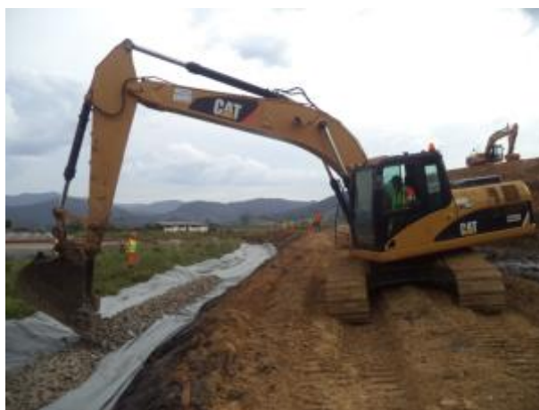
Figura 15 - Execução de dreno de talvegue - km 181+060
