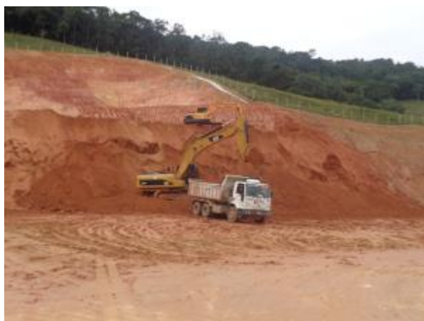
Figura 02 – Execução de escavação, carga e transporte na jazida de empréstimo, km 214+600
