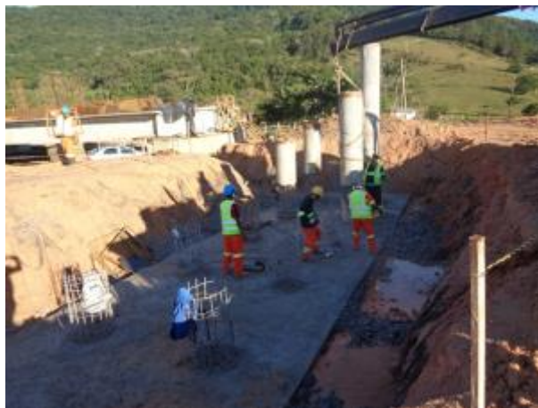
Figura 01 – Arrasamento de estacas - Ponte Forquilhas, km 212+320
