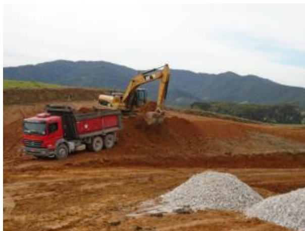
Figura 13 - Execução de corte no aterro - km 184+500
