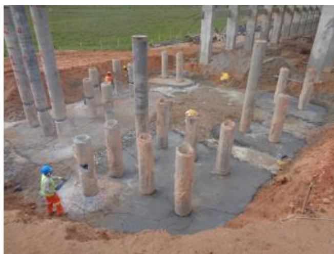
Figura 05 – Arrasamento de estacas - Lado Norte- km 212+180
