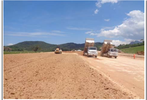
FOTO 4: TERRAPLENAGEM Compactação de corpo de aterro km 212+200
