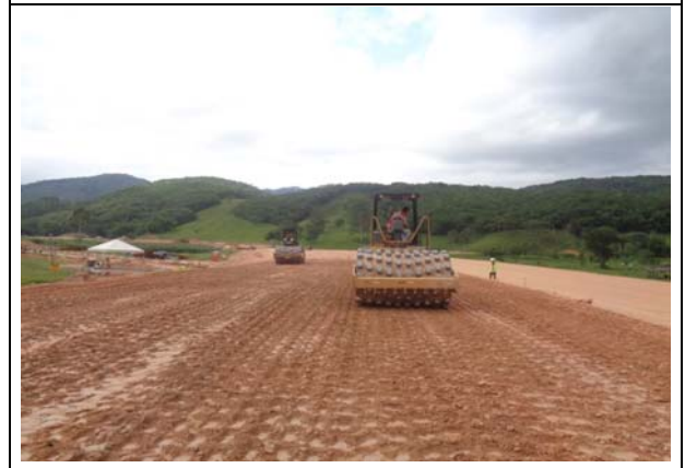
FOTO 4: TERRAPLENAGEM Compactação de corpo de aterro km 212+200
