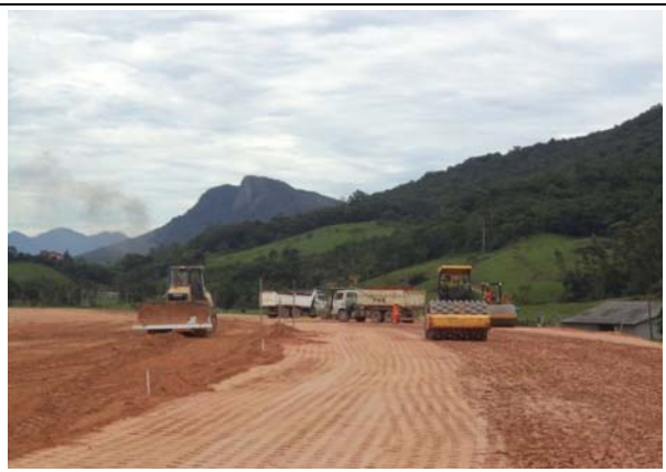
FOTO 3: TERRAPLENAGEM Compactação de corpo de aterro km 212+550
