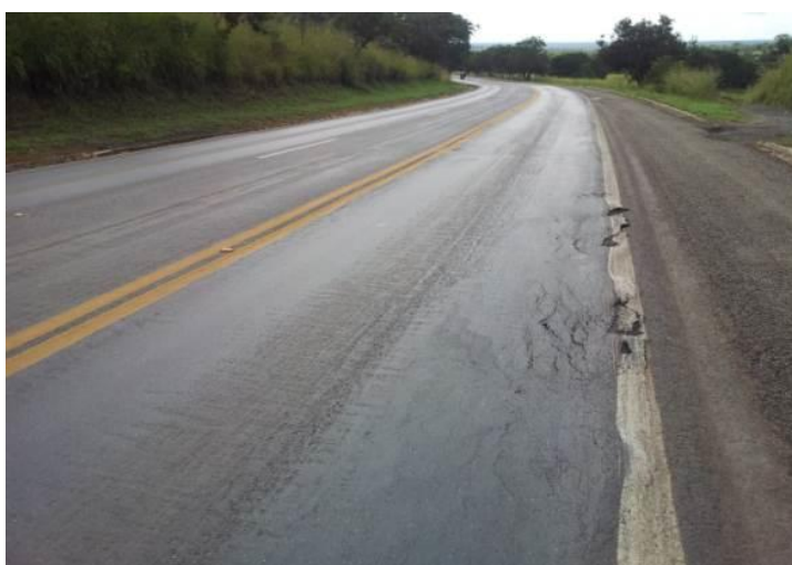
Figura 13 - Ondulação transversal OND (extensão – m).
