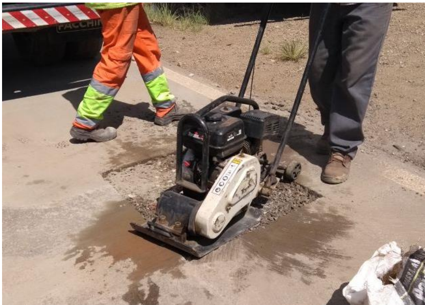
Figura 95 – Abertura da janela de inspeção.
