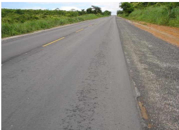
Figura 16 - Desgaste DES (área de superfície desgastada – m 2 ).
