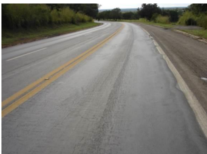
Figura 14 - Escorregamento ESC (extensão – m).
