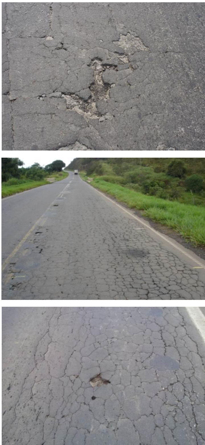
Figura 17 - Panela PA (número de panelas pequena PA P, média PA M e grande PA G - und). A quantidade de panelas pode ser transformada área ( m^2 ), sabendo-se que a panela média corresponde a 30x30x10cm (padrão HDM-4).
