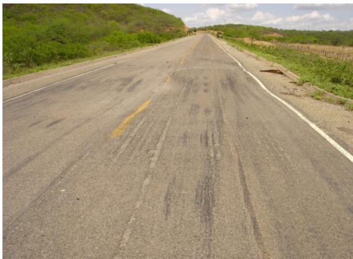
Figura 11 - Afundamento localizado AF LO (número de afundamentos - und).
