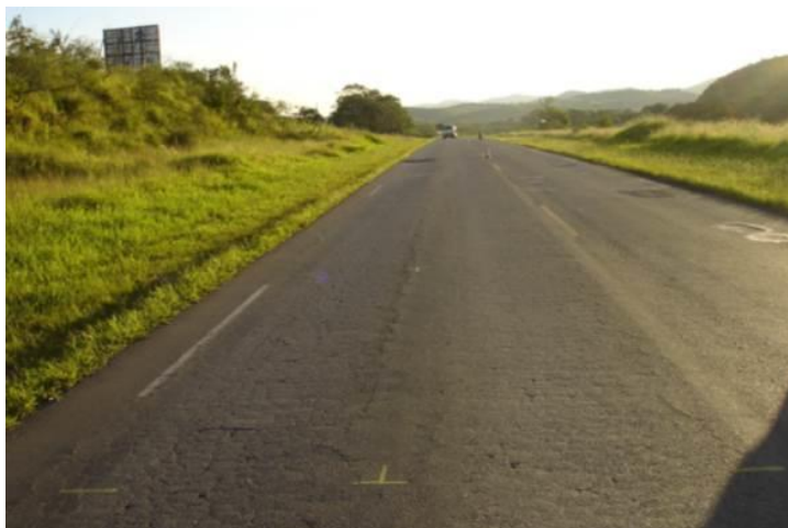
Figura 12 - Afundamento de trilha de roda AF TR (extensão – m).
