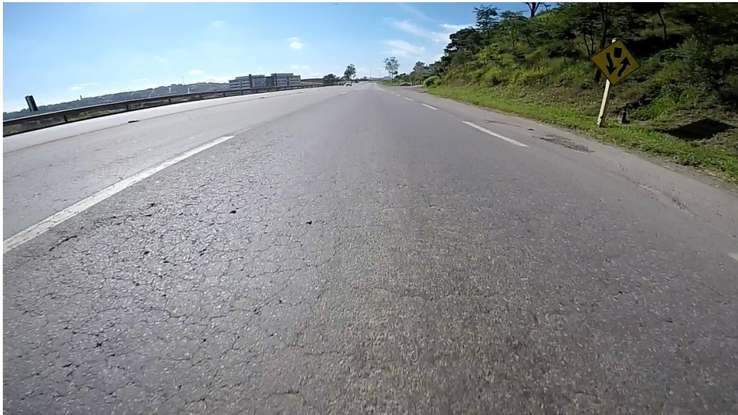
Figura 141 – Trecho experimental 02 (TE-02, km 631+350 ao km 631+750, UF: MG)
