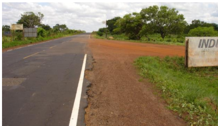
Figura 19 - Quebra de Bordo Q BOR (área de superfície com quebra de bordo – m 2 ).
