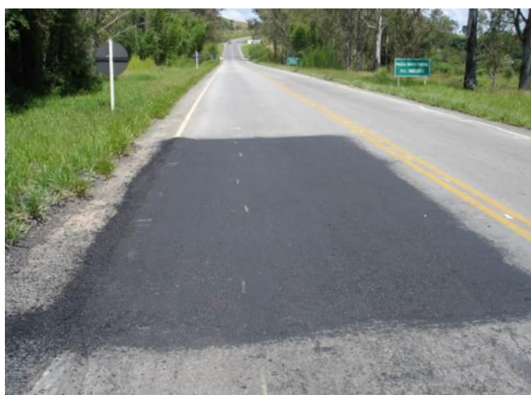
Figura 18 - Remendo REM (área de superfície remendada – m 2 ).
