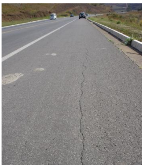
Figura 20 - Trinca longitudinal TL (extensão - m).
