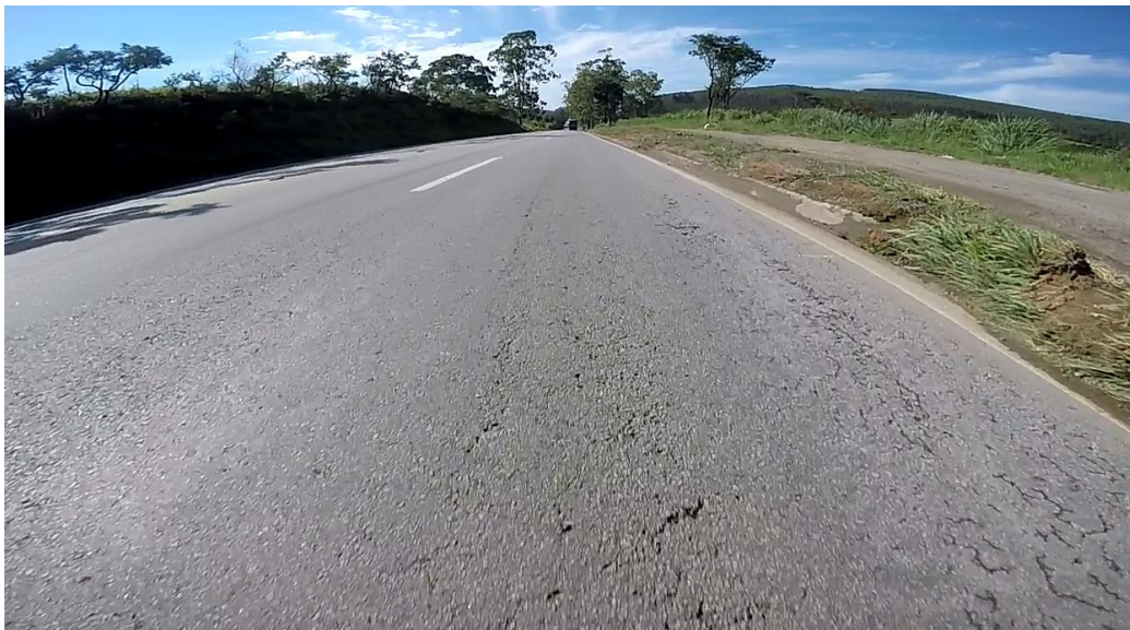
Figura 136 – Trecho experimental 01 (TE-01, km 644+570 ao km 644+970, UF: MG)
