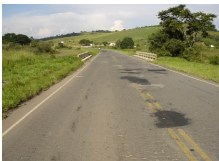
Figura 22 - Tapa buracos T BUR ou remendos provisórios pontuais (número de tapa buracos - und).
