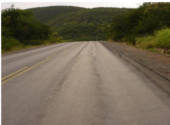
Figura 11 - Afundamento localizado AF LO (número de afundamentos - und).
