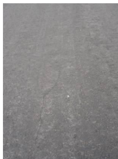
Figura 20 - Trinca longitudinal TL (extensão - m).
