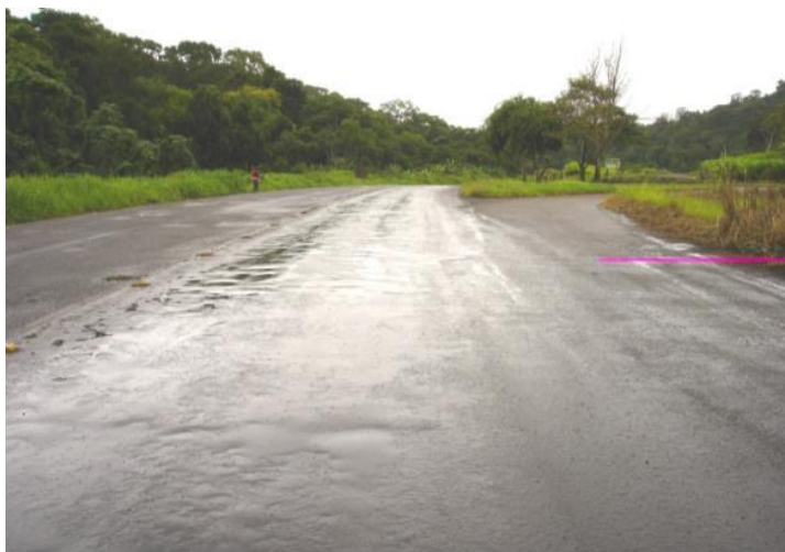
Figura 13 - Ondulação transversal OND (extensão – m).
