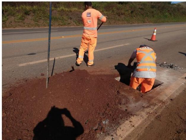
Figura 2.3 – Janela de inspeção – Coleta de material do subleito.
