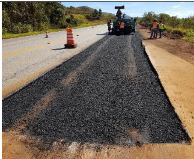
**Salgamento:** Lançamento de uma fina camada de massa asfáltica não regularizada apenas visando melhor aderência para os equipamentos
