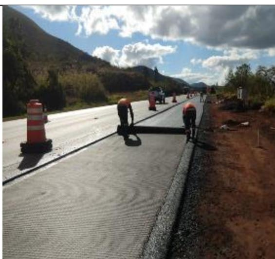
**Revestimento:** Instalação de Geogrelha
