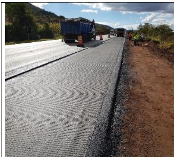
**Revestimento:** Instalação de Geogrelha
