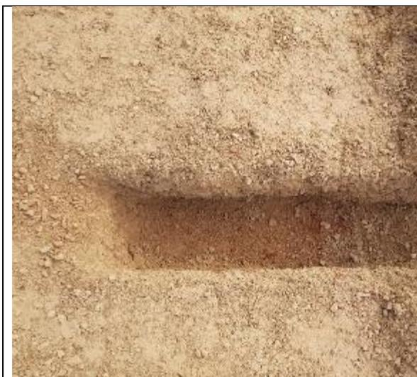
**Base:** Abertura da janela para o instalação da célula de pressão na interface da sub-base/base
