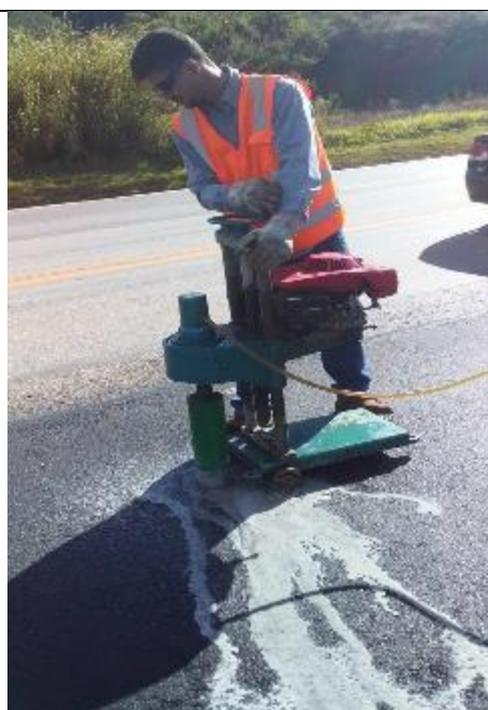
**Revestimento:** Extração do Corpo de Prova p/ controle de qualidade
