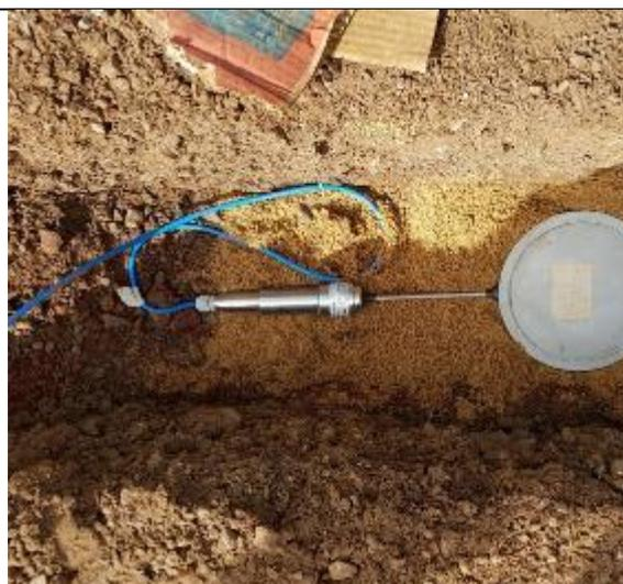
**Base:** Instalação da célula de pressão na interface da sub-base/base
