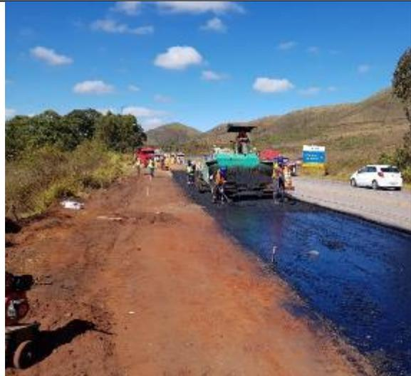
**Salgamento:** Lançamento de uma fina camada de massa asfáltica não regularizada apenas visando melhor aderência para os equipamentos
