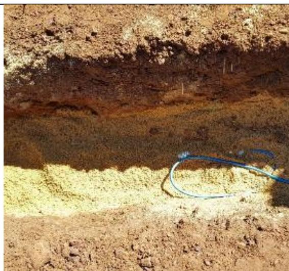
**Sub-base:** Instalação do sensor de pressão – Interface sub-base/subleito
