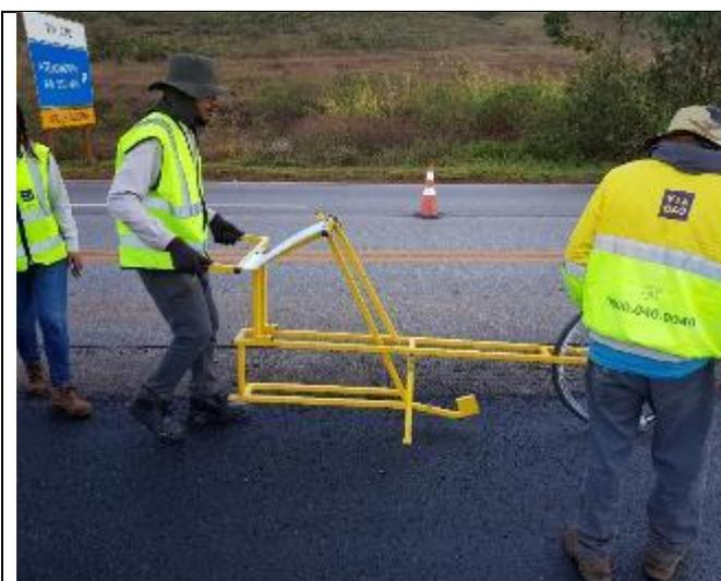
**Revestimento:** Ensaio Merlin
