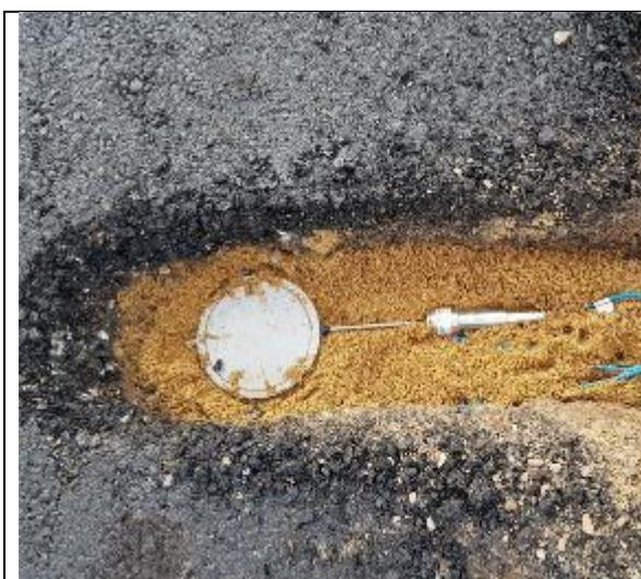
**Revestimento:** Instalação de célula de pressão na interface Base/revestimento
