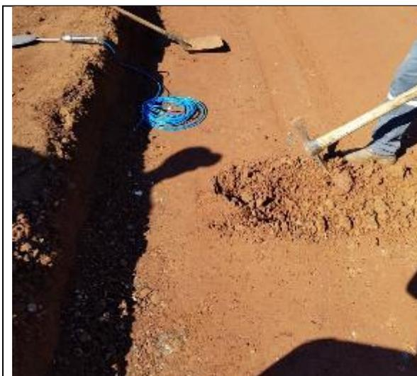
**Sub-Base:** Abertura da janela para instalação do sensor pressão – Interface sub-base/subleito
