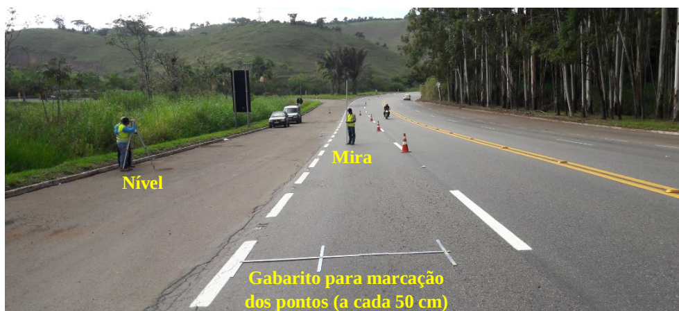
Figura 6 – Montagem de trecho de calibração e execução do nivelamento.
