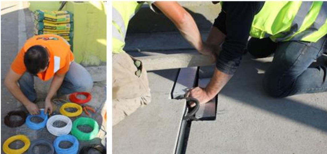
**Figura 36 – Instalação de sensores na BR-290/RS**
