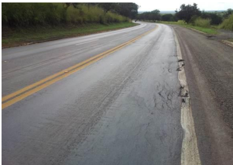
Figura 7 - Ondulação transversal O (extensão, m).
