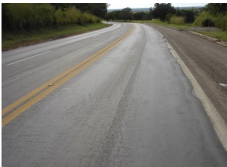
Figura 8 - Escorregamento E (extensão, m).
