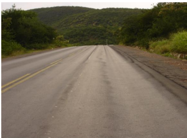
Figura 5 - Afundamento localizado (número de afundamentos, und).
