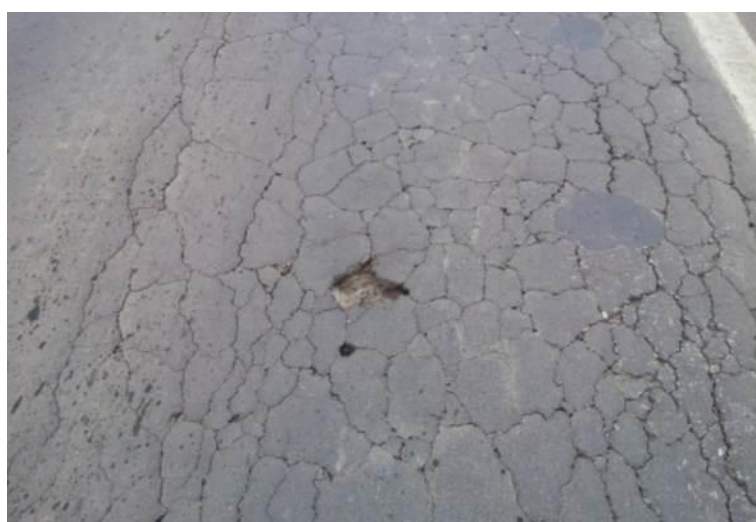
Figura 11 - Painel P (número de painéis: pequena PP, média PM e grande PG - und). A quantidade de painéis pode ser transformada em área ( m^2 ), sabendo-se que a painel média corresponde a 30x30x10cm (padrão do HDM-4).
