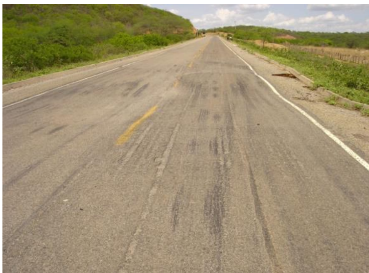
Figura 5 - Afundamento localizado (número de afundamentos, und).
