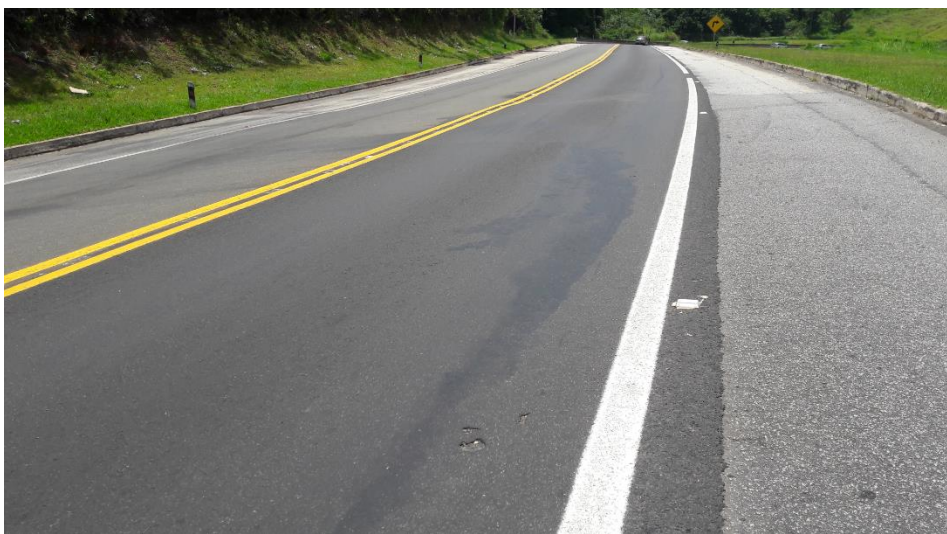
Figura 9 - Exsudação EX (extensão, m).
