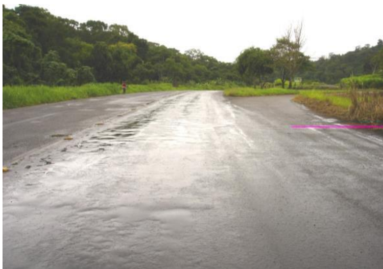
Figura 7 - Ondulação transversal O (extensão, m).
