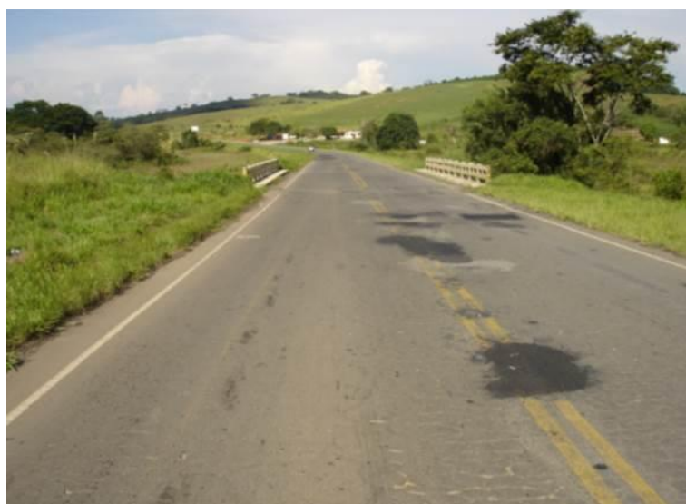
Figura 13 - Tapa buracos TB ou remendos provisórios pontuais (número de tapa buracos, und).
