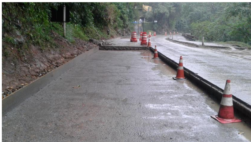
Figura 3 – Recuperação do pavimento rígido, sentido JF
