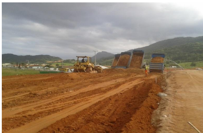
Figura 01 – Execução de corpo de aterro, km 212+100
