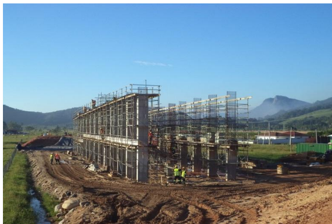
Figura 02 – Montagem de formas e ferragem dos Pilares, km 212+180
