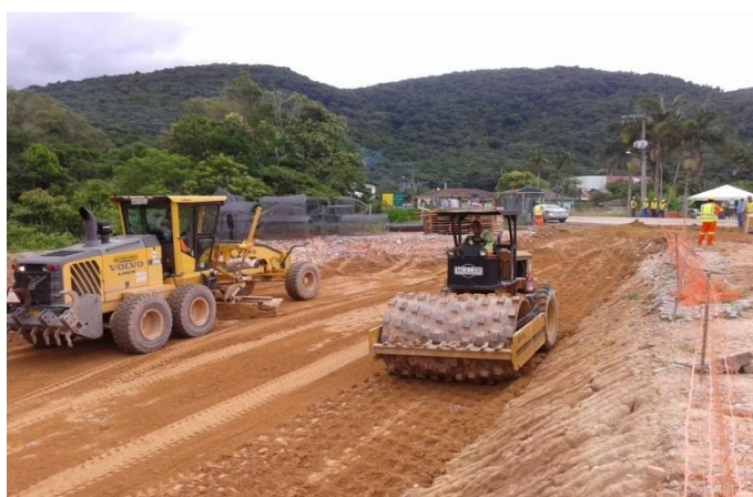
Figura 06 – Troca de solo para execução de Gabião, ramo 500, km 215+400
