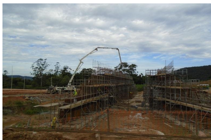
Figura 09 – Concretagem das paredes, km 213+720
