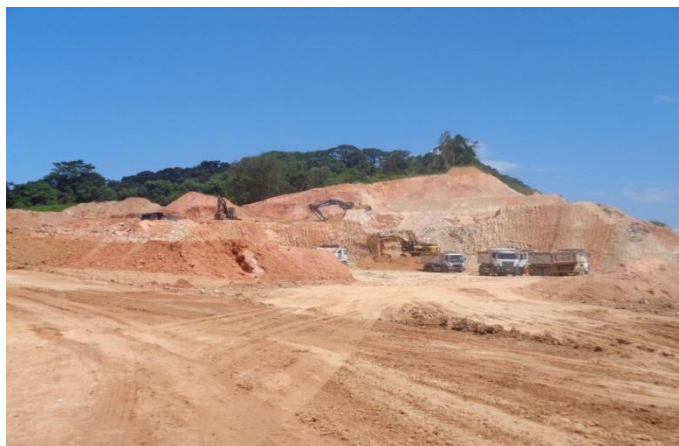
Figura 03 – Execução de escavação, carga e transporte-caixa de empréstimo, km 212+200
