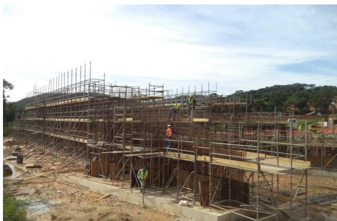
Figura 05 – Armação das Alas, km 213+720
