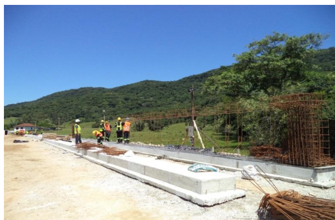
Figura 08 – Armação da Viga Longarina – Ponte Forquilha, km 213+340
