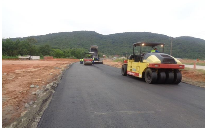
Figura 07 – Execução do Desvio de tráfego, km 215+400
