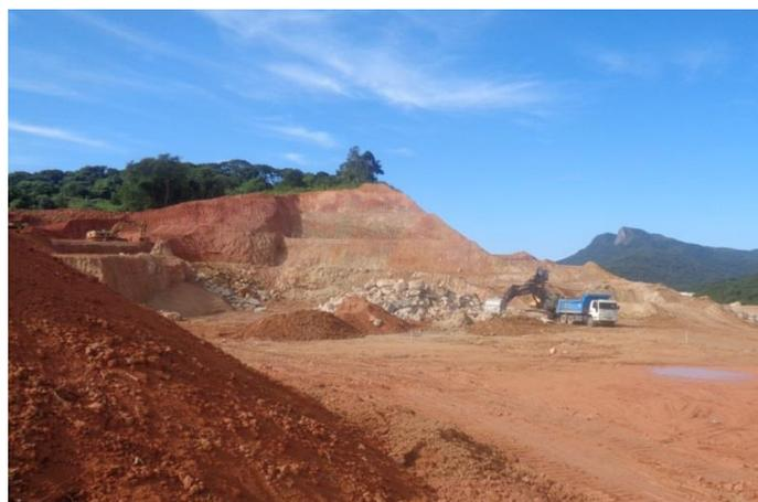
*Figura 02 – Execução de escavação, carga e transporte na jazida de empréstimo, km 214+100*
