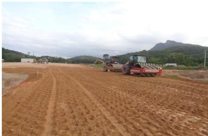
*Figura 01 – Execução de corpo de aterro, km 215+200*
