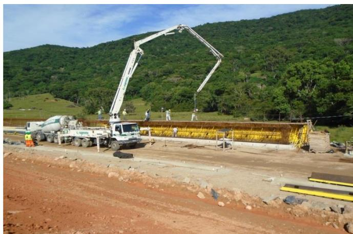
*Figura 05 – Concretagem das Vigas Longarinas - Ponte Forquilhas, km 212+340*
