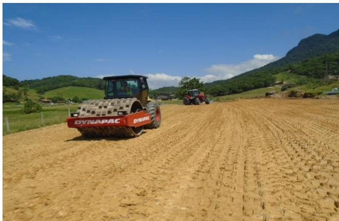
*Figura 10 – Compactação dos encontros da PSU - km 216+660*
