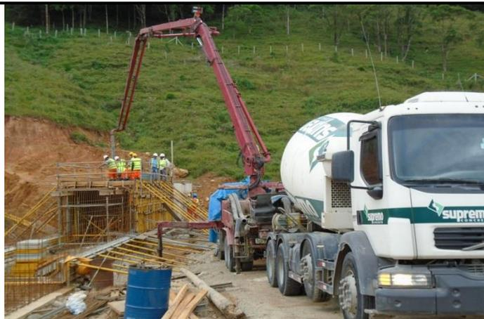
*Figura 04 – Concretagem da laje do Passa Fauna, km 214+380*
