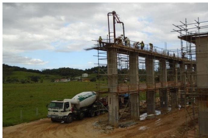
*Figura 06 – Concretagem da Viga Longarina de Apoio, km 212+180*
