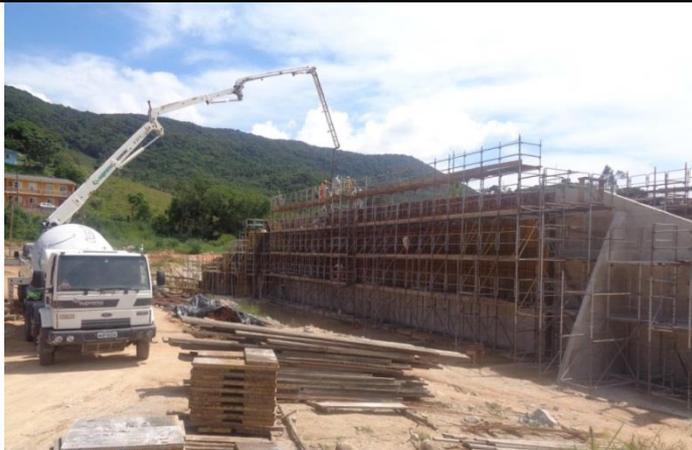
*Figura 07 – Concretagem da Parede, km 213+720*
