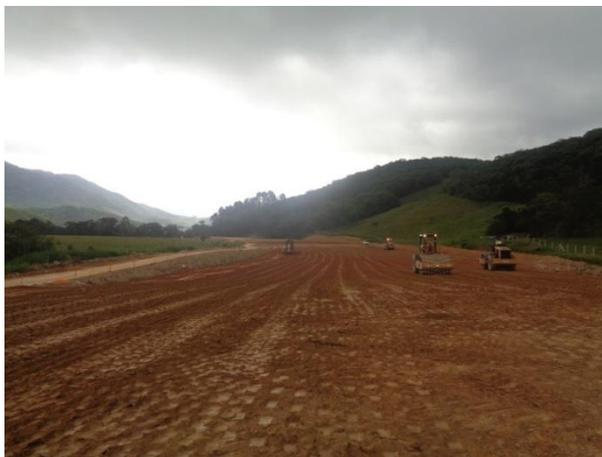
*Figura 02 – Execução de corpo de aterro, km 212+000*
