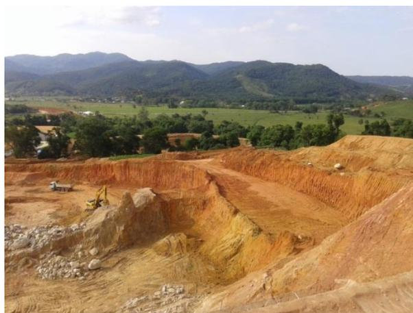
*Figura 03 – Execução de escavação, carga e transporte na jazida de empréstimo, km 214+000*
