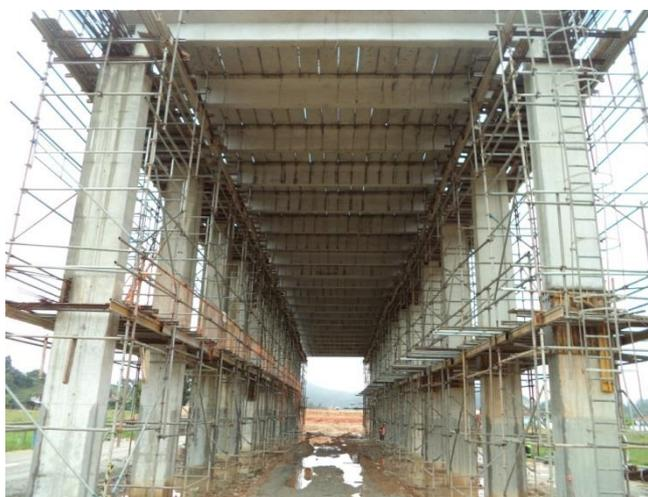
*Figura 06 – Lançamento das Vigas Transversinas e Pré Lajes - km 212+180*
