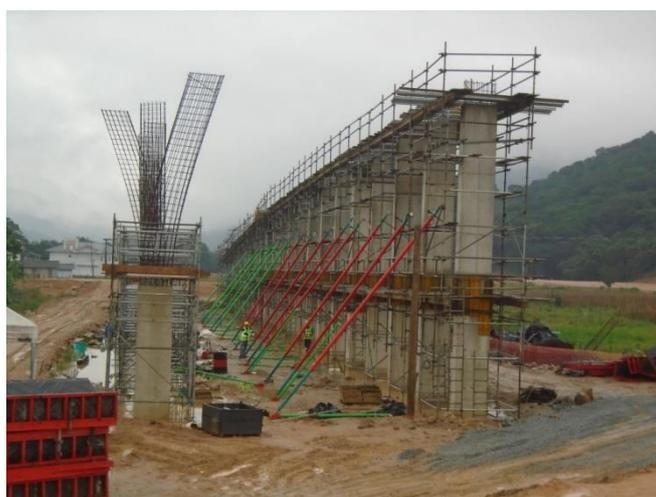
*Figura 07 – Montagem de formas e ferragem da Longarina de Apoio, km
