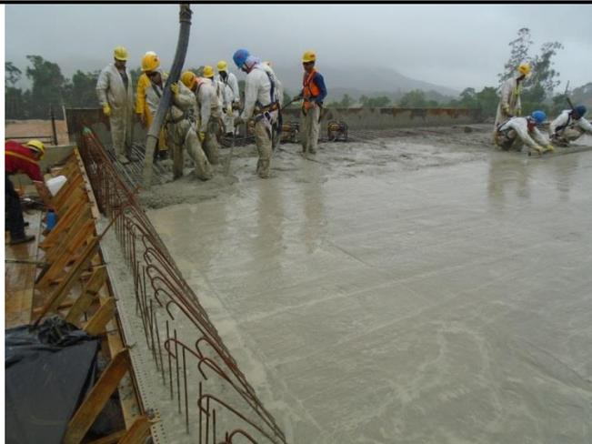
*Figura 08 – Concretagem da Laje Superior, km 213+720*
