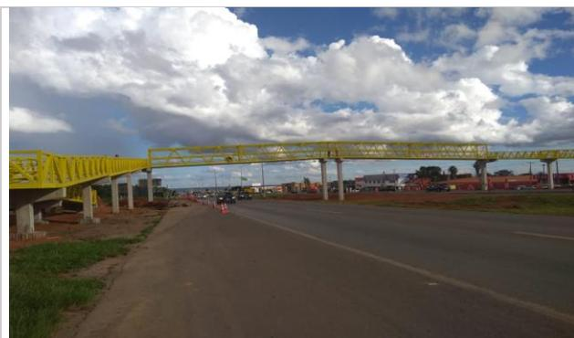
Foto 01: Passarela com travessia montada
