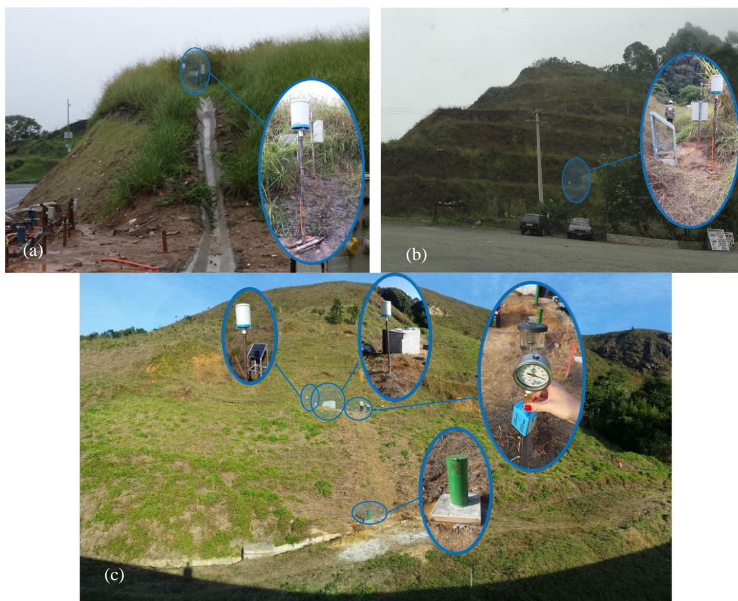
Figura 5 - Pontos de instalação dos equipamentos de monitoramento: (a) km 508+700 PS, (b) km 513+630 PS e (c) km 552 PN
