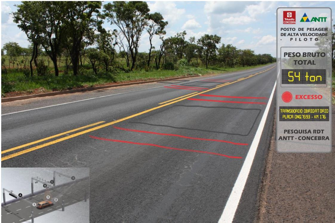
Figura 2 – Ilustração da proposta de PPAV a ser implantado na Concebra
