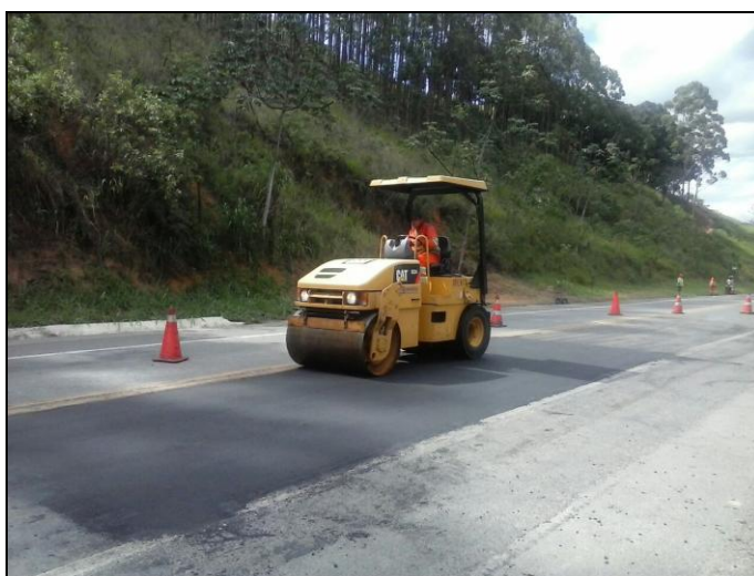
Figura 09 – Reparo no Pavimento Km 210
