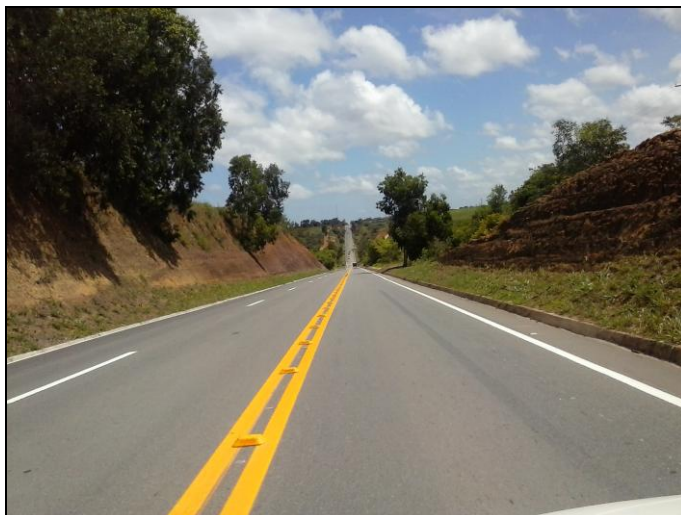
Figura 07 – Sinalização Horizontal Km 29+300
