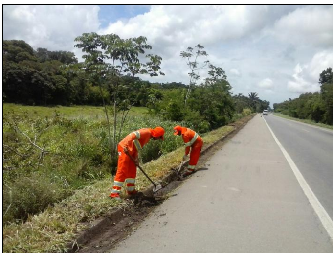
Figura 05 – Roçada e limpeza Km 156
