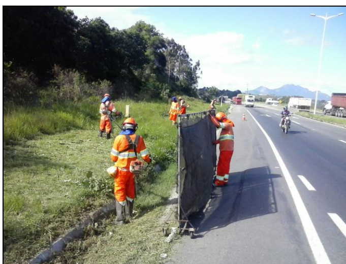
Figura 06 – Roçada e limpeza Km 282
