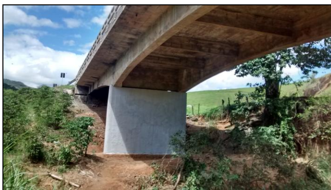
Figura 02 - Recuperação estrutura (Ponte Km 220+400)
