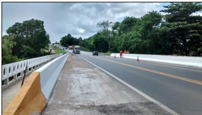
Figura 01 - Recuperação estrutura (Ponte Km 203+500)
