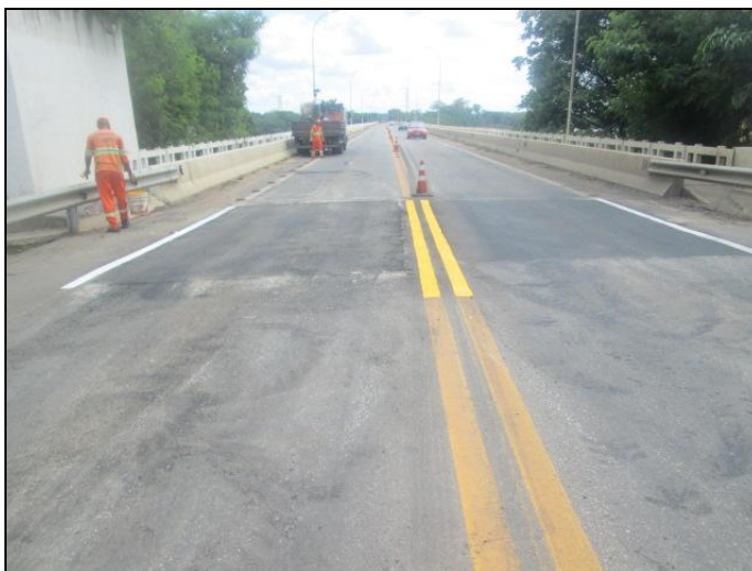
Figura 08 – Reparo no Pavimento Km 150+600
