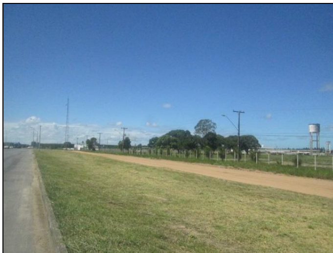
Figura 04 – Roçada e limpeza Km 68
