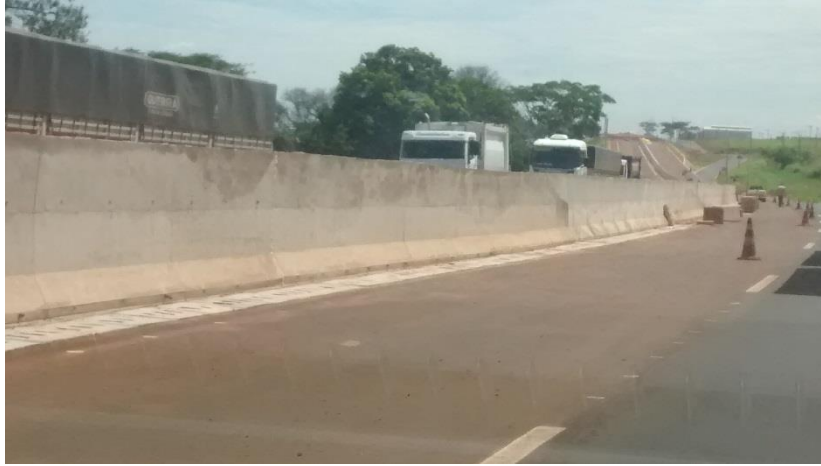
Figura 01 – Execução das canaletas retangulares DR-7-A.
