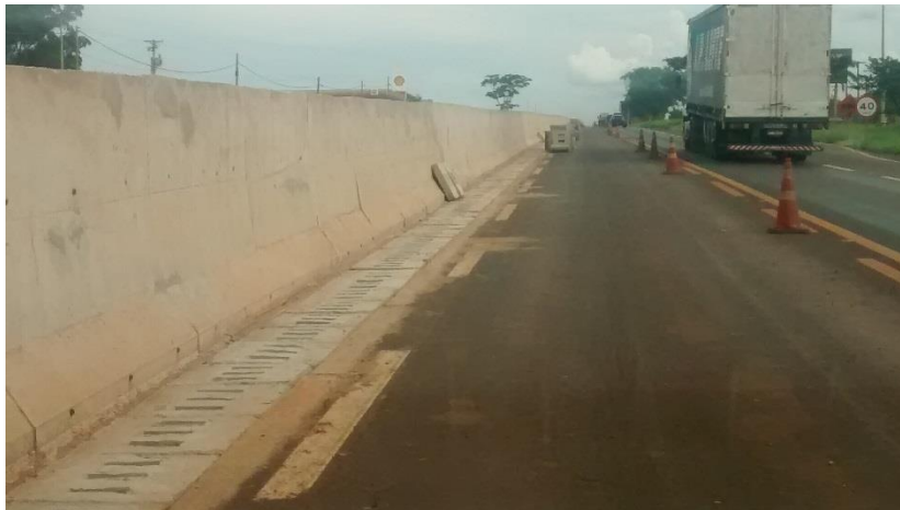
Figura 02 – Execução das canaletas retangulares DR-7-A.
