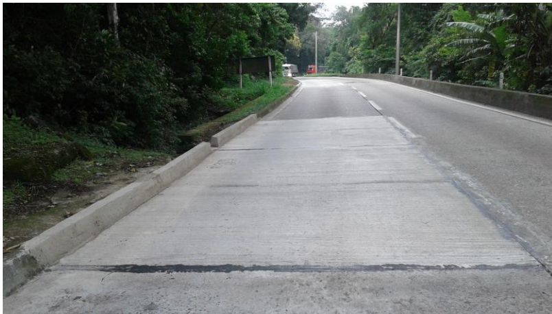
Figura 1 - Recuperação do pavimento rígido, km 86 JF.
