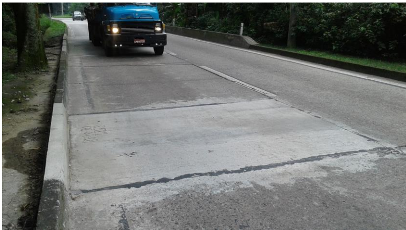
Figura 2 – Recuperação do pavimento rígido, km 86 JF.
