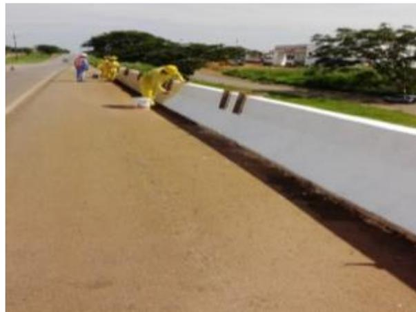
*Figura 8 - Limpeza de buzinete e reparo de guarda-corpo (OAE km 670+500)*
