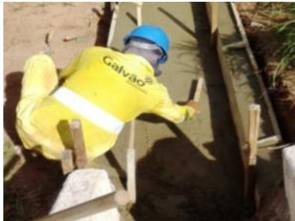
*Figura 11 - Recuperação de elementos de drenagem (km 619+200)*
