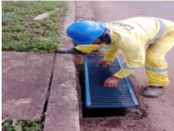
*Figura 10 - Recuperação de elementos de drenagem (km 619+200)*
