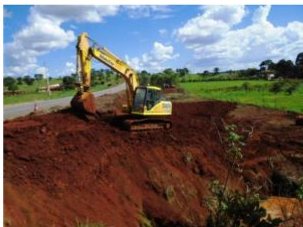
Figura 18 - Recuperação de área erodida (km 304+000)
