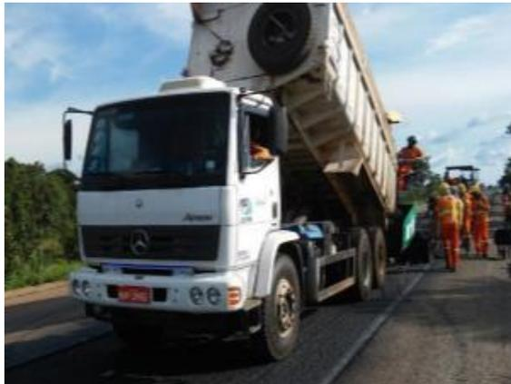
*Figura 2 - Recuperação do pavimento (km 681+000)*
