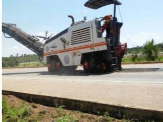
*Figura 1 - Recuperação do pavimento (km 681+000)*
