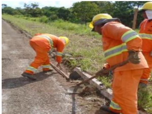
*Figura 12 - Limpeza e desobstrução de canaletas (km 39+100)*
