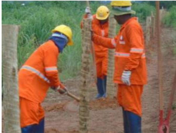
Figura 13 - Instalação de cercas (km 761+500)
