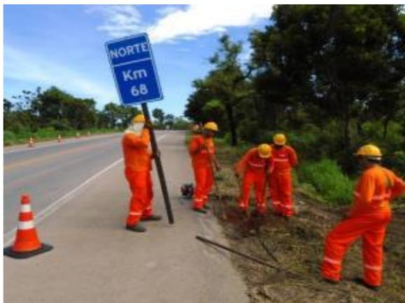
Figura 4 - Instalação de sinalização vertical (km 68+000)
