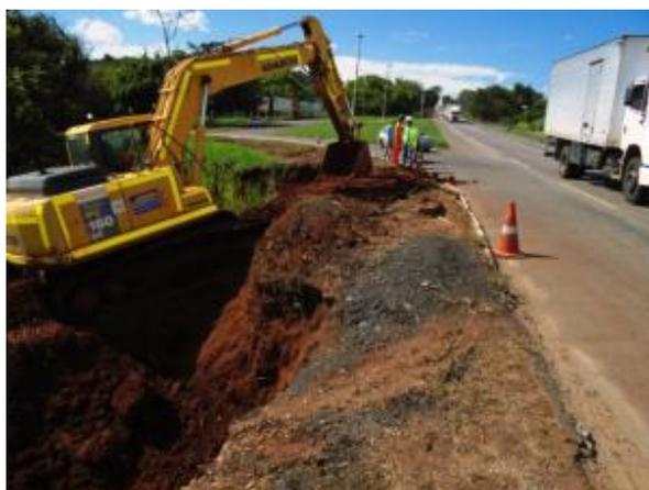
Figura 17 - Recuperação de área erodida (km 304+000)
