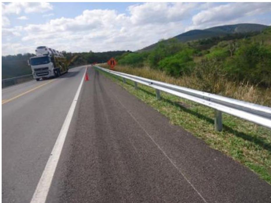
*Figura 07 – Implantação de Defensas Metálicas*
