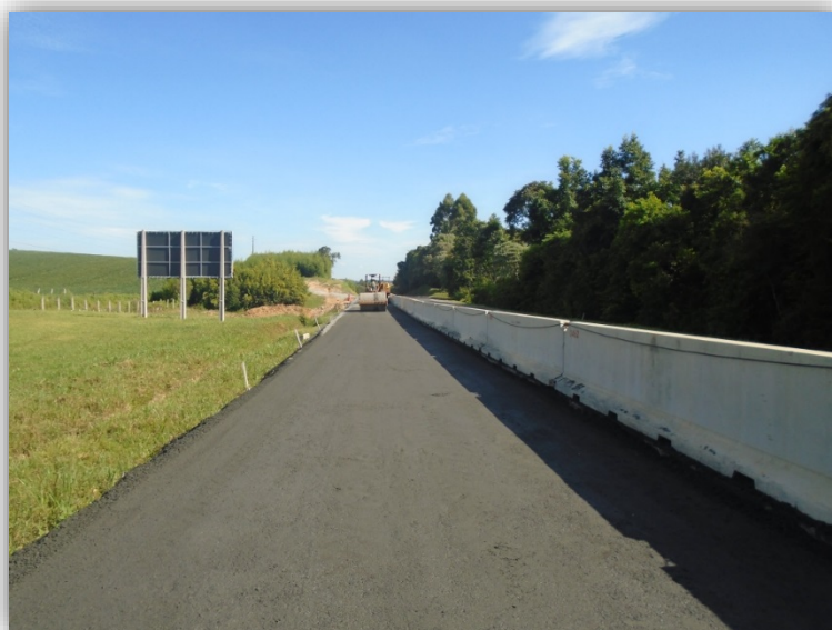
Figura 08 – Execução de Terceiras Faixas – km 068,005 ao 066,555
