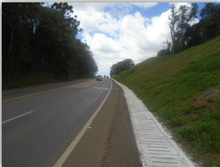
Figura 03 – Execução de Terceiras Faixas – km 134,920 ao 137,920 - Concluído
