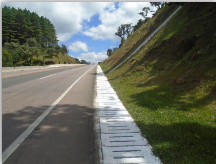
Figura 01 – Execução de Terceiras Faixas – km 114,580 ao 116,300 – Concluído
