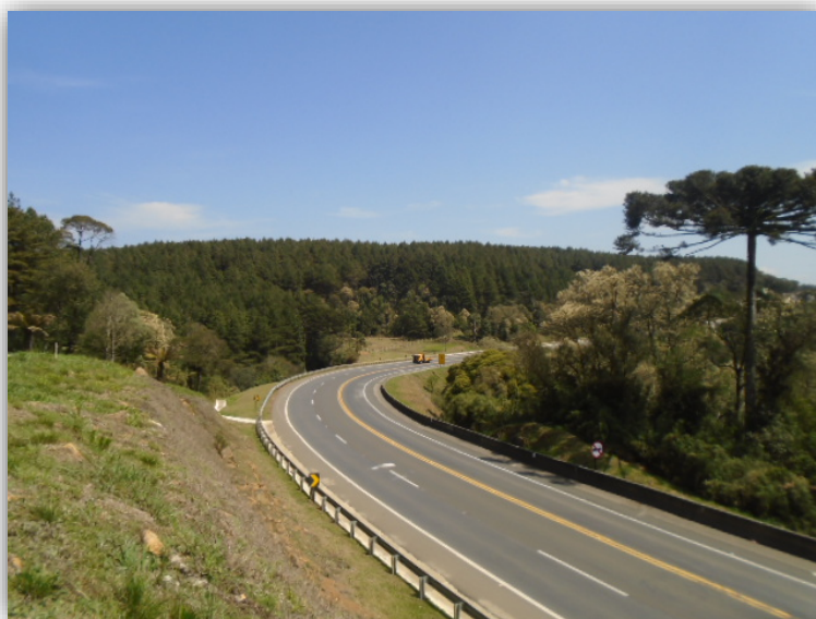
Figura 02 – Execução de Terceiras Faixas – km 115,265 ao 117,720
