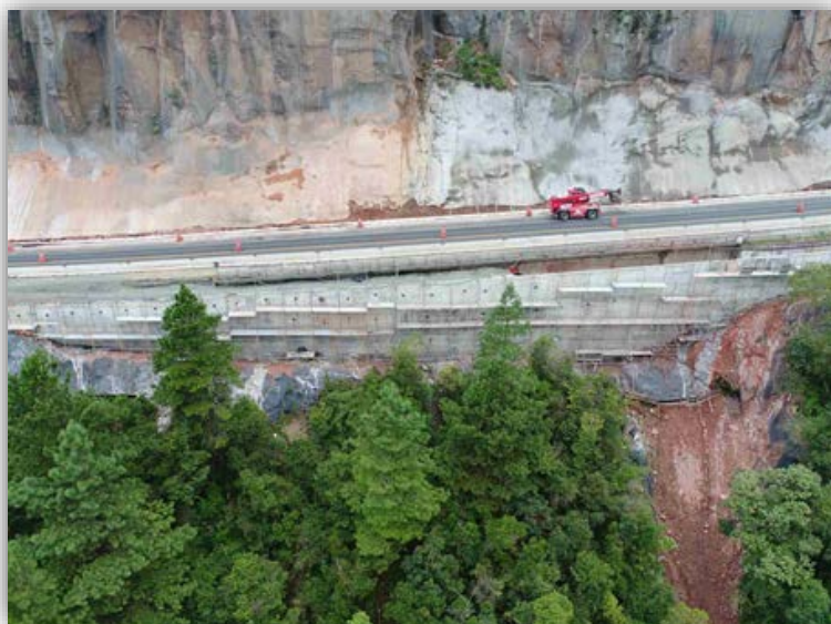
Figura 05 – Serra do Espigão – km 108,600 ao 108,690 (S)
