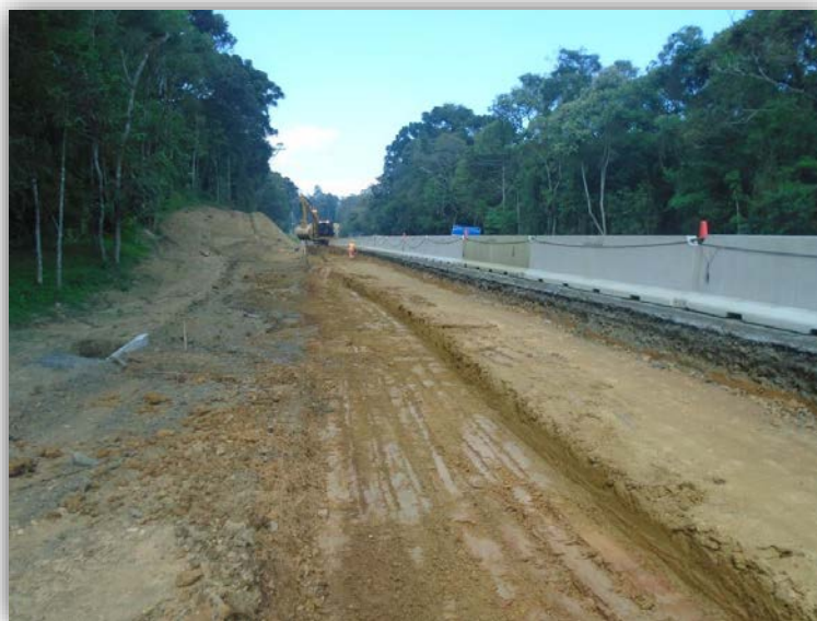
Figura 05 – Execução de Terceiras Faixas – km 012,097 ao 010,705
