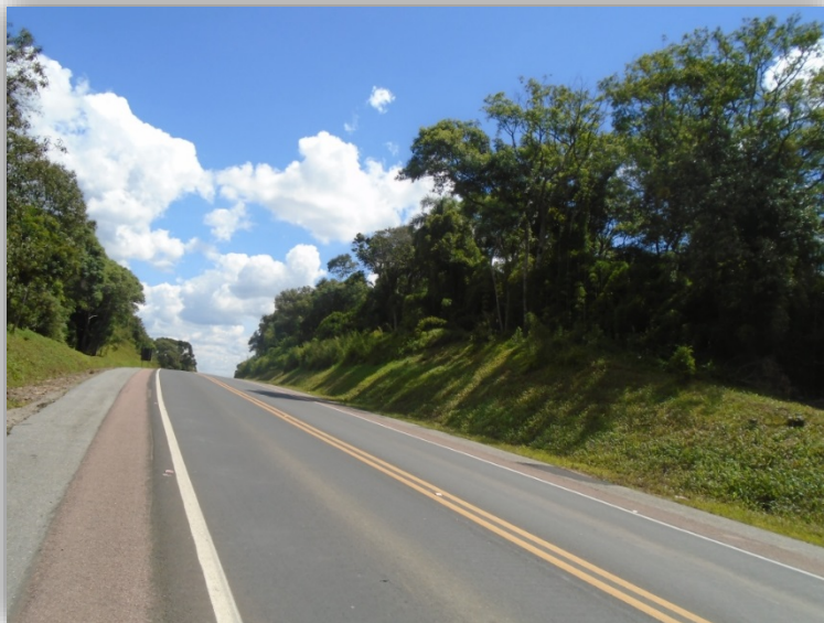
Figura 07 – Execução de Terceiras Faixas – km 014,775 ao 015,880
