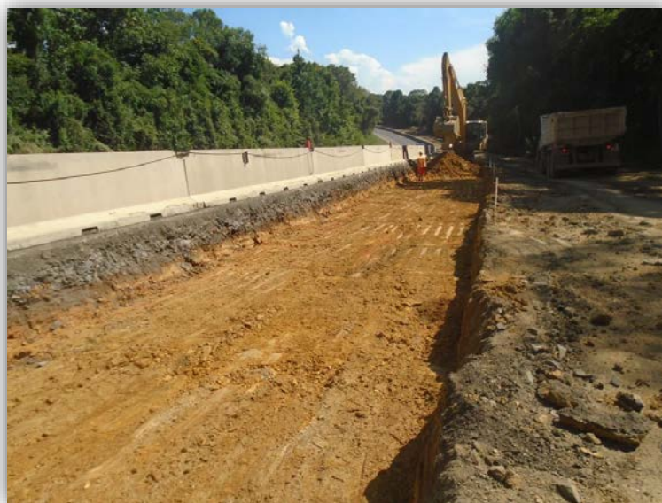
Figura 04 – Execução de Terceiras Faixas – km 009,646 ao 010,295
