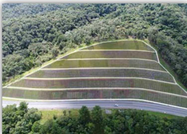
Figura 01 – Serra do Espigão – km 103,470 ao 103,700 (N) - Concluído
