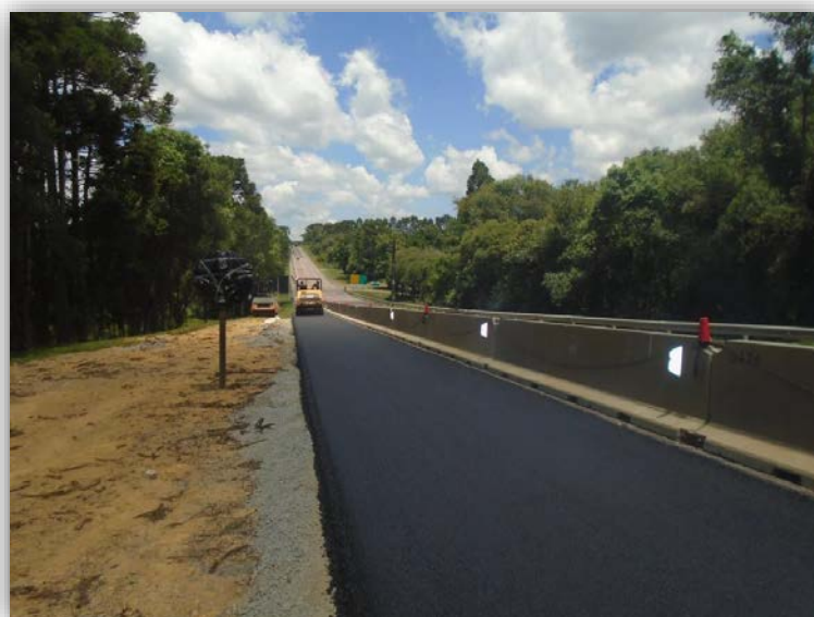
Figura 06 – Execução de Terceiras Faixas – km 013,575 ao 014,705
