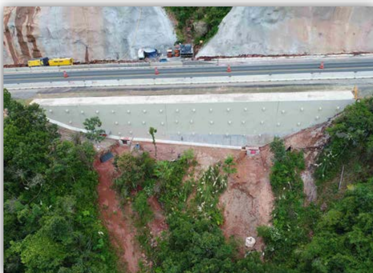
Figura 04 – Serra do Espigão – km 108,490 ao 108,540 (S)
