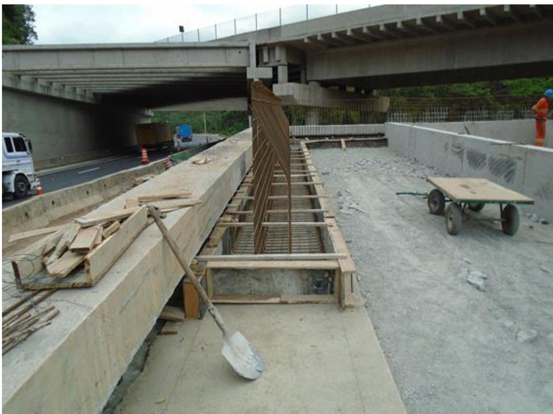
*Figura 3 – Armação, forma e concretagem do muro – Área de Escape Km 353+000*
