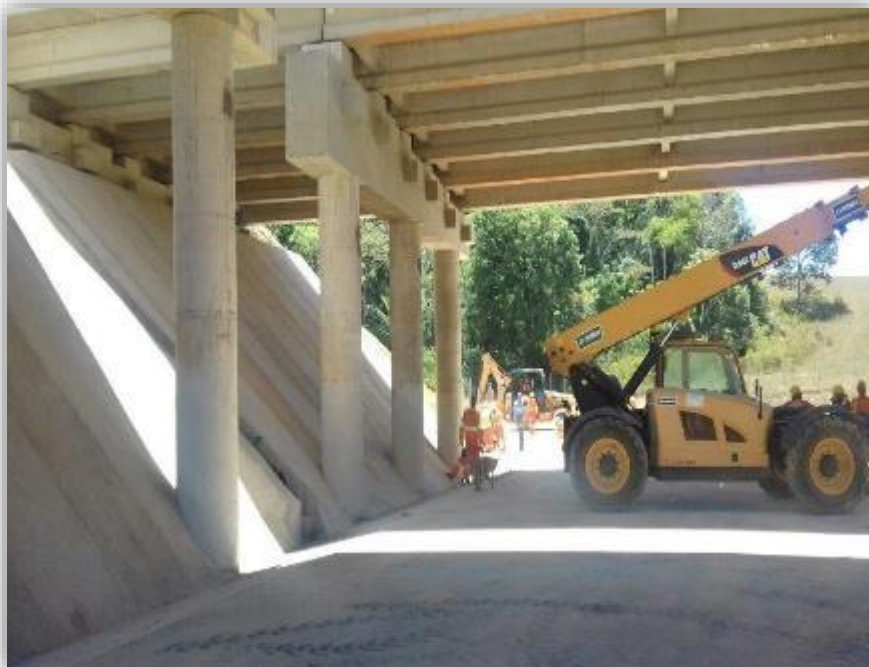
Figura 03 – Proteção do talude de encontro – km 122,100
