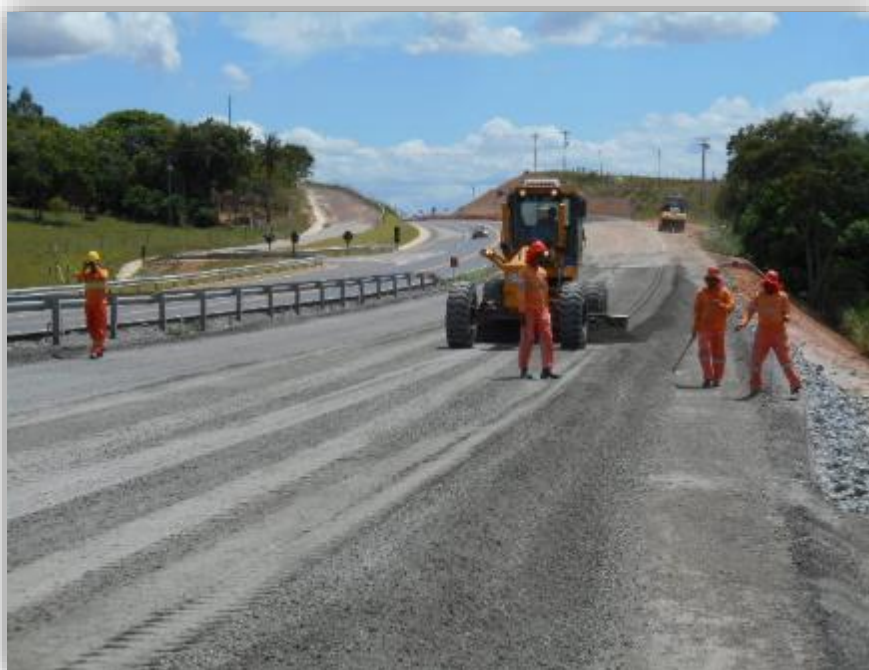
Figura 02 – Pavimentação - base
