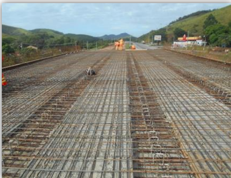
Figura 06 – Armação da laje – km 248,1
