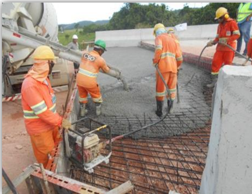
Figura 05 – Concretagem da laje de aproximação – km 244
