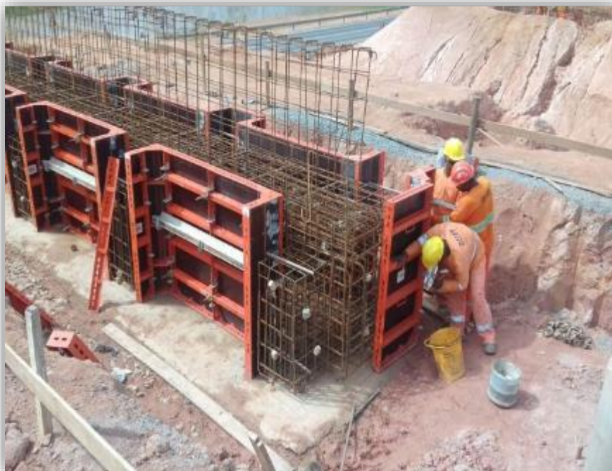
Figura 01 – Forma dos blocos de encontro – km 92,800
