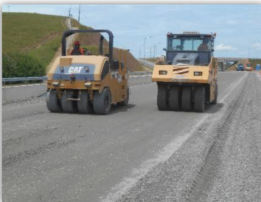
Figura 02 – Pavimentação - base
