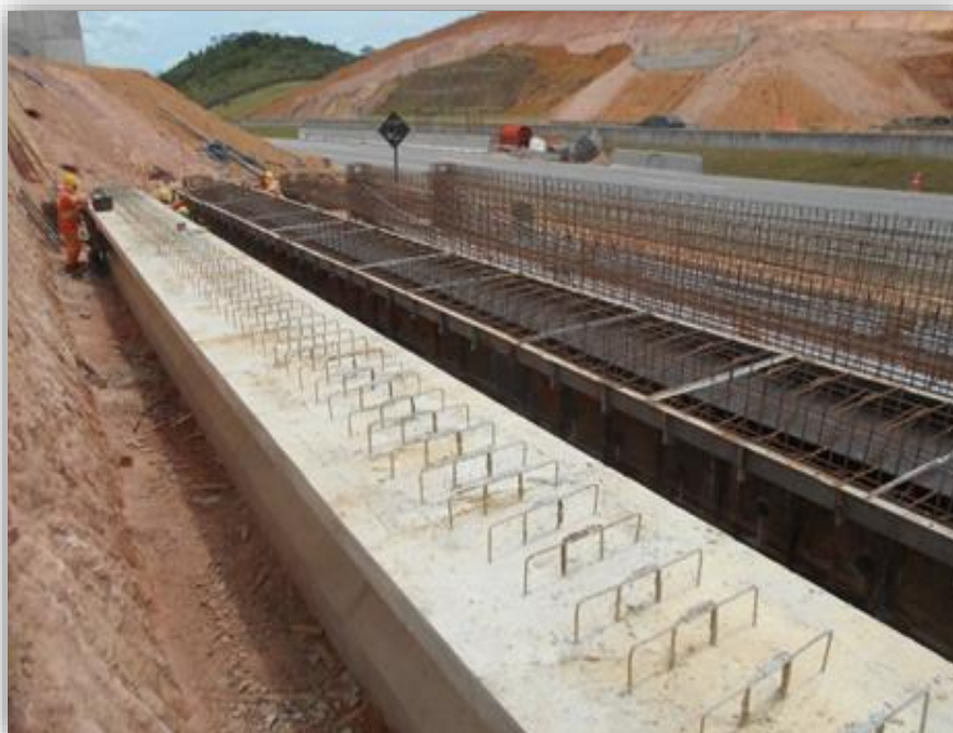
Figura 04 – Armação e forma das vigas longarinas – km 194
