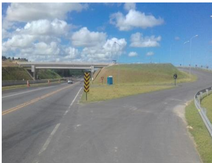
Figura 02 – Vista geral – km 101,100
