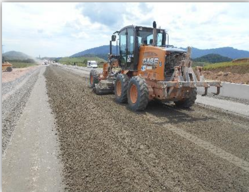
Figura 01 – Pavimentação - base
