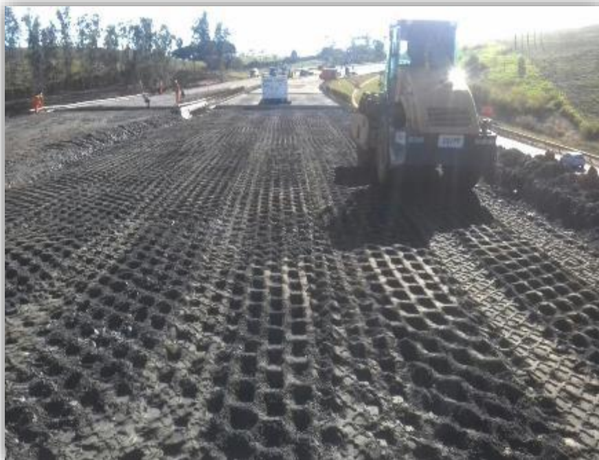
Figura 01 – Pavimentação – BGS – km 92,800
