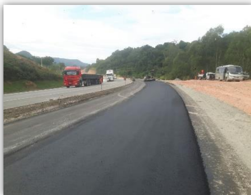
Figura 02 – Pavimentação – CBUQ
