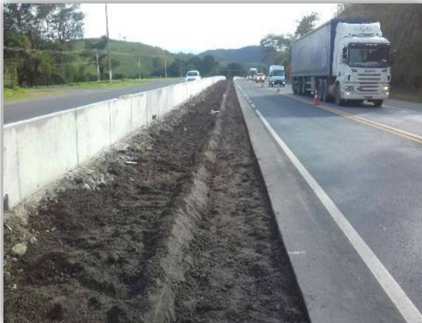
Figura 01 – Drenagem do canteiro central
