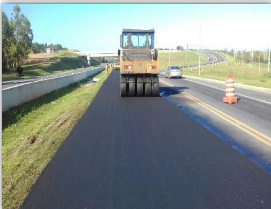
Figura 02 – Pavimentação – CBUQ
