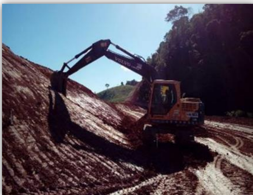
Figura 08 – Aterro de elevação do greide – km 248,1
