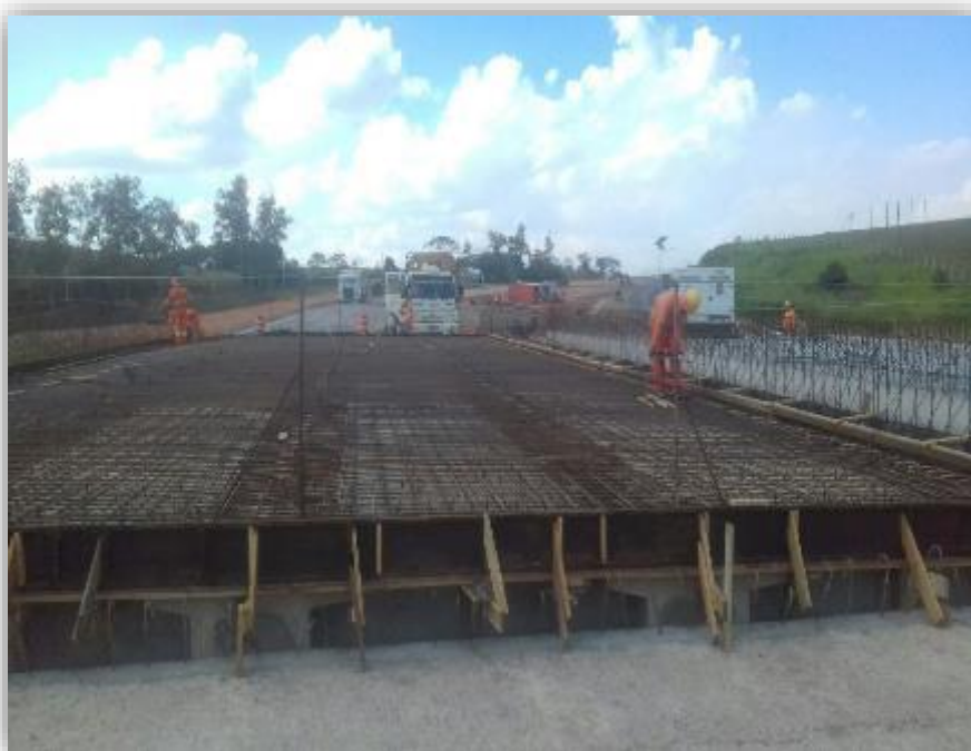
Figura 02 – Armação de laje – km 92,800
