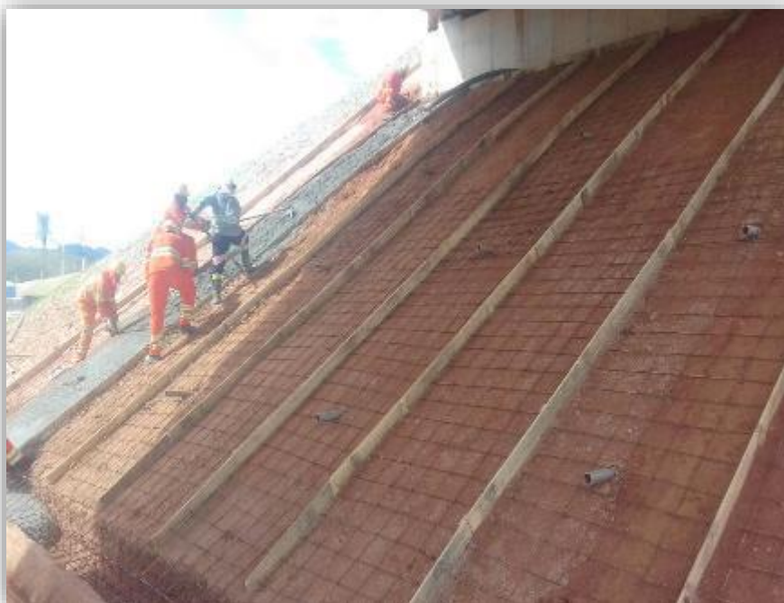
Figura 04 – Armação da proteção de talude – km 194
