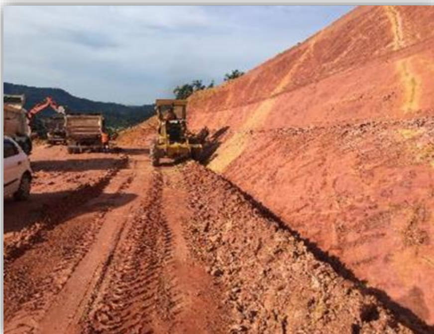
Figura 06 – Aterro de elevação do greide – km 244
