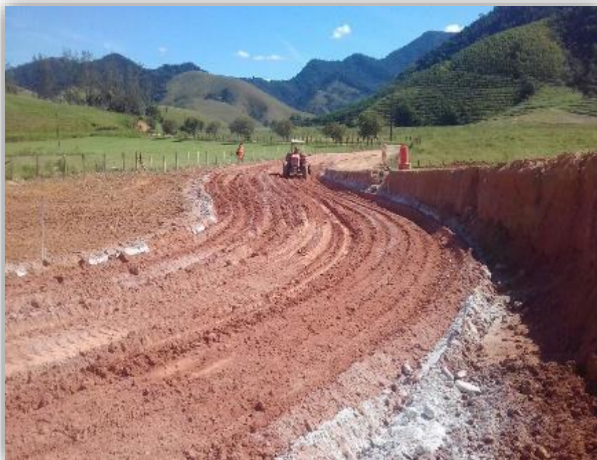
Figura 03 – Aplicação de Solocal – km 194
