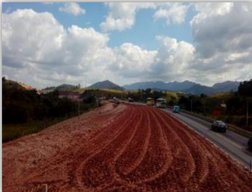
Figura 05 – Aterro de elevação do greide – km 244
