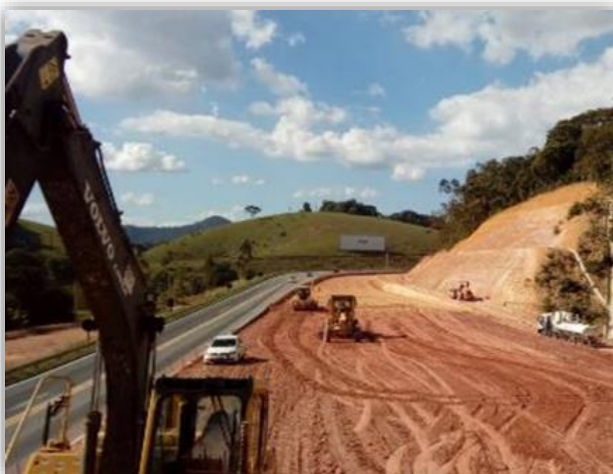
Figura 07 – Aterro de elevação do greide – km 248,1
