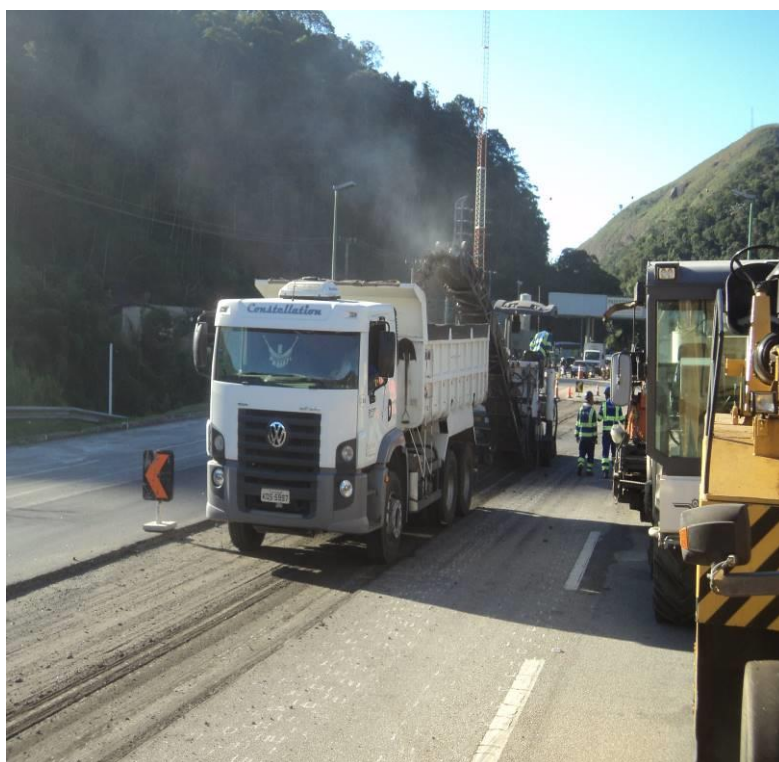
Reconstrução do Pavimento – Km 71,0 – P2 – Execução da Fresagem
