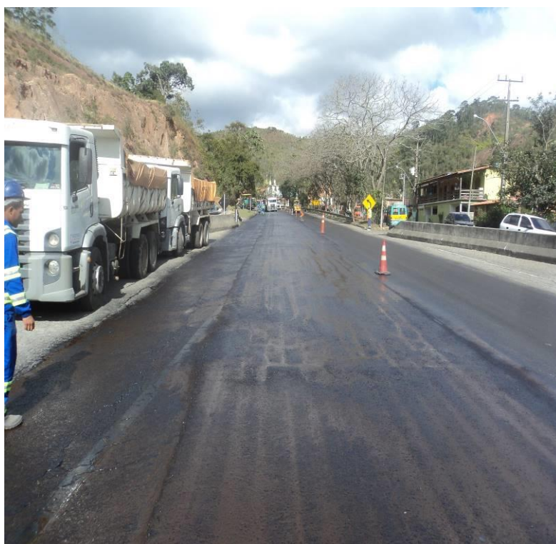
Reconstrução do Pavimento – Km 71,3 – P2 – Aplicação de CBUQ – Pintura de ligação
