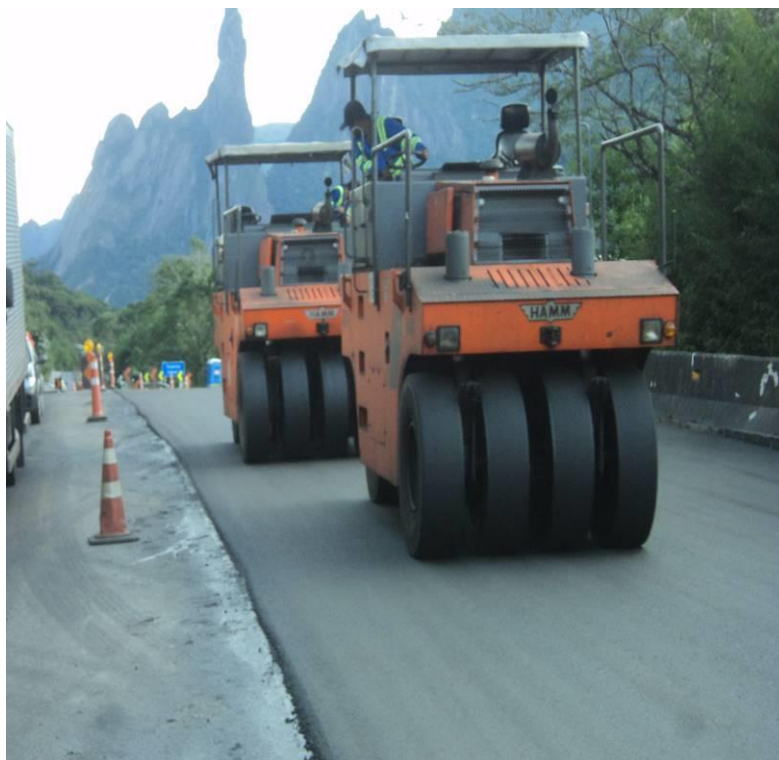
Reconstrução do Pavimento – Km 88,5 – P1 – Rolagem de CBUQ - Capa
