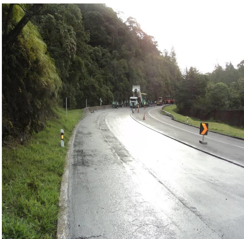
Reconstrução do Pavimento Km 87,3 – P2 - Aplicação de CBUQ – Pintura de ligação
