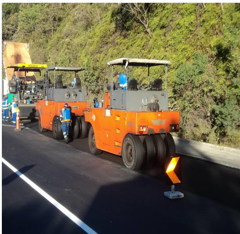
Reconstrução do Pavimento – Km 87,6 – P2 - Aplicação de CBUQ - Binder
