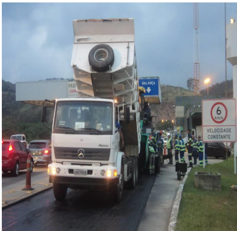
Reconstrução do Pavimento – Km 70,9 – P2 – Aplicação de CBUQ
