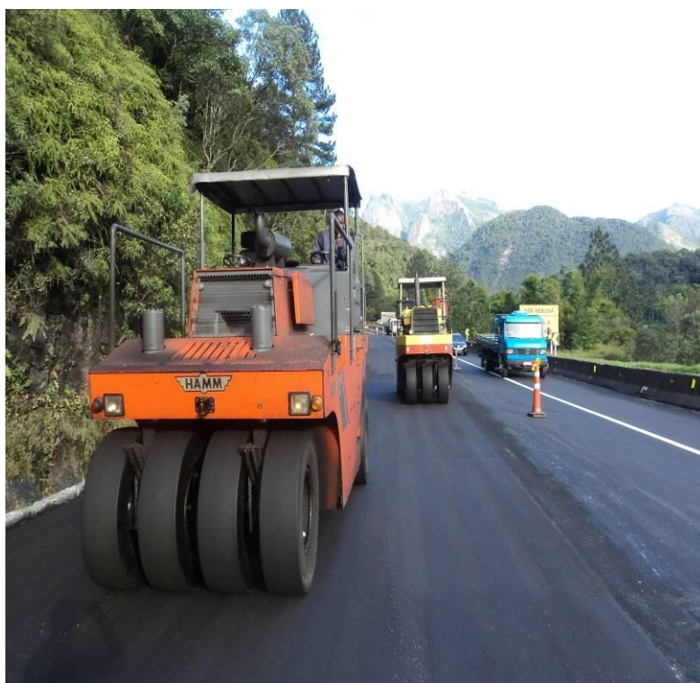
Reconstrução do Pavimento – Km 87,5 – P2 – Rolagem de CBUQ - Capa
