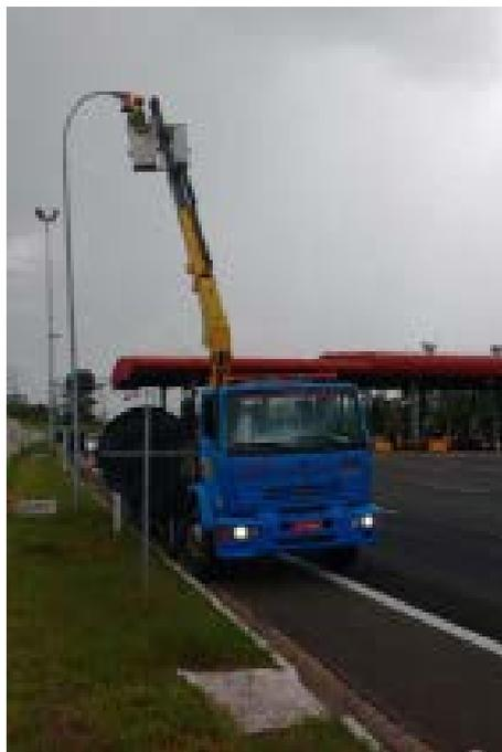
*Figura 65 - MANUTENÇÃO DAS CÂMERAS E ILUMINAÇÃO AO LONGO DA RODOVIA*
