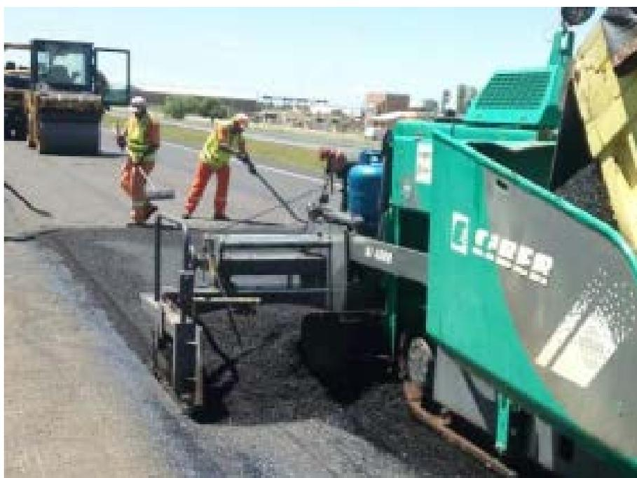
*Figura 49 - MELHORIAS AO LONGO DA RODOVIA - RECAPEAMENTO ASFÁLTICO DO PAVIMENTO*
