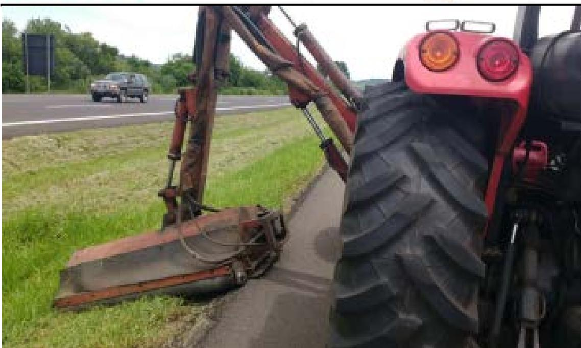
*Figura 76 – CONSERVAÇÃO/MANUTENÇÃO – ROÇADA MECANIZADA*
