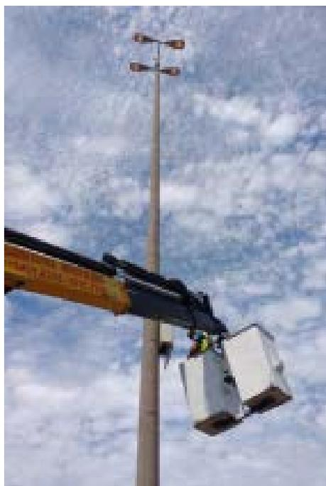
*Figura 69 - MANUTENÇÃO DAS CÂMERAS E ILUMINAÇÃO AO LONGO DA RODOVIA*
