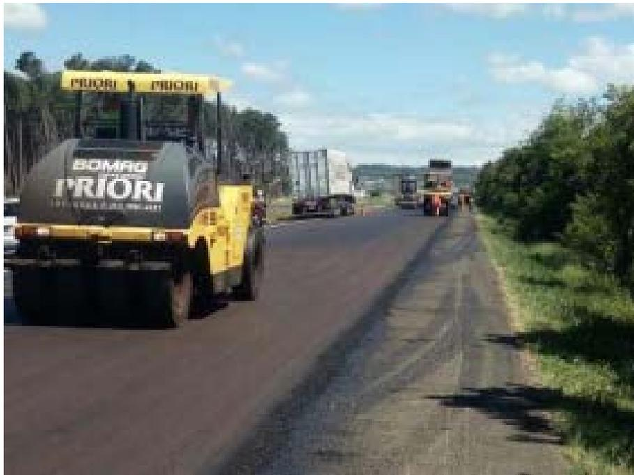
*Figura 50 - MELHORIAS AO LONGO DA RODOVIA - RECAPEAMENTO ASFÁLTICO DO PAVIMENTO*
