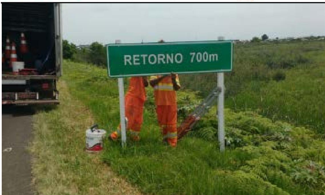
*Figura 80 – CONSERVAÇÃO/MANUTENÇÃO – IMPLANTAÇÃO E ALINHAMENTO DE PLACAS DE SINALIZAÇÃO VERTICAL*
