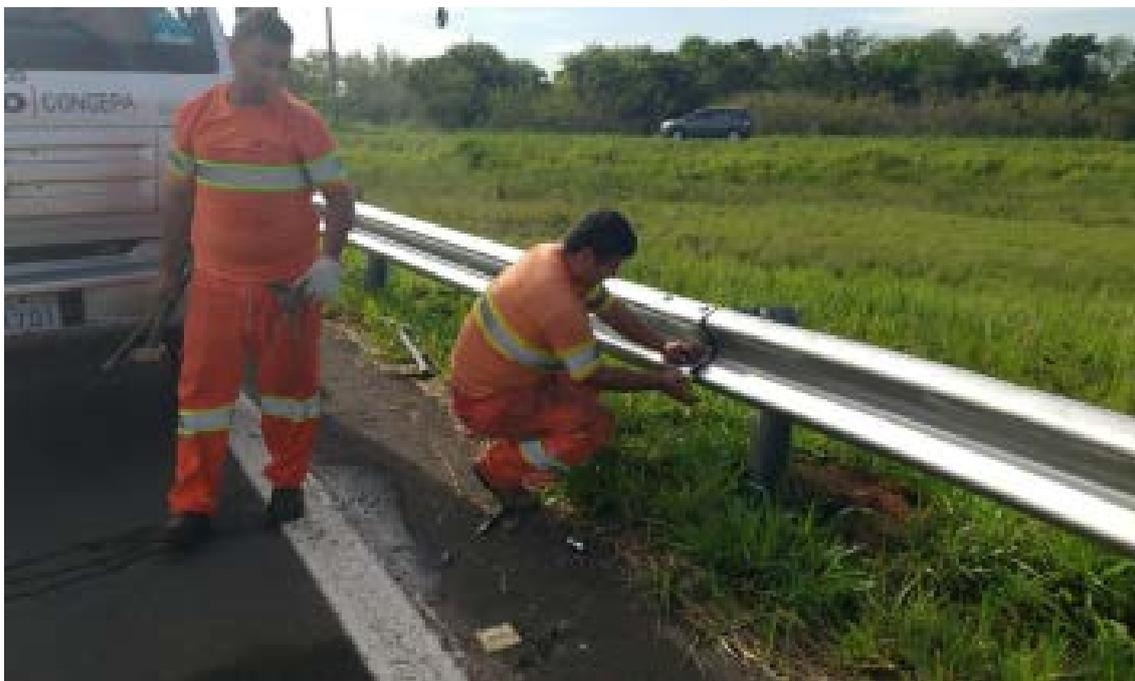
*Figura 88 – CONSERVAÇÃO/MANUTENÇÃO – RECOMPOSIÇÃO DE DEFENSAS METÁLICAS*
