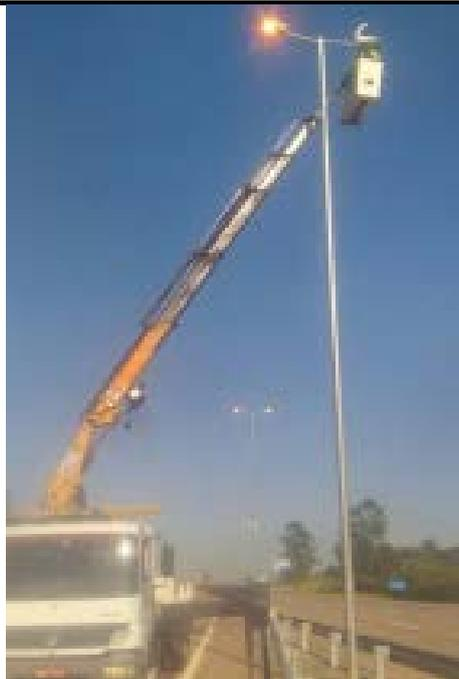
*Figura 68 - MANUTENÇÃO DAS CÂMERAS E ILUMINAÇÃO AO LONGO DA RODOVIA*
