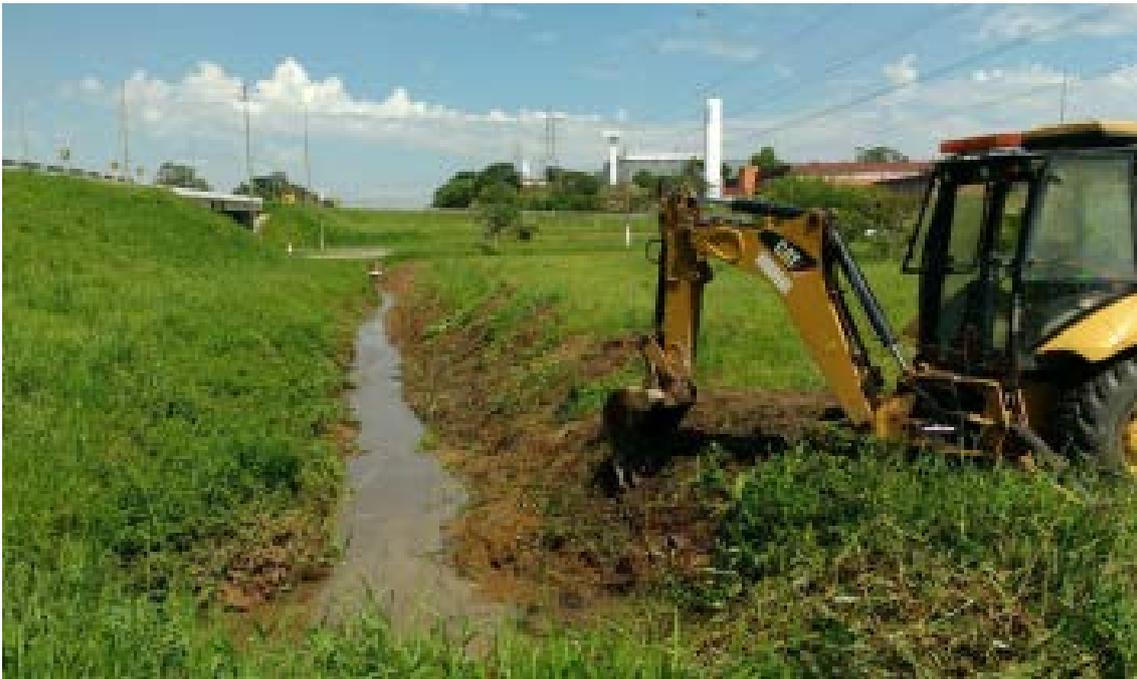
*Figura 92 – CONSERVAÇÃO/MANUTENÇÃO – LIMPEZA DE VALO DE DRENAGEM*
