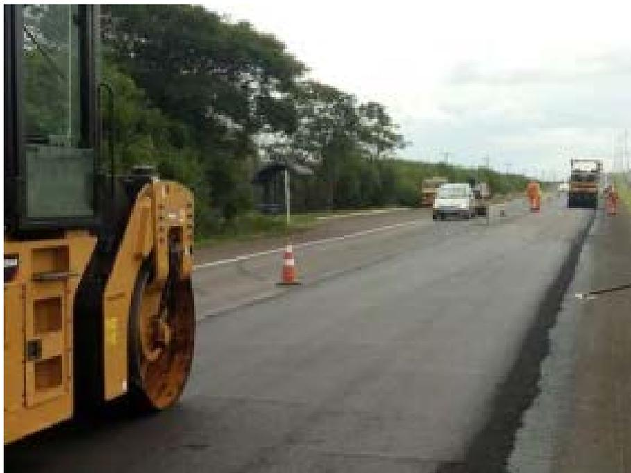
*Figura 48 - MELHORIAS AO LONGO DA RODOVIA - RECAPEAMENTO ASFÁLTICO DO PAVIMENTO*
