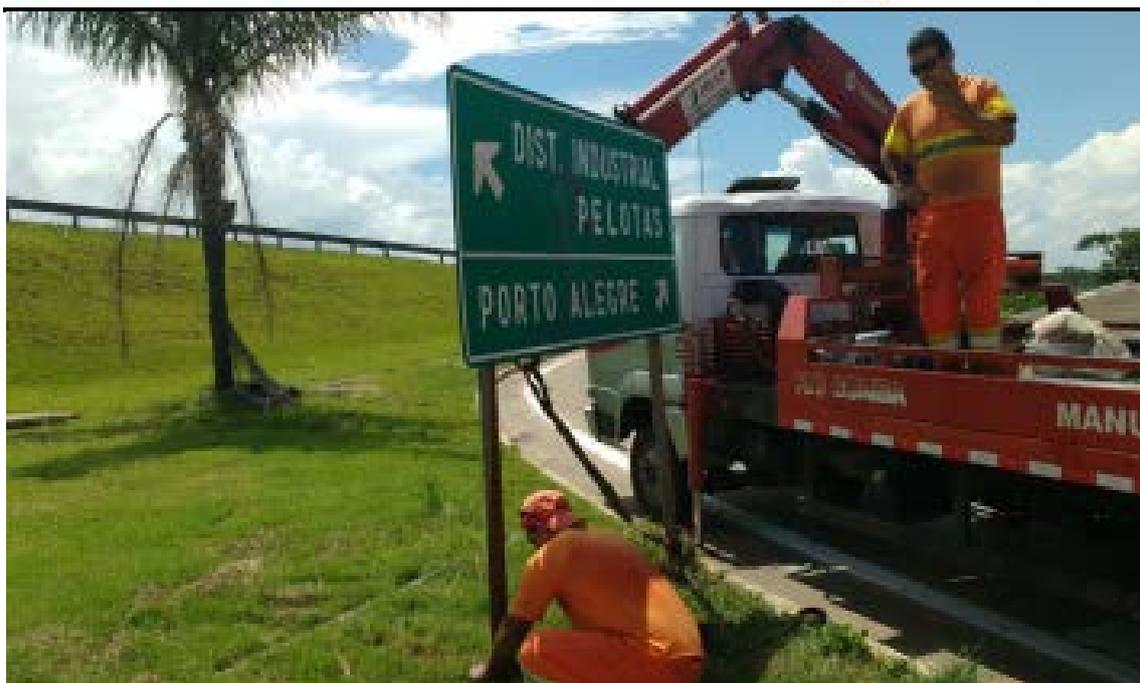
*Figura 84 – CONSERVAÇÃO/MANUTENÇÃO – IMPLANTAÇÃO E ALINHAMENTO DE PLACAS DE SINALIZAÇÃO VERTICAL*
