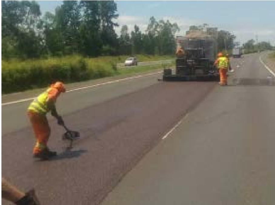
*Figura 54 - MELHORIAS AO LONGO DA RODOVIA - APLICAÇÃO DE MICRO REVESTIMENTO ASFÁLTICO*
