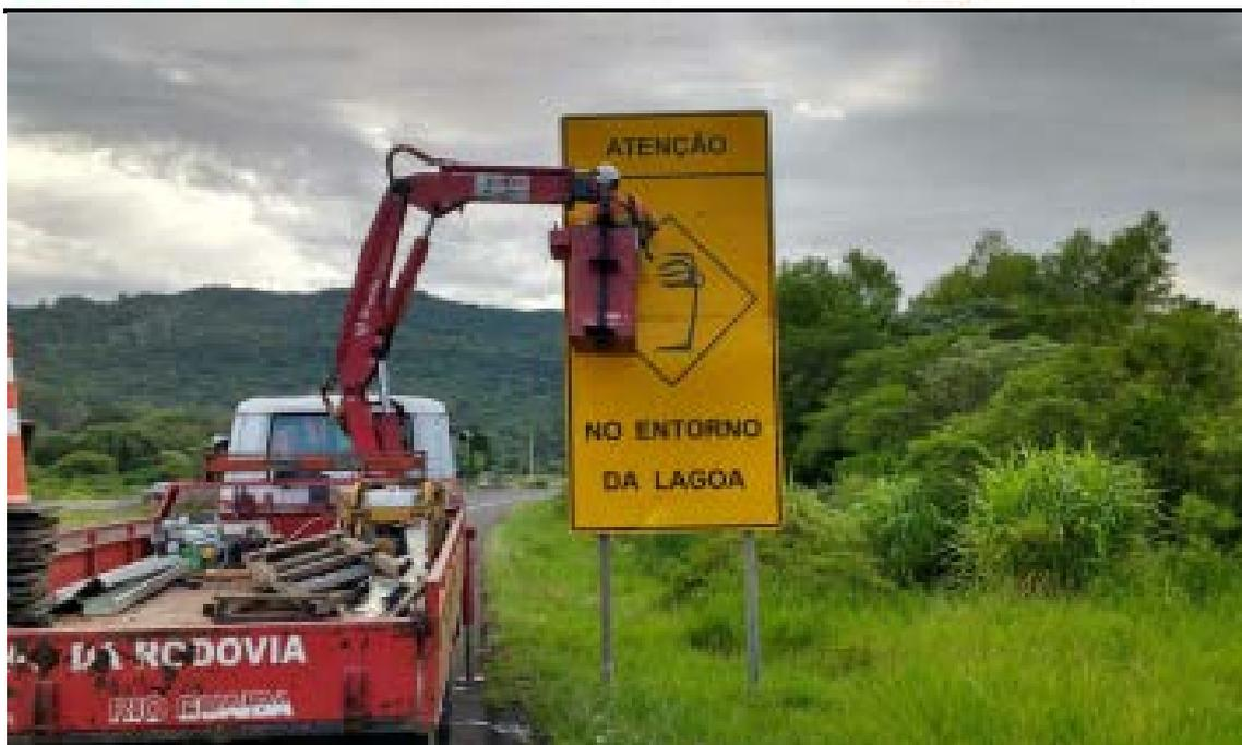
*Figura 82 – CONSERVAÇÃO/MANUTENÇÃO – IMPLANTAÇÃO E ALINHAMENTO DE PLACAS DE SINALIZAÇÃO VERTICAL*
