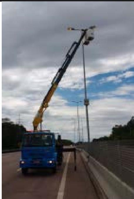
*Figura 66 - MANUTENÇÃO DAS CÂMERAS E ILUMINAÇÃO AO LONGO DA RODOVIA*
