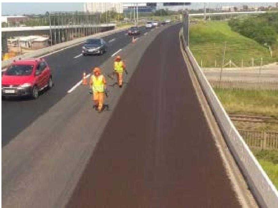
*Figura 55 - MELHORIAS AO LONGO DA RODOVIA - APLICAÇÃO DE MICRO REVESTIMENTO ASFÁLTICO*
