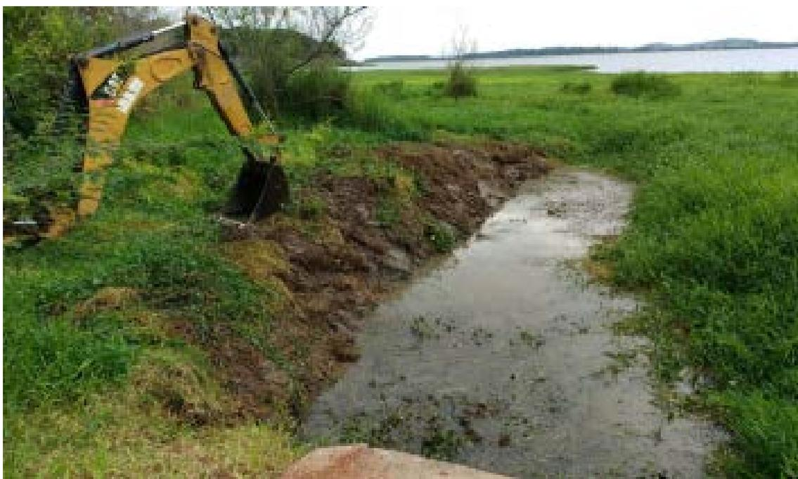
*Figura 89 – CONSERVAÇÃO/MANUTENÇÃO – LIMPEZA DE VALO DE DRENAGEM*
