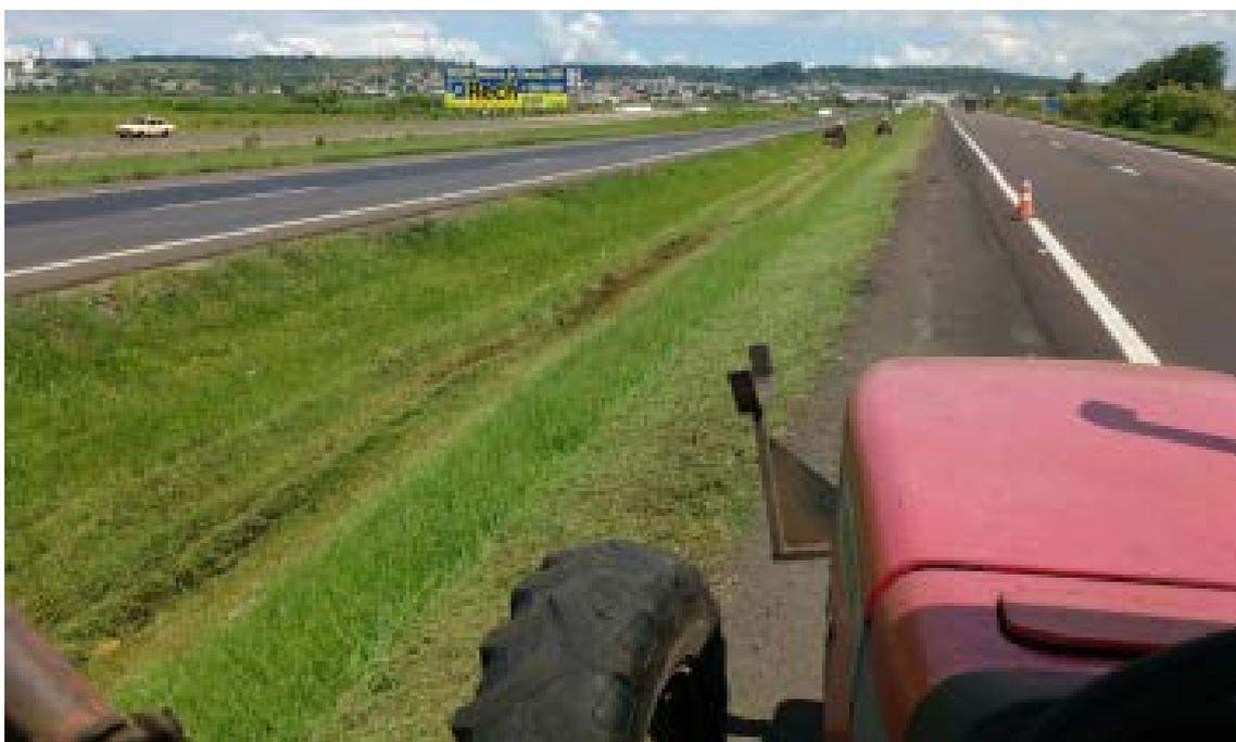
*Figura 77 – CONSERVAÇÃO/MANUTENÇÃO – ROÇADA MECANIZADA*
