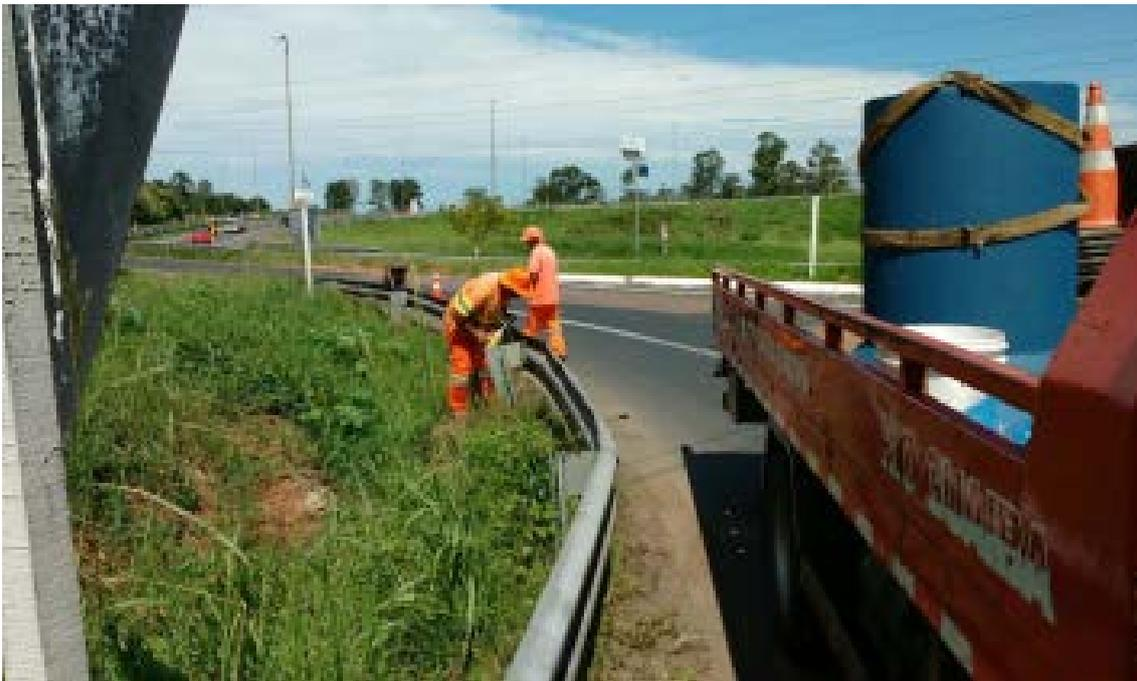
*Figura 86 – CONSERVAÇÃO/MANUTENÇÃO – RECOMPOSIÇÃO DE DEFENSAS METÁLICAS*
