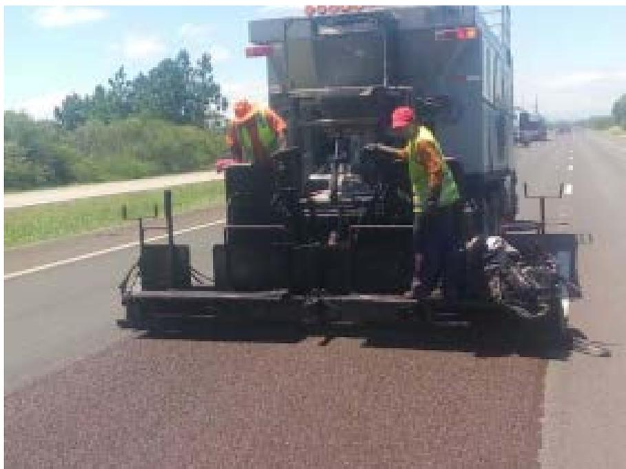
*Figura 57 - MELHORIAS AO LONGO DA RODOVIA - APLICAÇÃO DE MICRO REVESTIMENTO ASFÁLTICO*
