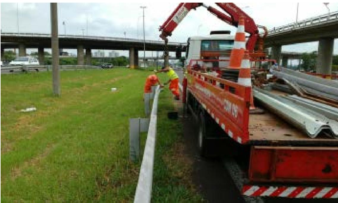
*Figura 87 – CONSERVAÇÃO/MANUTENÇÃO – RECOMPOSIÇÃO DE DEFENSAS METÁLICAS*
