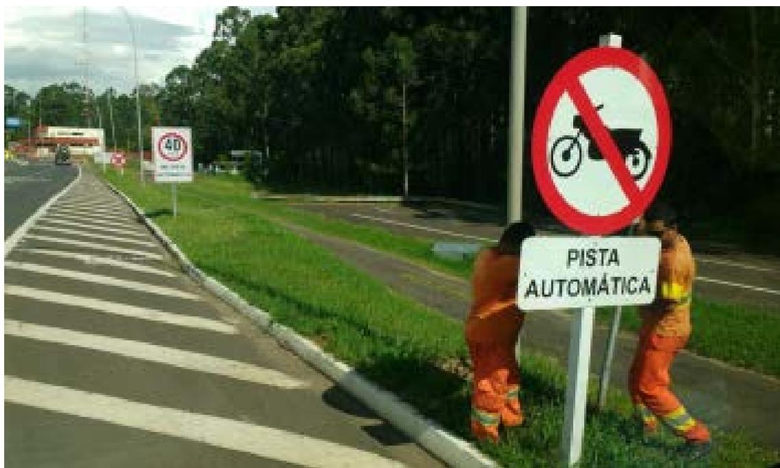
*Figura 83 – CONSERVAÇÃO/MANUTENÇÃO – IMPLANTAÇÃO E ALINHAMENTO DE PLACAS DE SINALIZAÇÃO VERTICAL*
