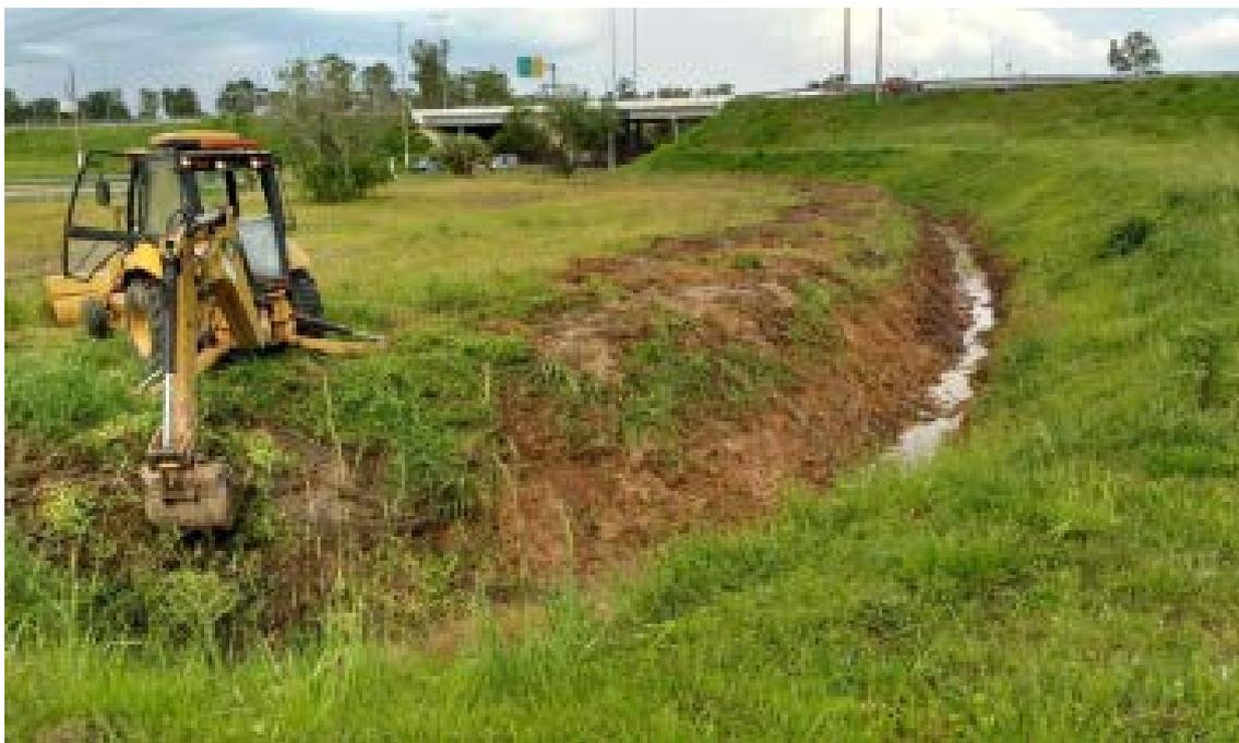
*Figura 90 – CONSERVAÇÃO/MANUTENÇÃO – LIMPEZA DE VALO DE DRENAGEM*
