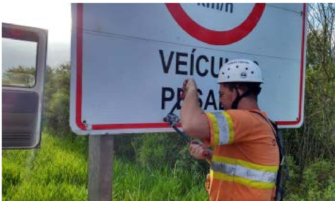
*Figura 81 – CONSERVAÇÃO/MANUTENÇÃO – IMPLANTAÇÃO E ALINHAMENTO DE PLACAS DE SINALIZAÇÃO VERTICAL*
