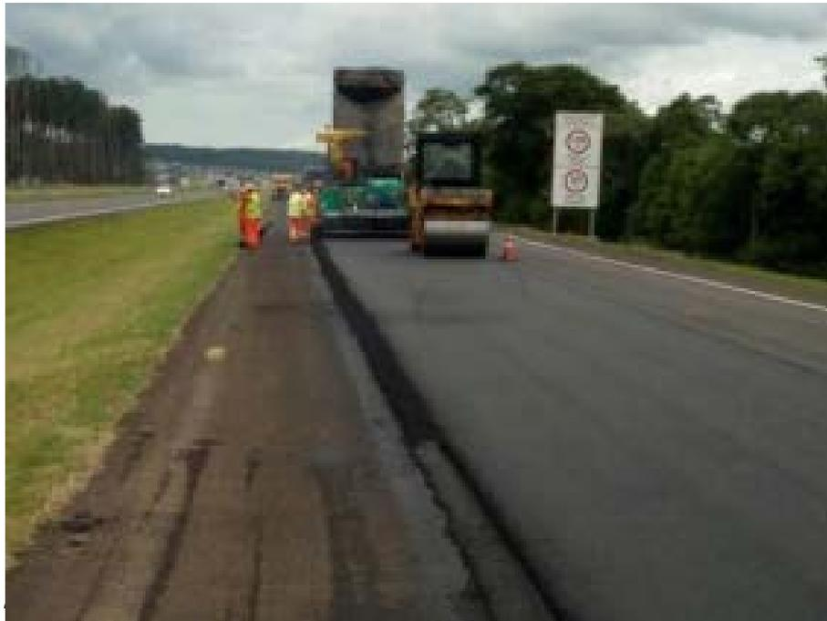
*Figura 46 - MELHORIAS AO LONGO DA RODOVIA - RECAPEAMENTO ASFÁLTICO DO PAVIMENTO*
