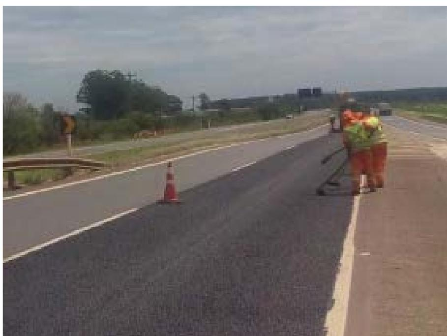
*Figura 53 - MELHORIAS AO LONGO DA RODOVIA - APLICAÇÃO DE MICRO REVESTIMENTO ASFÁLTICO*
