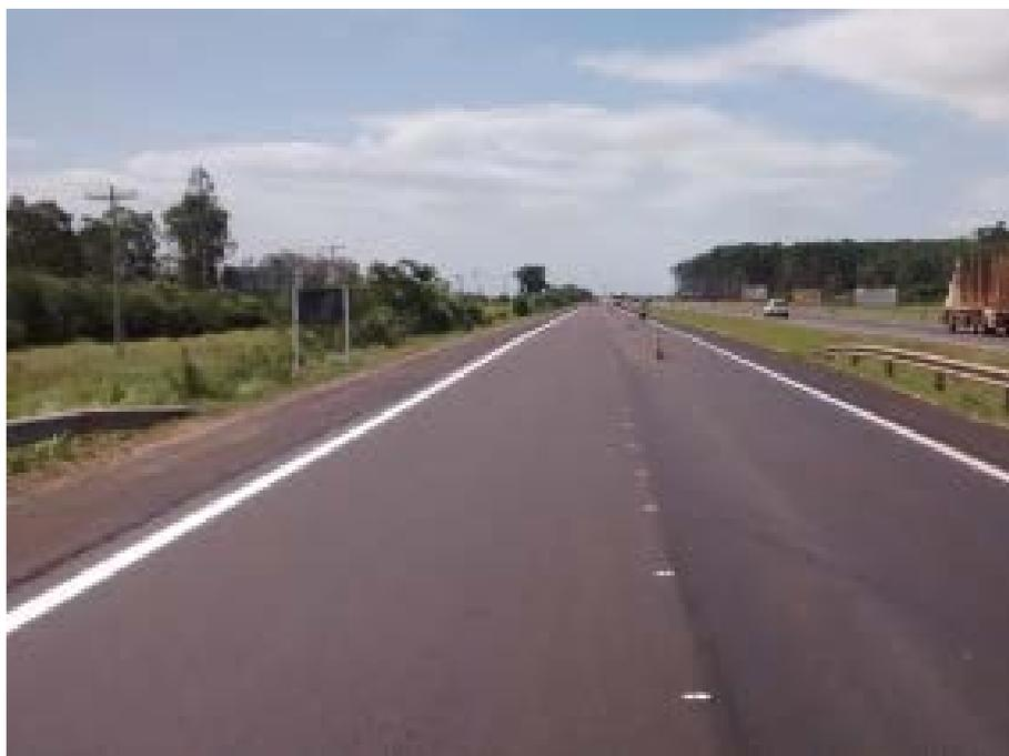
*Figura 51 - MELHORIAS AO LONGO DA RODOVIA - RECAPEAMENTO ASFÁLTICO DO PAVIMENTO*
