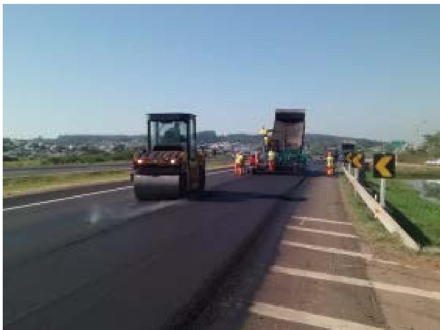
*Figura 52 - MELHORIAS AO LONGO DA RODOVIA - RECAPEAMENTO ASFÁLTICO DO PAVIMENTO*
