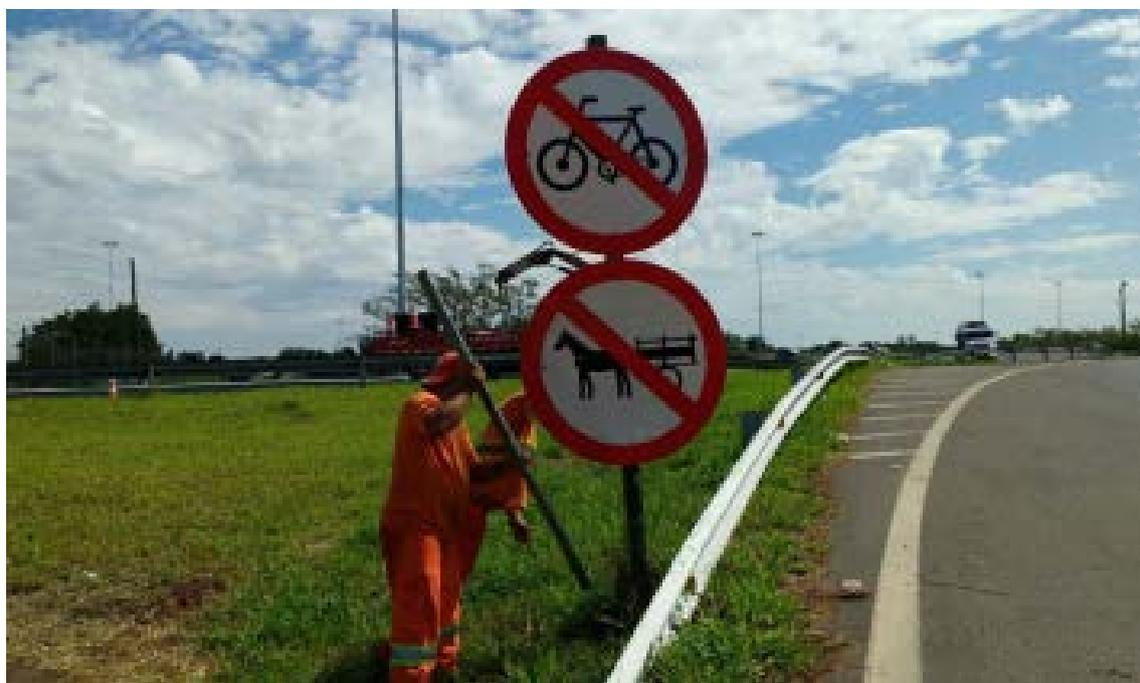
*Figura 85 – CONSERVAÇÃO/MANUTENÇÃO – IMPLANTAÇÃO E ALINHAMENTO DE PLACAS DE SINALIZAÇÃO VERTICAL*
