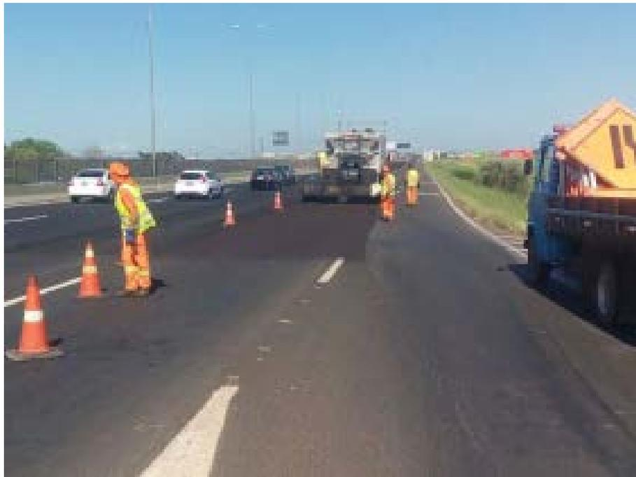
*Figura 56 - MELHORIAS AO LONGO DA RODOVIA - APLICAÇÃO DE MICRO REVESTIMENTO ASFÁLTICO*
