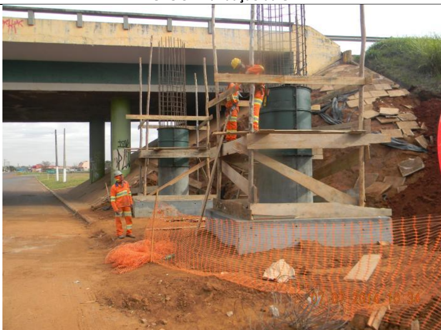
FOTO 6 – Fundação da OAE
