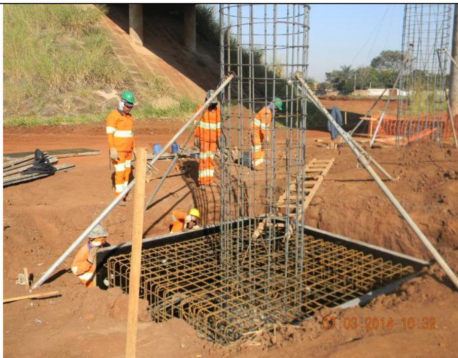
FOTO 7 – Fundação da OAE
