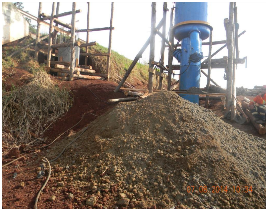
FOTO 5 – Fundação da OAE
