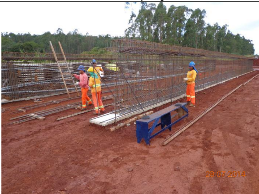
FOTO 2 – Armação das vigas
