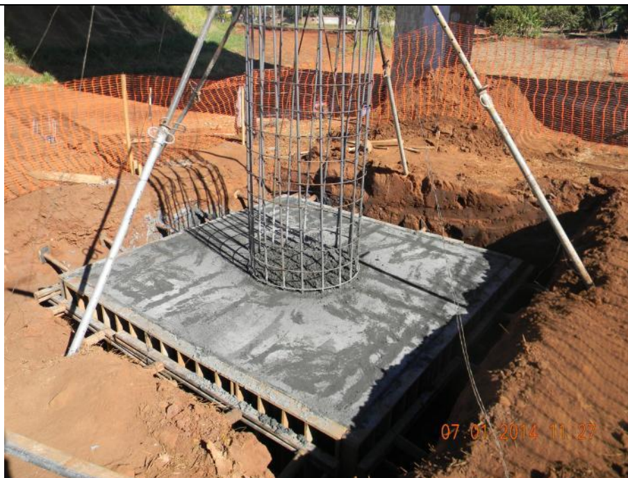
FOTO 9 – Fundação da OAE
