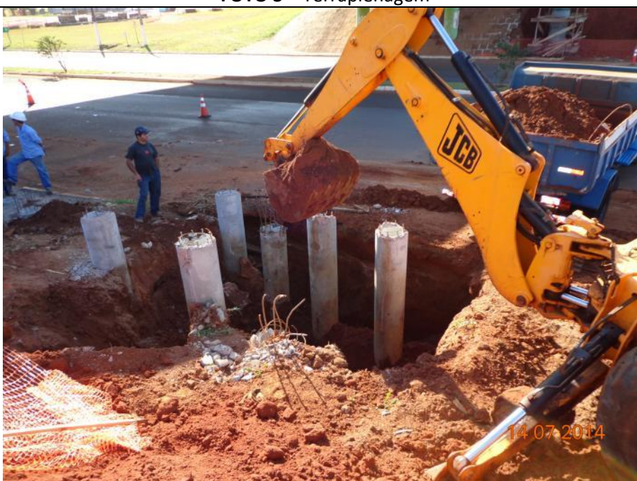
FOTO 4 – Fundação da OAE
