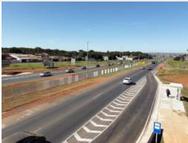
Foto 01: Tela antiofuscante instalada
