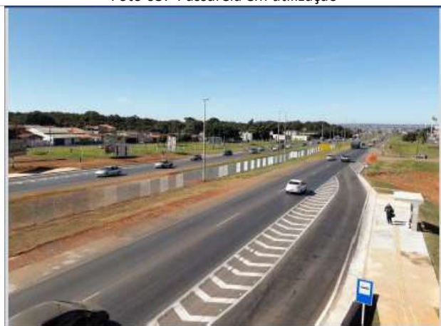
Foto 04: Baía Sul e abrigo finalizados
