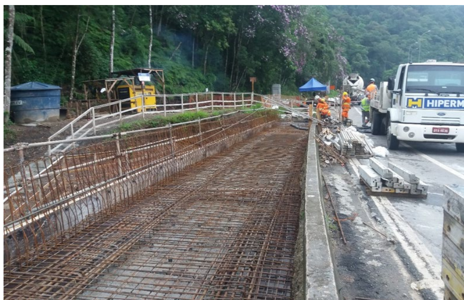
Figura 9 – Alargamento da OAE Km 358+400 – Alargamento e Reforço Estrutural
