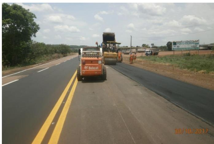
Figura 16 – Recomposição com pavimento Km 767+800
