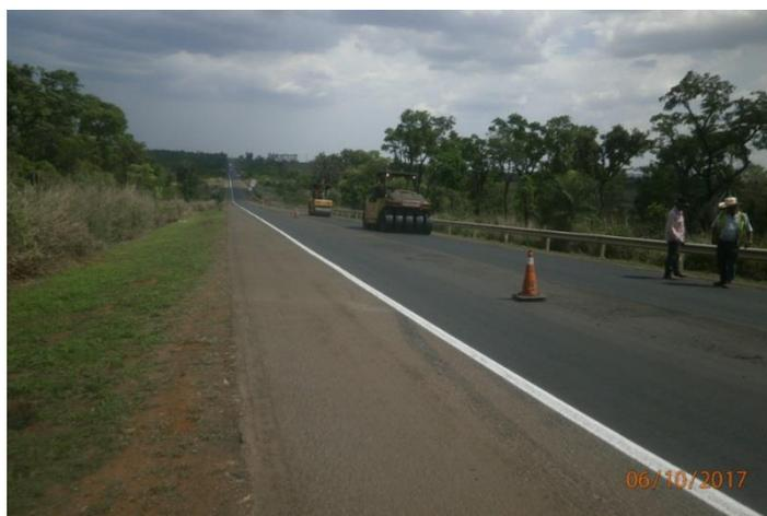
Figura 11 – Recomposição com pavimento Km 572+000
