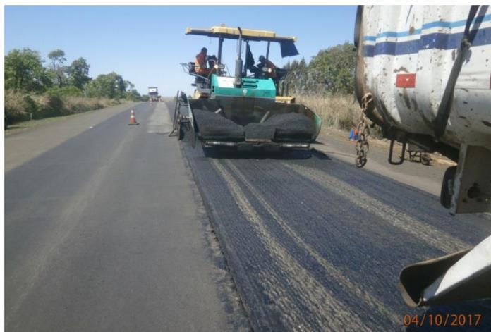
Figura 12 – Recomposição com pavimento Km 572+000
