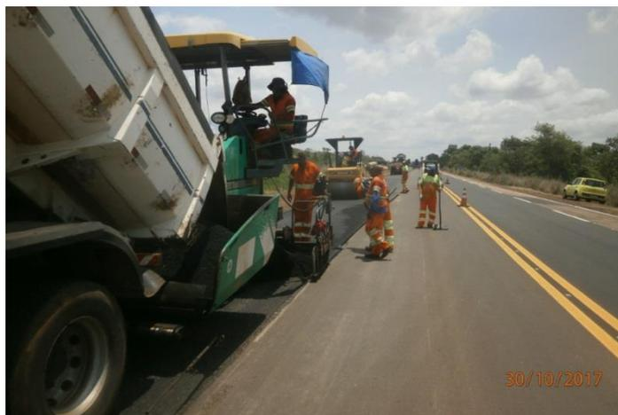
Figura 15 – Recomposição com pavimento Km 767+800
