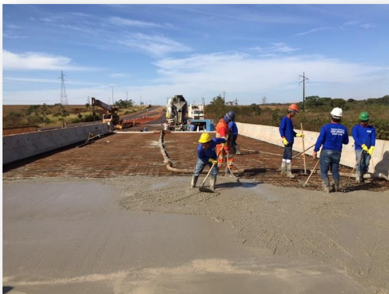
Foto 01 – Ponte sobre o Rio Ponte Vermelha Km 600+716
