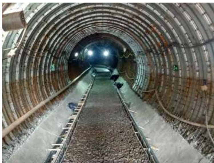
Figura 15 – Execução do Túnel de Emergência, não previsto no PER (Lote 06)
