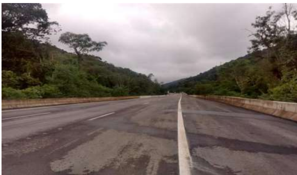
Figura 12 – OAE 21 – Concluída, incluindo 4ª Faixa, não previsto no PER (Lote 04)
