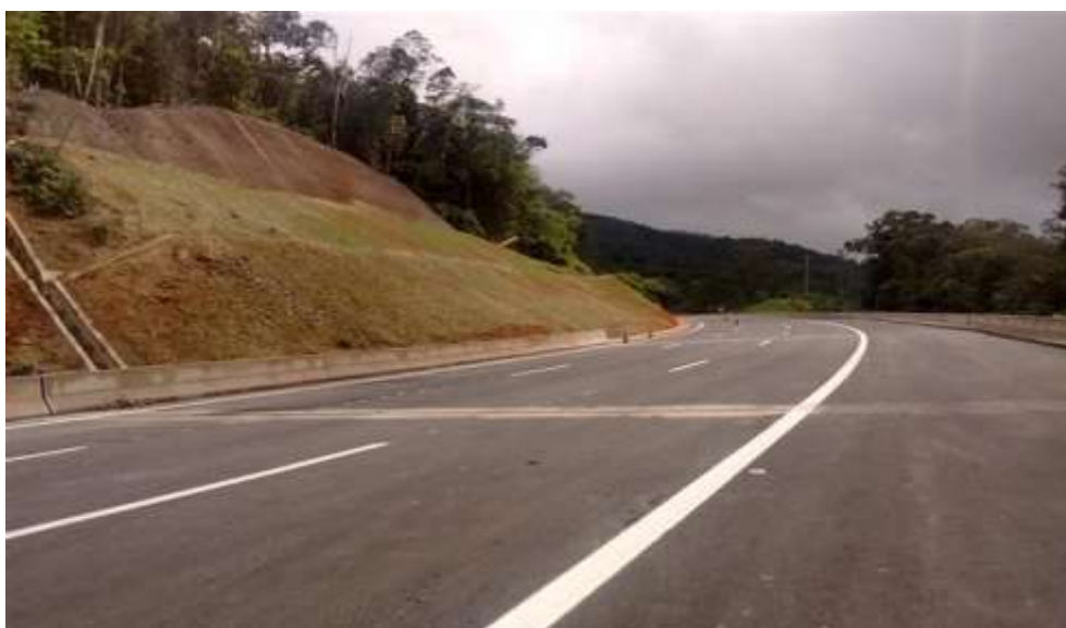
Figura 6 – OAE 13 – Concluída, incluindo 4ª Faixa, não previsto no PER (Lote 04)
