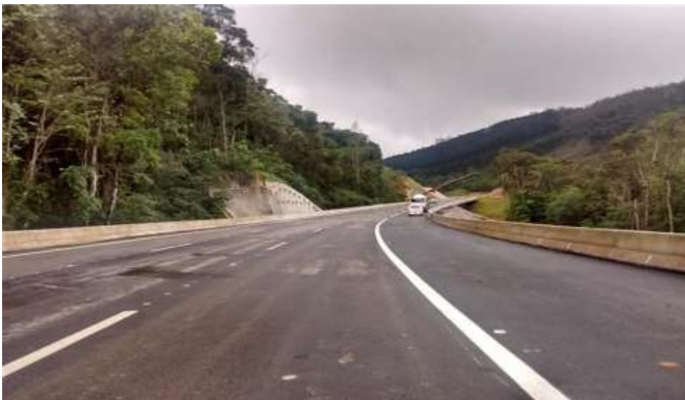
Figura 4 – OAE's 10 e 11 – Concluída, incluindo 4ª Faixa, não previsto no PER (Lote 04)
