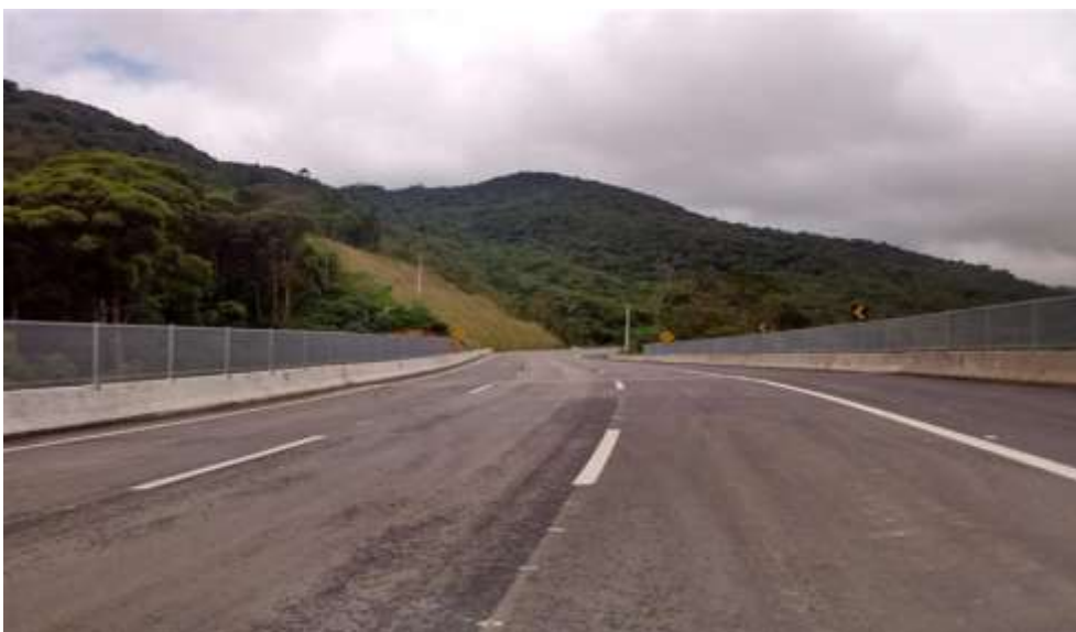
Figura 14 – OAE 23 – Concluída, incluindo 4ª Faixa, não previsto no PER (Lote 04)
