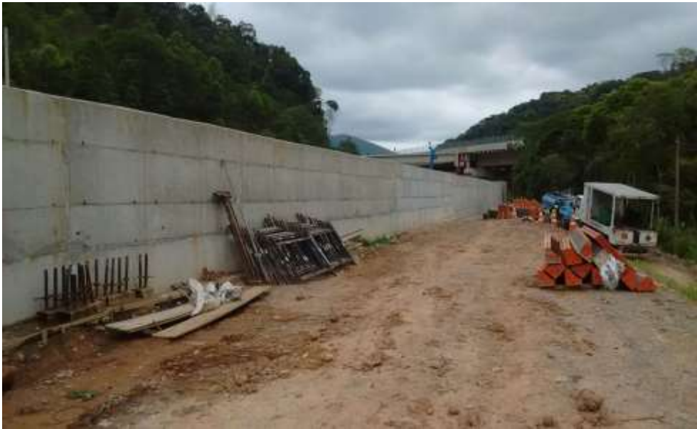
Figura 19 – Concretagem do muro – Área de Escape Km 353+000
