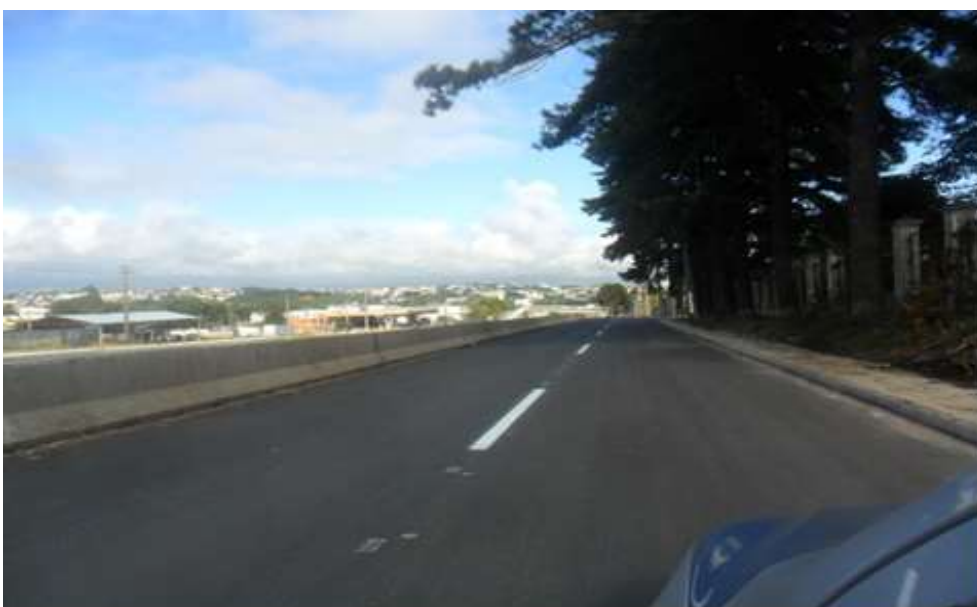
Figura 24 - OBRA PARALISADA – Km 16+200 ao Km 17+500 Pista Sul.
