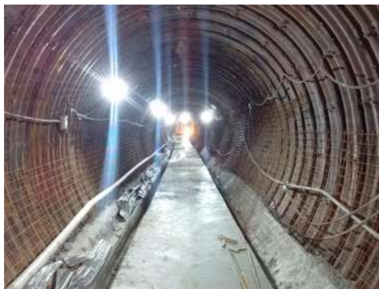
Figura 16 – Execução do Túnel de Emergência, não previsto no PER (Lote 06)
