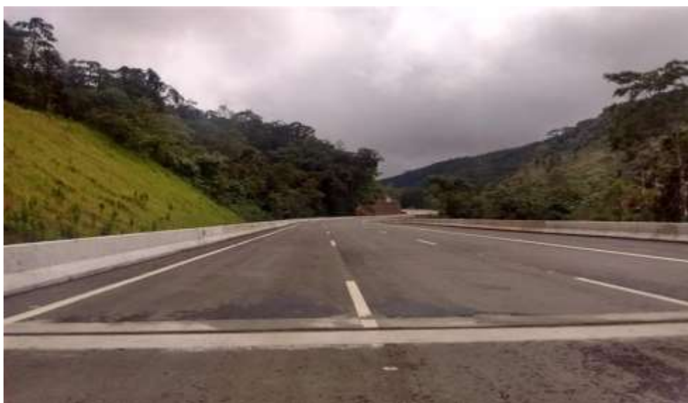
Figura 8 – OAE 15 – Concluída, incluindo 4ª Faixa, não previsto no PER (Lote 04)
