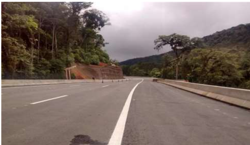
Figura 7 – OAE 14 – Concluída, incluindo 4ª Faixa, não previsto no PER (Lote 04)
