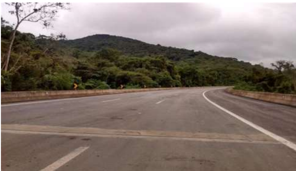
Figura 13 – OAE 22 – Concluída, incluindo 4ª Faixa, não previsto no PER (Lote 04)
