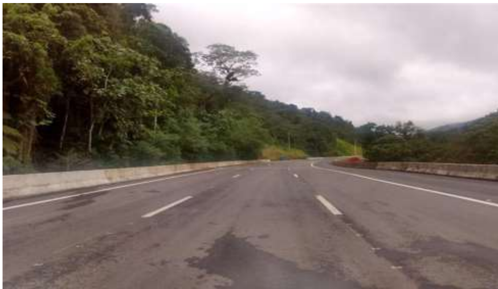
Figura 11 – OAE 20 – Concluída, incluindo 4ª Faixa, não previsto no PER (Lote 04)
