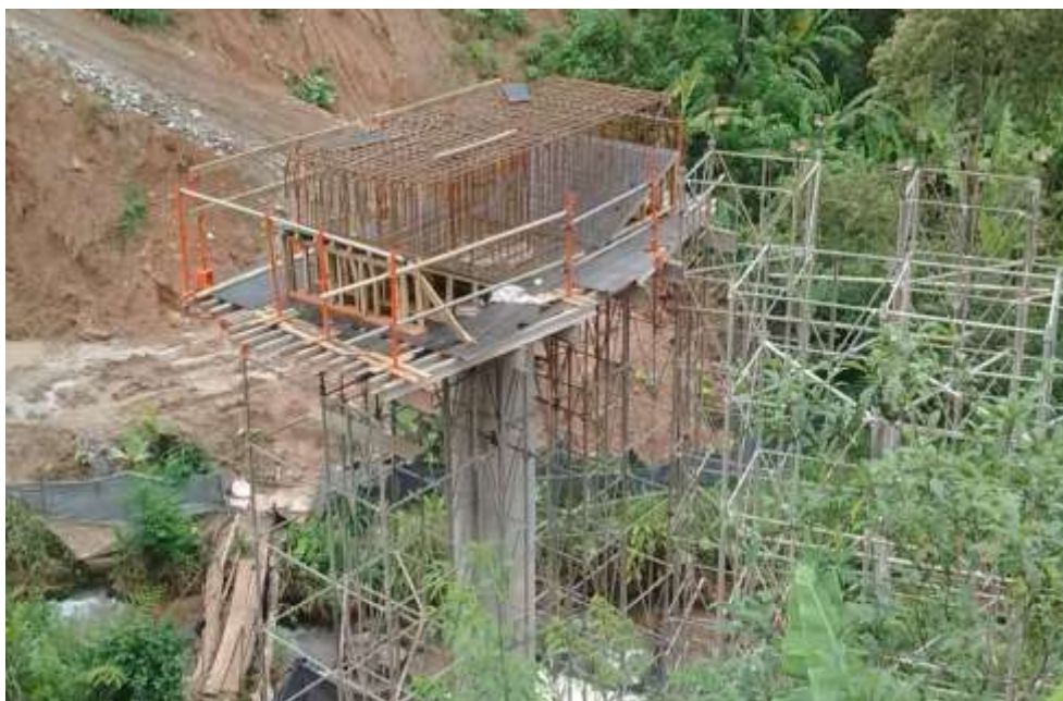
Figura 18 – O.A.E – Retorno Operacional - km 352+000 - Serra do Cafezal
