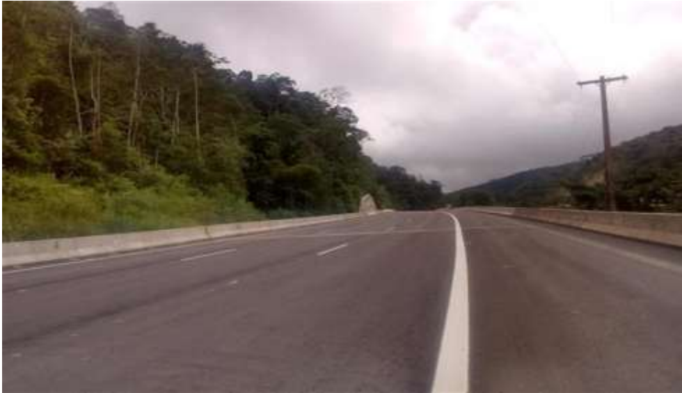
Figura 9 – OAE's 16 e 17 – Concluída, incluindo 4ª Faixa, não previsto no PER (Lote 04)
