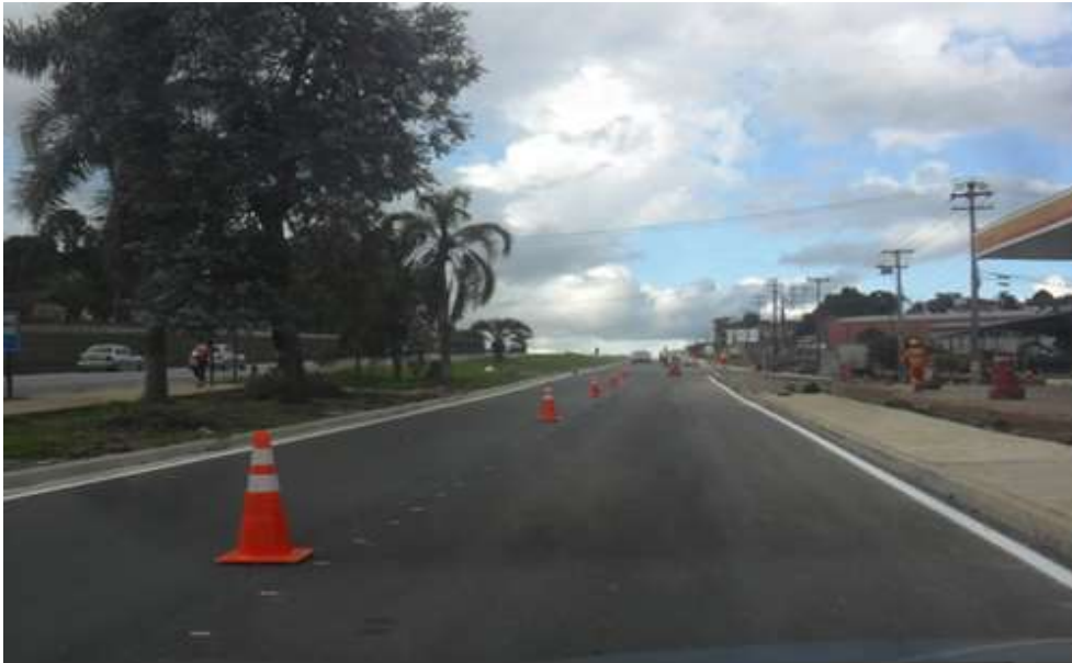
Figura 25 - OBRA PARALISADA – Km 16+300 ao Km 17+500 Pista Norte.
