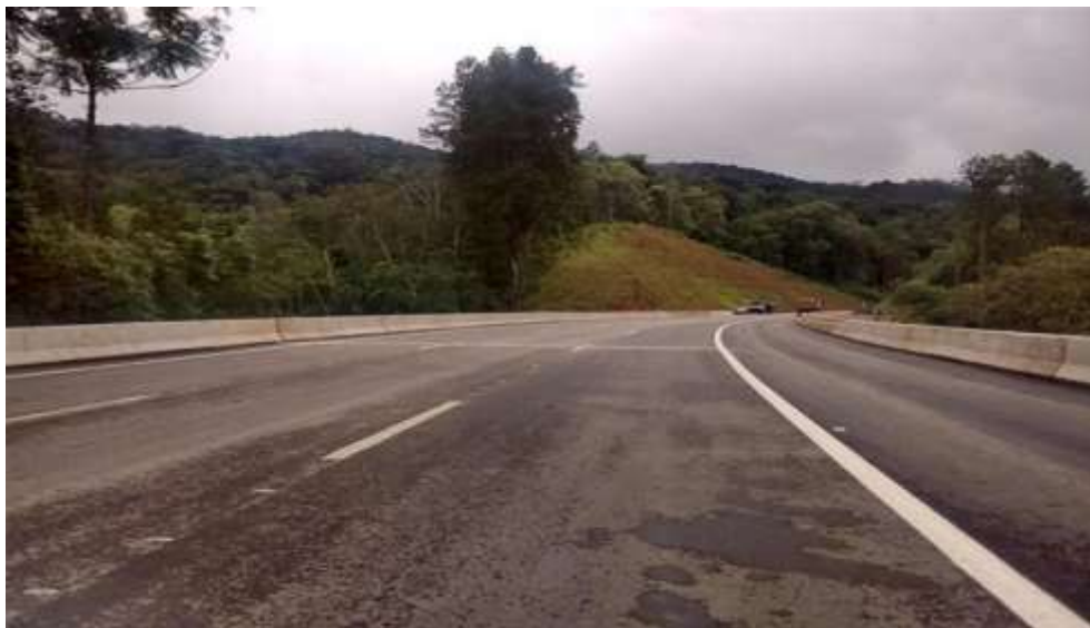
Figura 5 - OAE 12 – Concluída, incluindo 4ª Faixa, não previsto no PER (Lote 04)
