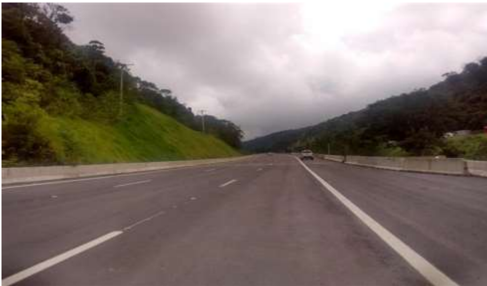
Figura 10 – OAE's 18 e 19 – Concluída, incluindo 4ª Faixa, não previsto no PER (Lote 04)
