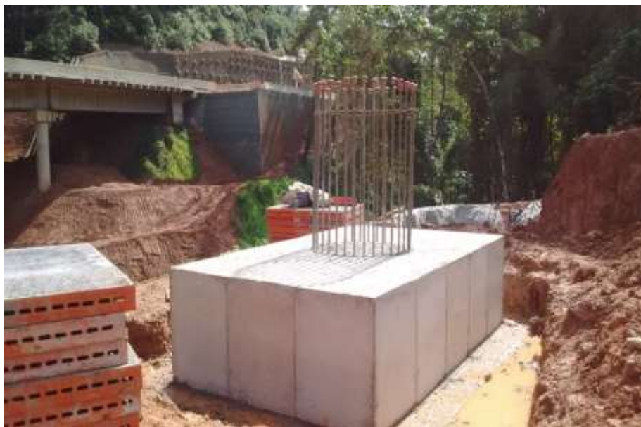
Figura 17 – O.A.E – Retorno Operacional - km 351+500 - Serra do Cafezal
