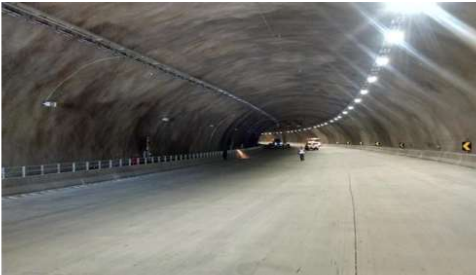
Figura 1- Pavimento Concluído, em execução Automação e Elétrica (Lote 03)
