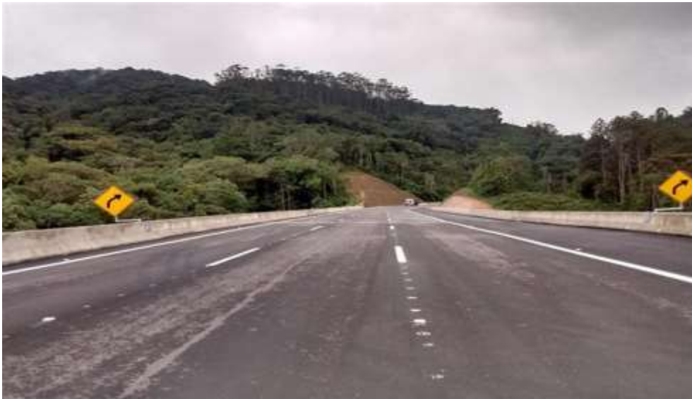
Figura 3 - OAE 09 – Concluída, incluindo 4ª Faixa, não previsto no PER (Lote 04)
