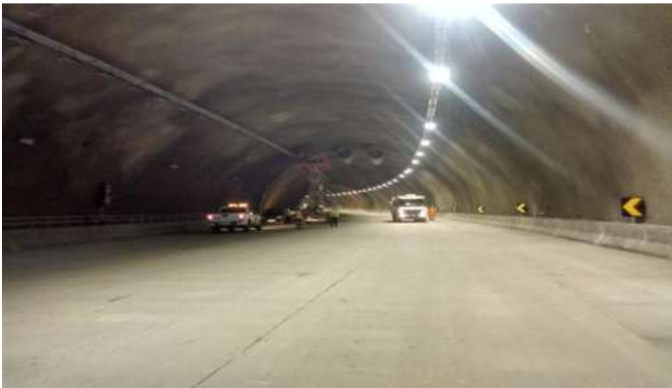
Figura 2 – Pav. Concluído, em execução Automação e Elétrica (Lote 03)
