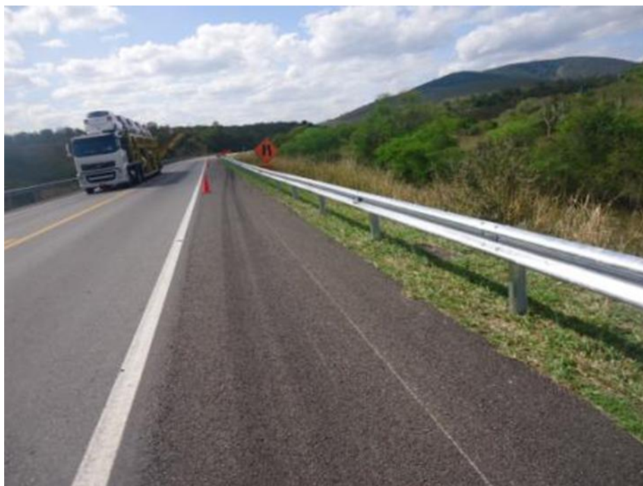
Figura 07 – Implantação de Defensas Metálicas
