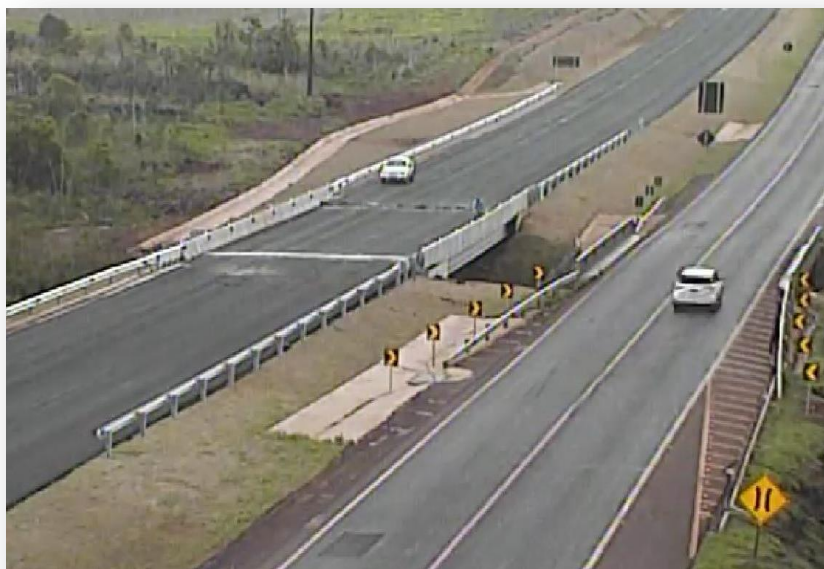
Foto 01 – Ponte sobre o Rio Ponte Vermelha Km 600+716
