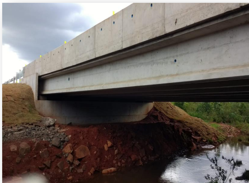
Foto 02 – Ponte sobre o Rio Ponte Vermelha Km 600+716
