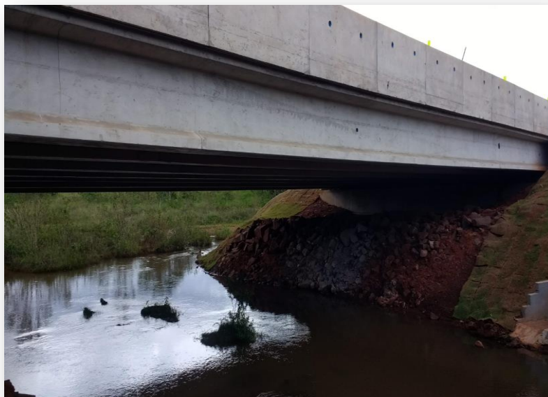
Foto 03 – Ponte sobre o Rio Ponte Vermelha Km 600+716
