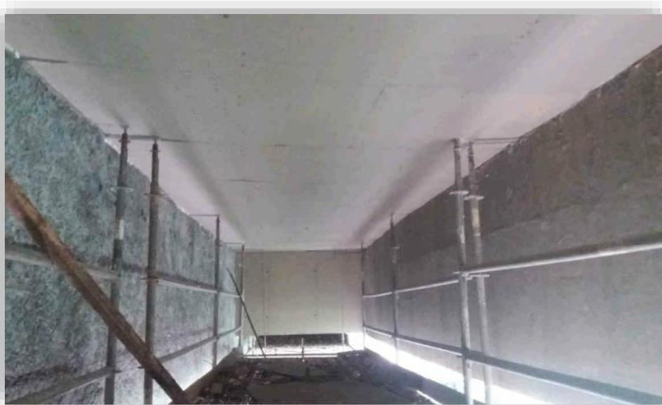
*Figura 9 – Alargamento da OAE Km 358+400 – Reforço Estrutural.*
