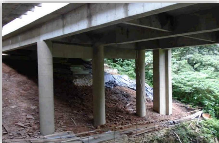
*Figura 5 – Alargamento da OAE Km 354+550 – Reforço Estrutural.*
