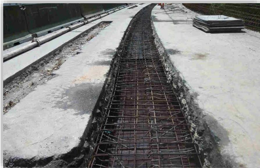
*Figura 7 – Alargamento da OAE Km 357+900 – Reforço Estrutural.*
