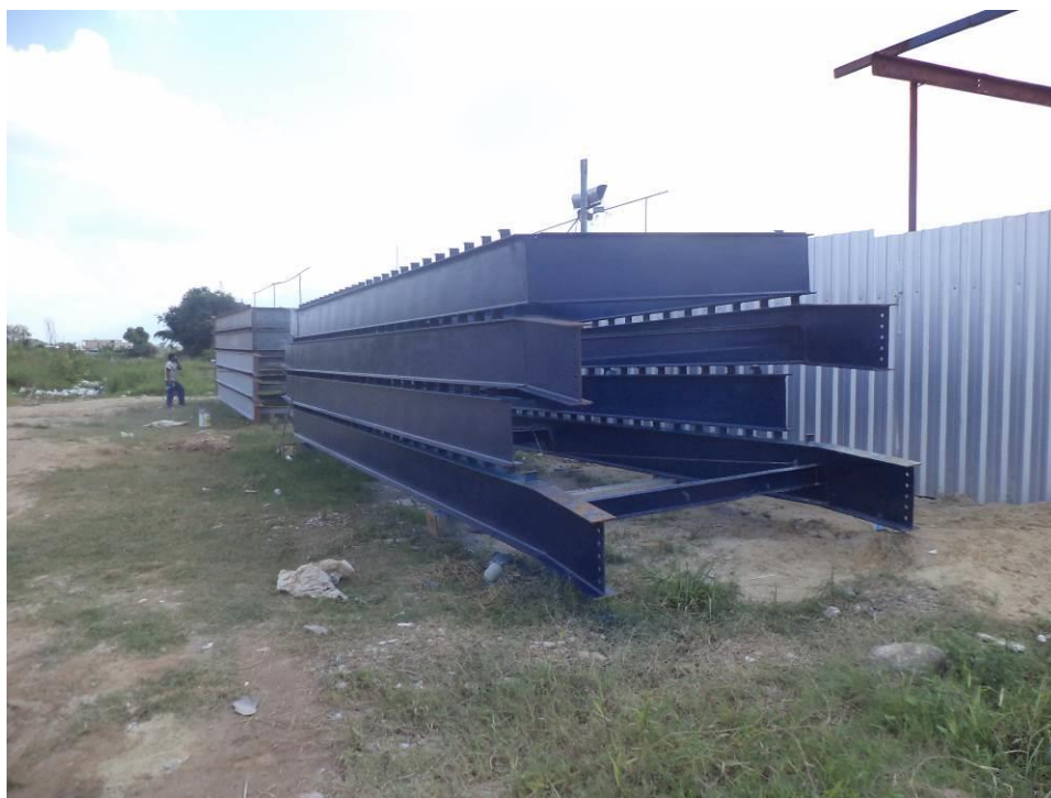
Figura 03 – km 105+900 – Implantação de Passarela Saracuruna – estrutura das rampas.
