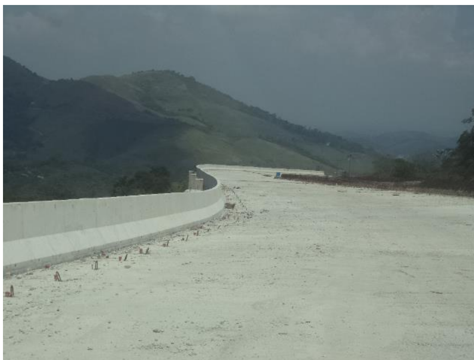
Figura 14 – Execução de Cortina Atirantada km 97 – Nova Subida da Serra
