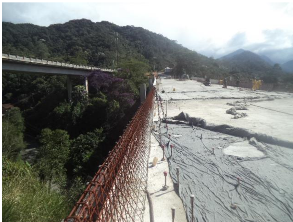
Figura 06 – Viaduto Luiz Winter III – Nova Subida da Serra
