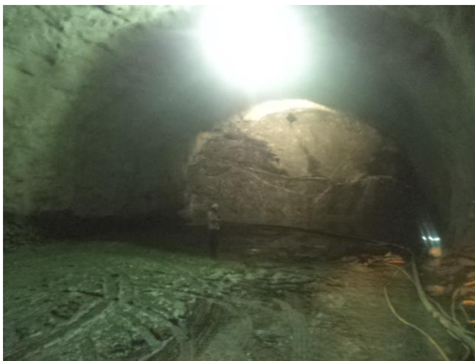
Figura 16 – Escavação do Túnel – frente Janela – Nova Subida da Serra
