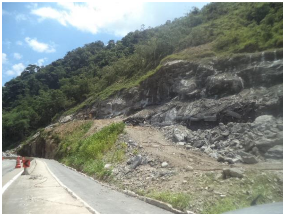
Figura 12 – Execução de Solo Grampeado km 92 – Nova Subida da Serra
