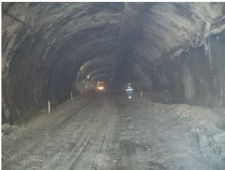
Figura 08 – Escavação do Túnel – Emboque – Nova Subida da Serra
