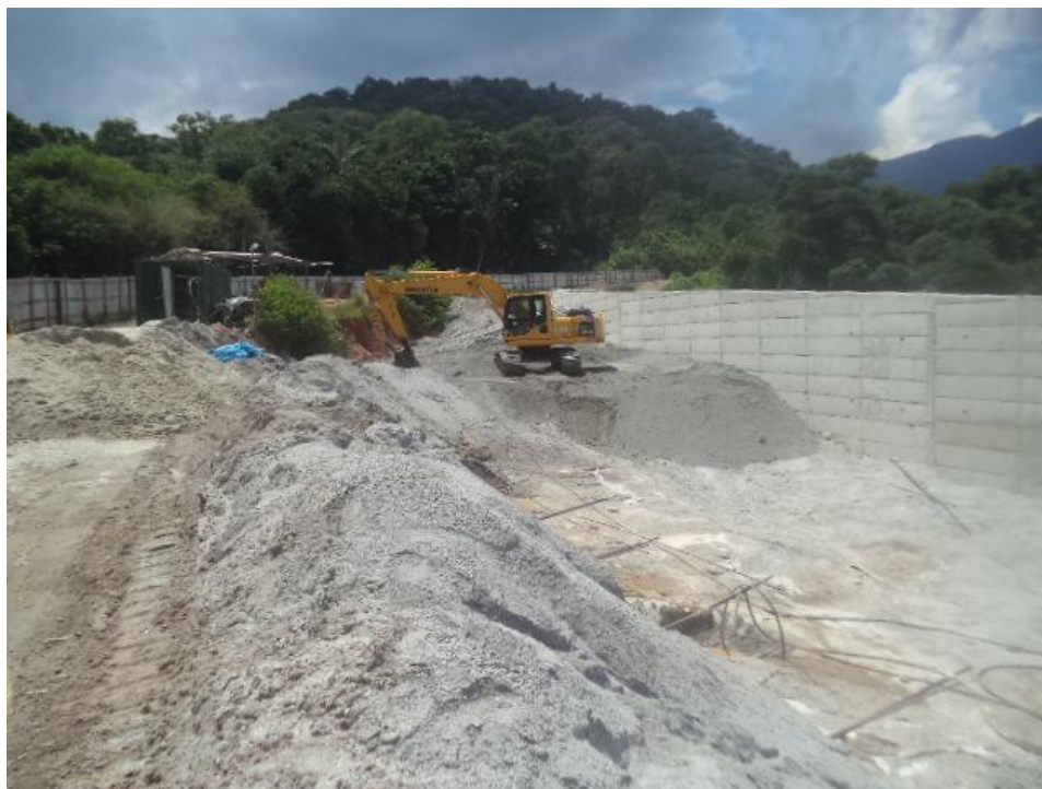
Figura 11 – Execução de Cortina Atirantada km 92 – Nova Subida da Serra
