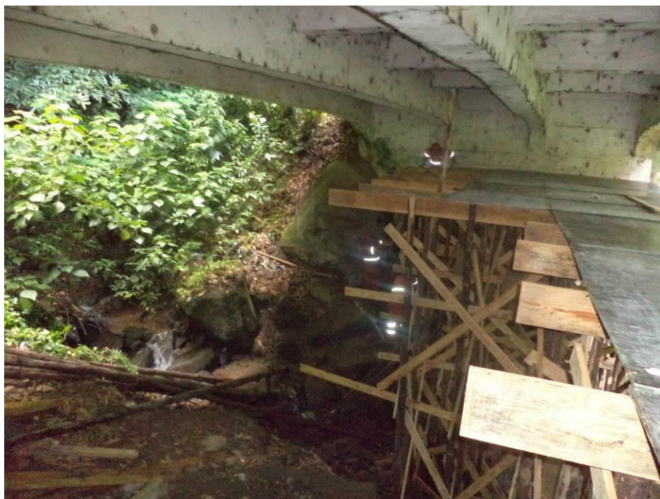
Figura 04 – km 91,8 sentido JF – Viaduto III – Em andamento apicoamento das estruturas de concreto.
