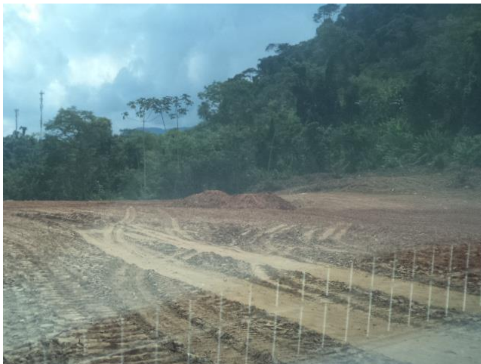
Figura 15 – Execução de Aterro km 97,50 – Nova Subida da Serra
