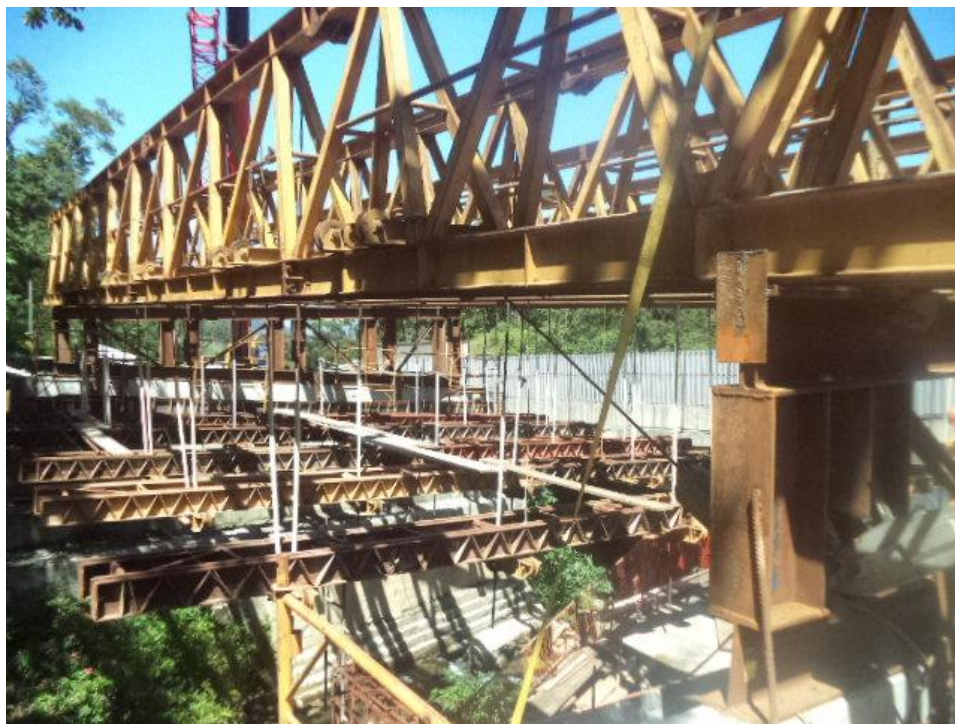
Figura 09 – Ponte sobre o Rio Major Archer – Nova Subida da Serra
