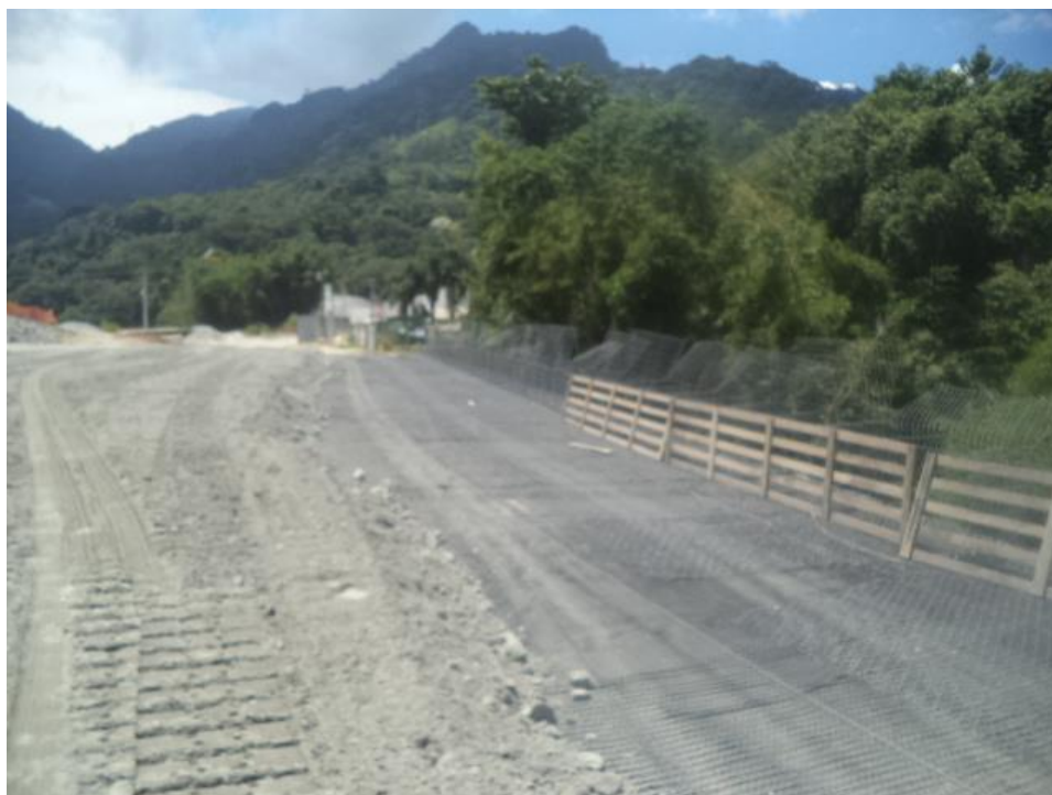
Figura 10 – Terramesh 1 e 2 – Nova Subida da Serra
