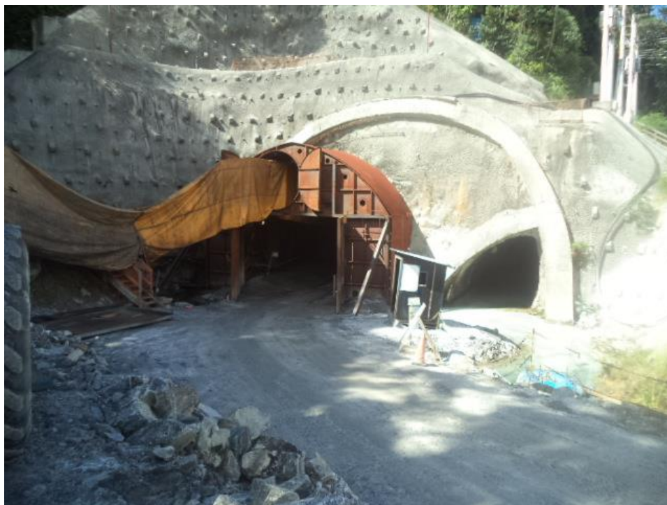
Figura 07 – Escavação do Túnel – frente desemboque - Nova Subida da Serra
