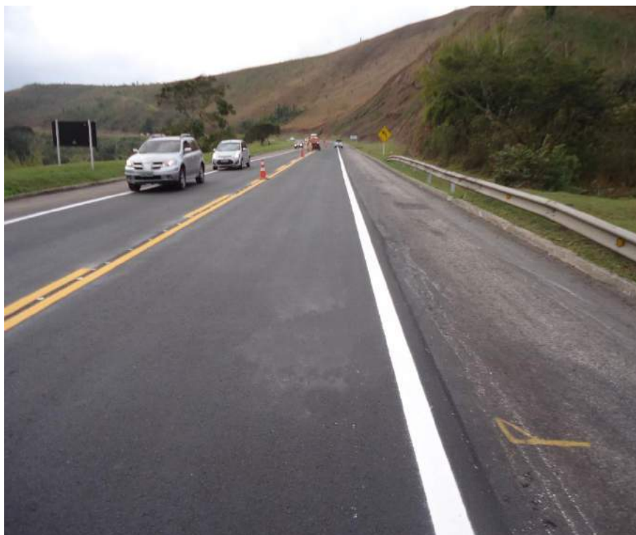
Conservação da Rodovia – Km 50,8 – P2 – Manutenção da sinalização horizontal – Pintura de bordo e eixo
