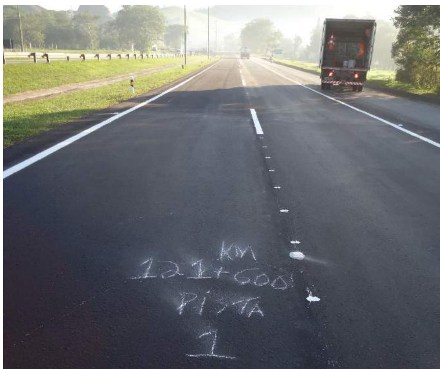
Conservação da Rodovia – Km 107,4 – P1 - Manutenção da sinalização horizontal – Implantação de tachas
