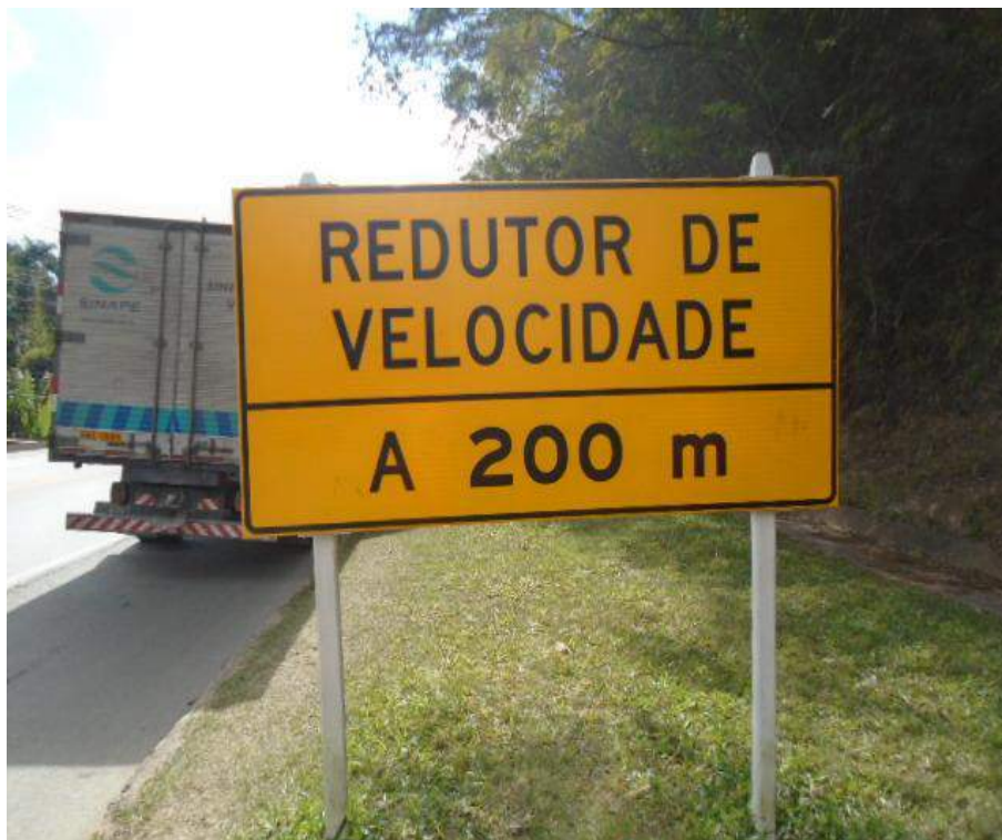
Conservação da Rodovia – Km 78,02– P2 - Manutenção da sinalização vertical
