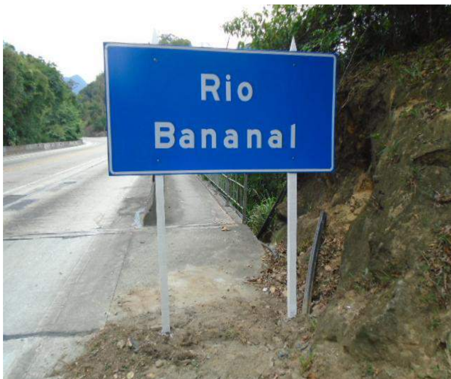
Conservação da Rodovia – Km 101,8 – P2 - Manutenção da sinalização vertical
