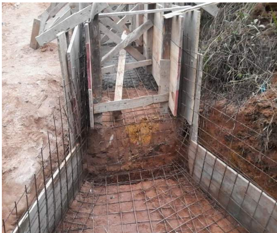
Conservação da Rodovia – Km 39 – P2 – Construção da canaleta de drenagem
