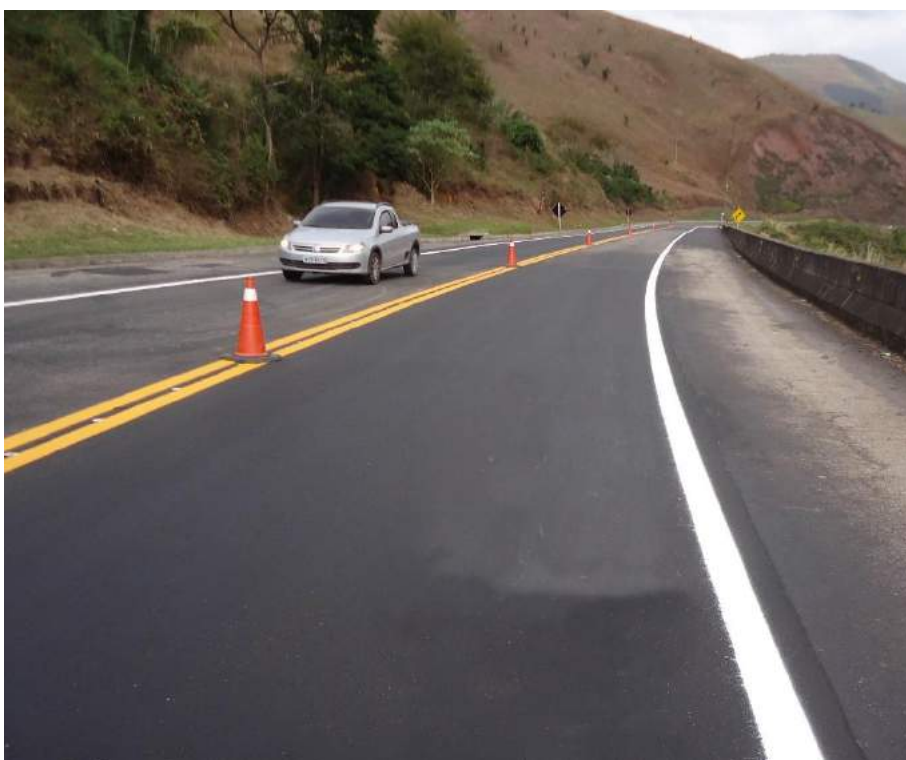
Conservação da Rodovia – Km 50,2 – P1 – Manutenção da sinalização horizontal – Pintura de bordo e eixo
