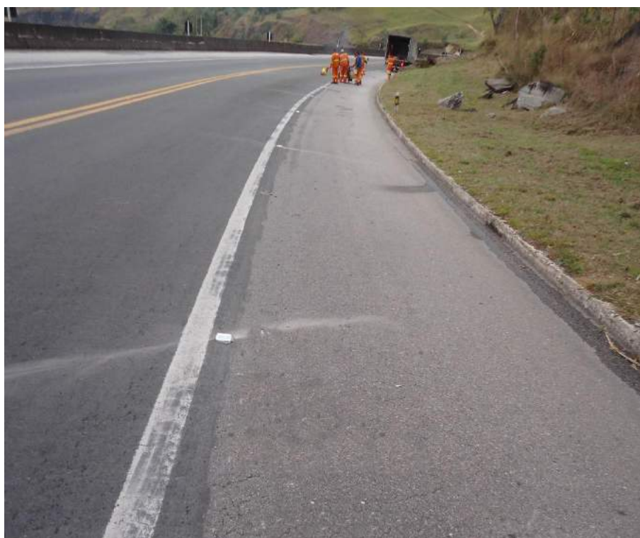
Conservação da Rodovia – Km 31 – P2 - Manutenção da sinalização horizontal – Implantação de tachas
