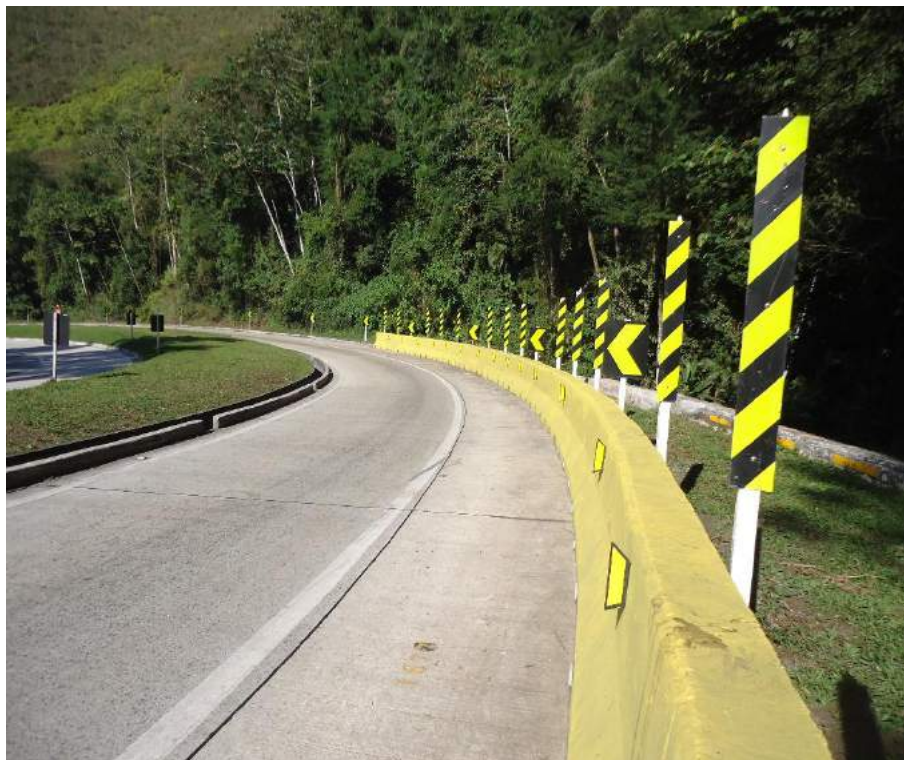
Conservação da Rodovia – Km 99,5 – P1 - Manutenção da sinalização vertical
