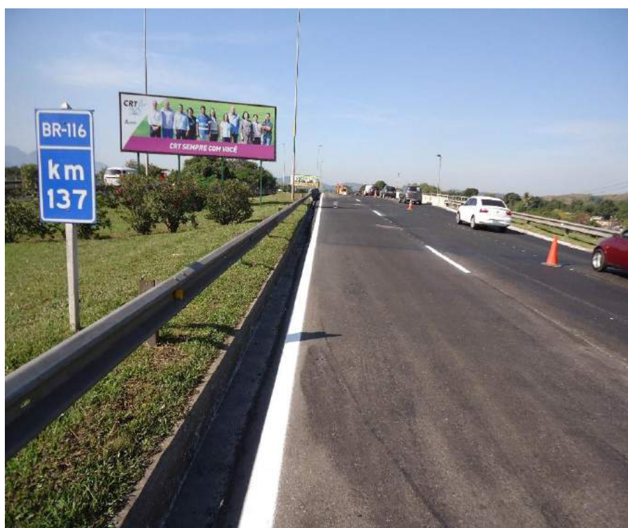
Conservação da Rodovia - Km 137 – P2 - Manutenção da sinalização horizontal – Pintura de bordo
