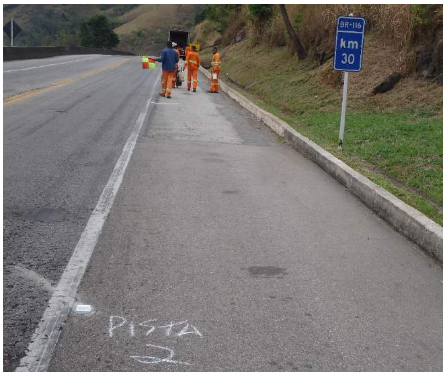
Conservação da Rodovia – Km 30 – P2 - Manutenção da sinalização horizontal – Implantação de tachas
