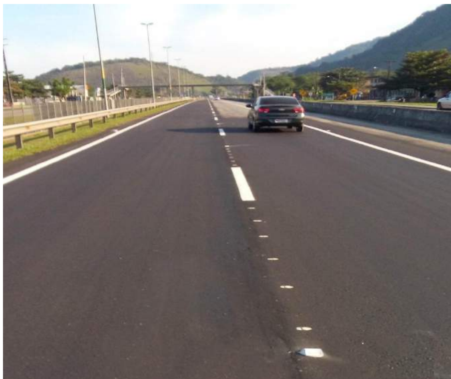
Conservação da Rodovia – Km 107,4 – P1 - Manutenção da sinalização horizontal – Implantação de tachas
