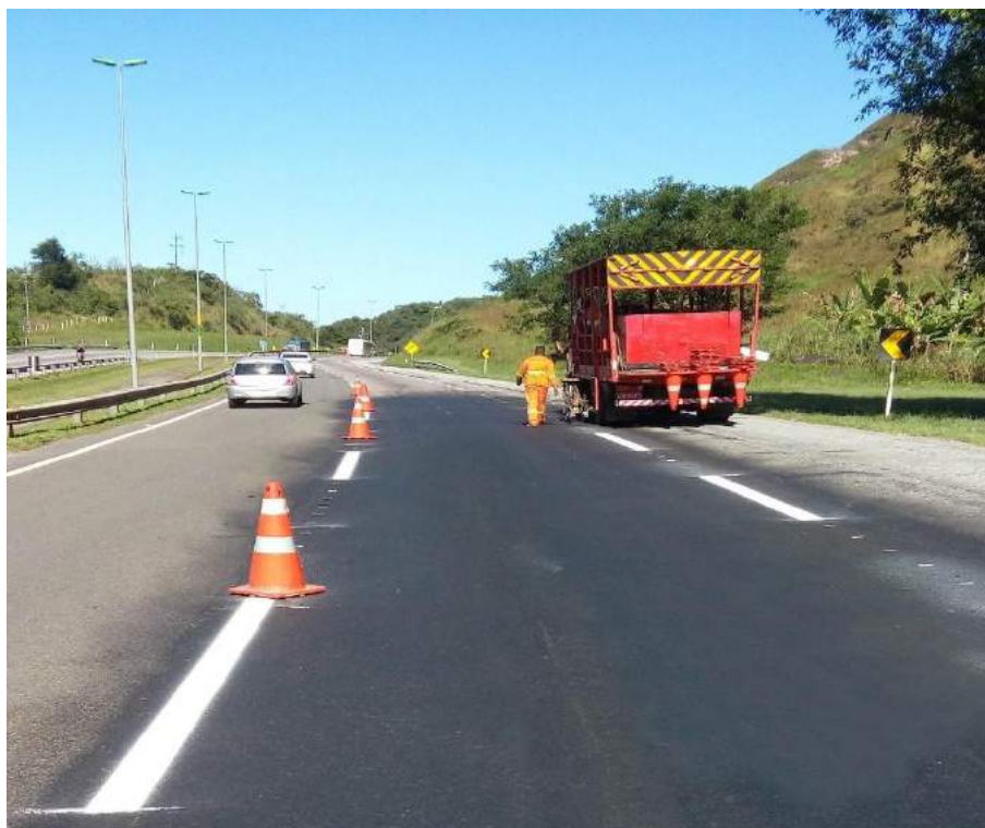
Conservação da Rodovia – Km 109,7 – P1 – Manutenção da sinalização horizontal – Pintura de bordo
