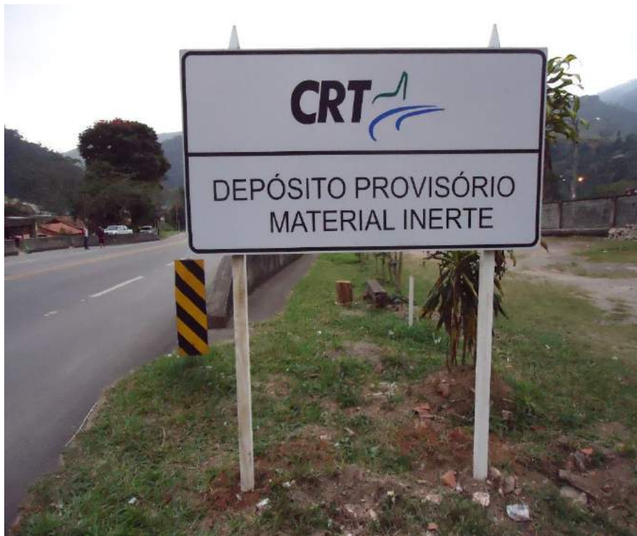
Conservação da Rodovia – Km 71– P1 - Implantação da sinalização vertical
