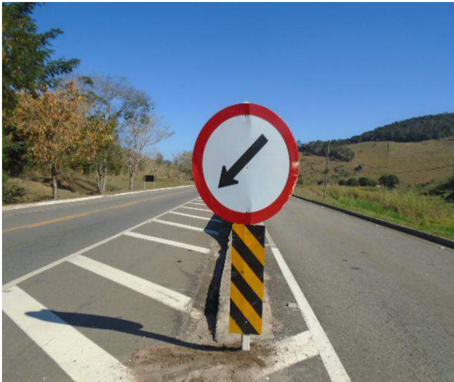
Conservação da Rodovia - Km 7,7 – P1 - Manutenção da sinalização vertical
