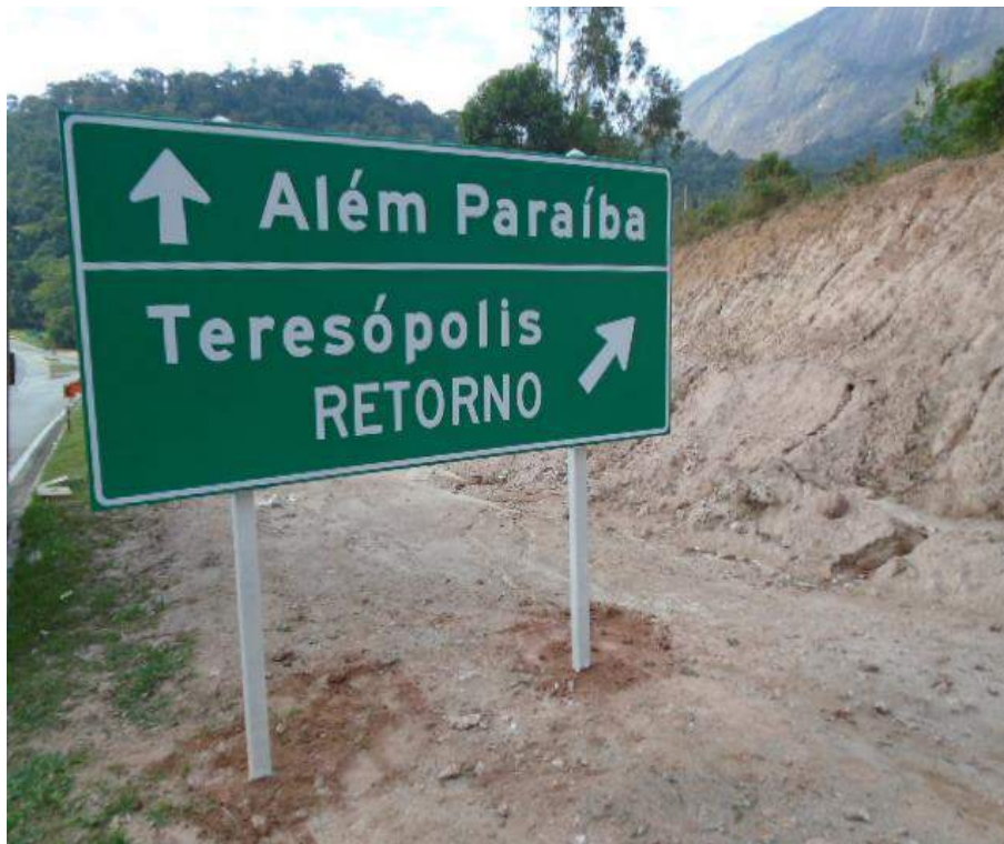
Conservação da Rodovia – Km 80,6 – P2 – Implantação da sinalização vertical
