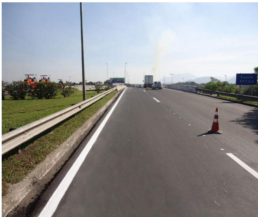
Conservação da Rodovia - Km 136,8 – P1 - Manutenção da sinalização horizontal – Pintura de bordo
