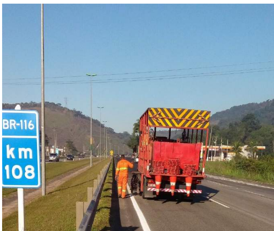
Conservação da Rodovia – Km 108 – P1 – Manutenção da sinalização horizontal – Pintura de bordo
