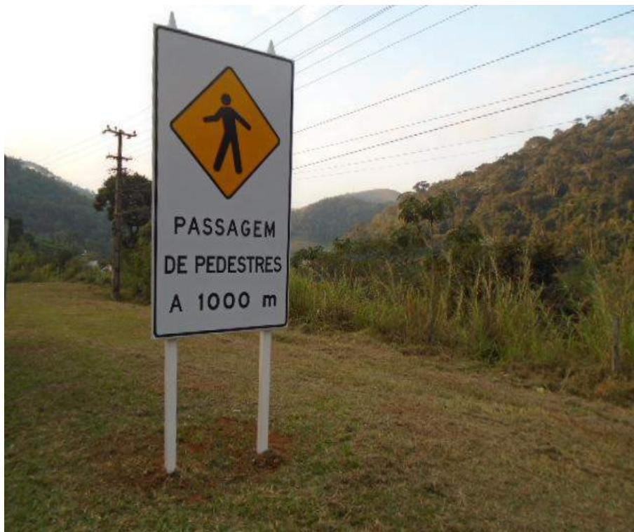
Conservação da Rodovia – Km 68,2 – P2 – Implantação da sinalização vertical
