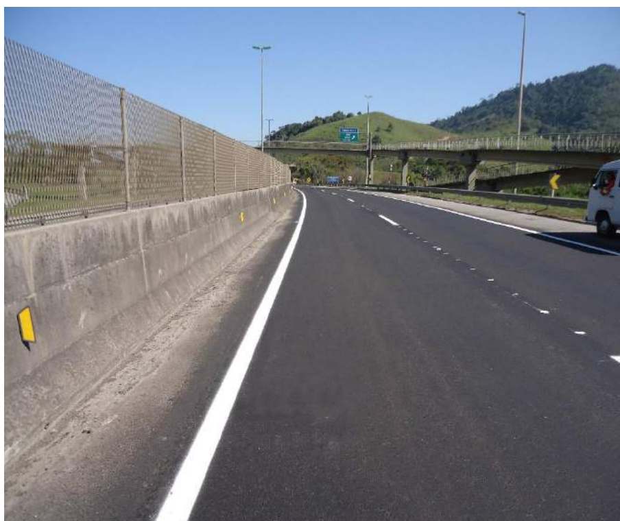
Conservação da Rodovia – Km 122 – P1 – Manutenção da sinalização horizontal – Pintura de bordo
