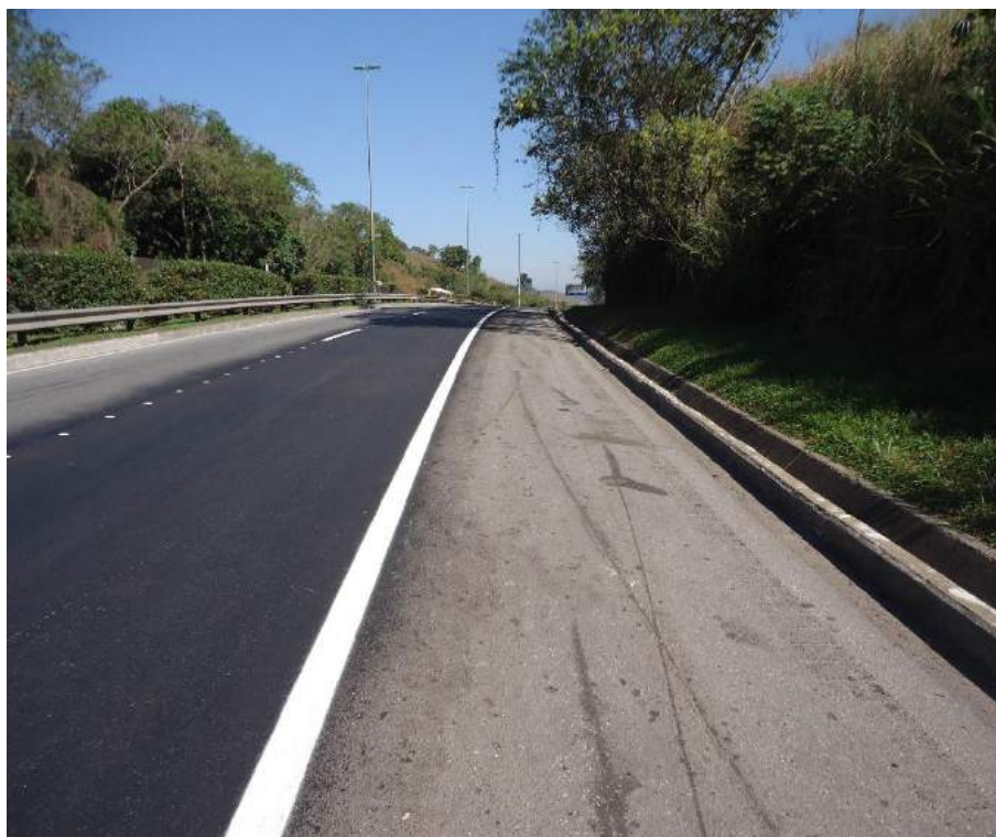
Conservação da Rodovia - Km 123,2 – P1 - Manutenção da sinalização horizontal – Pintura de bordo
