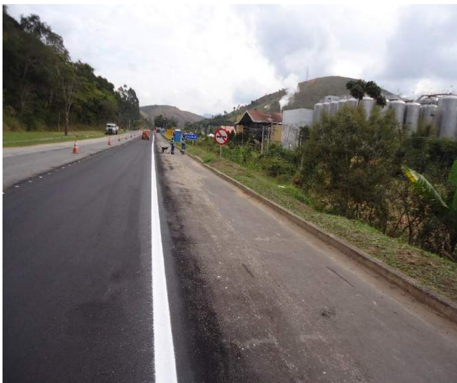
Conservação da Rodovia – Km 47,2 – P1 – Manutenção de sinalização horizontal – Pintura de bordo
