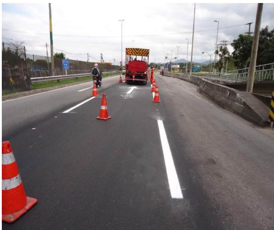
Conservação da Rodovia - Km 131 – P1 - Manutenção da sinalização horizontal – Pintura de bordo e eixo
