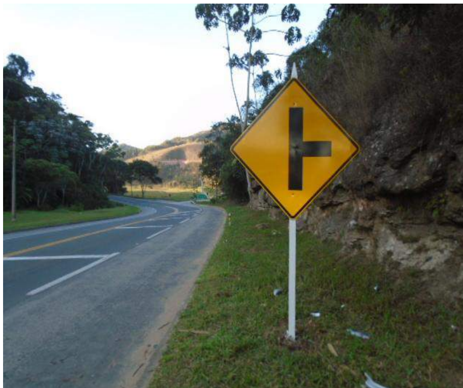
Conservação da Rodovia - Km 38,6 – P2 – Manutenção da sinalização vertical
