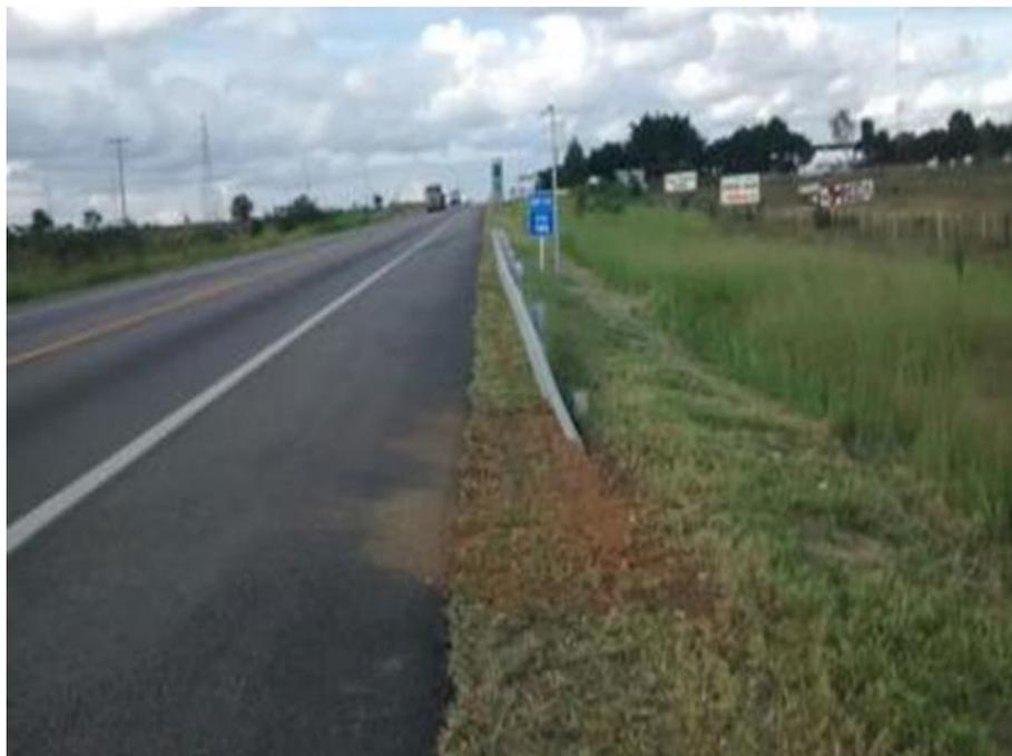
*Figura 07 – Implantação de Defensas Metálicas*
