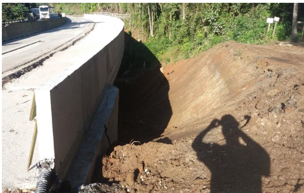
Figura 9 – Alargamento da OAE Km 358+400 – Taludes de encontro.
