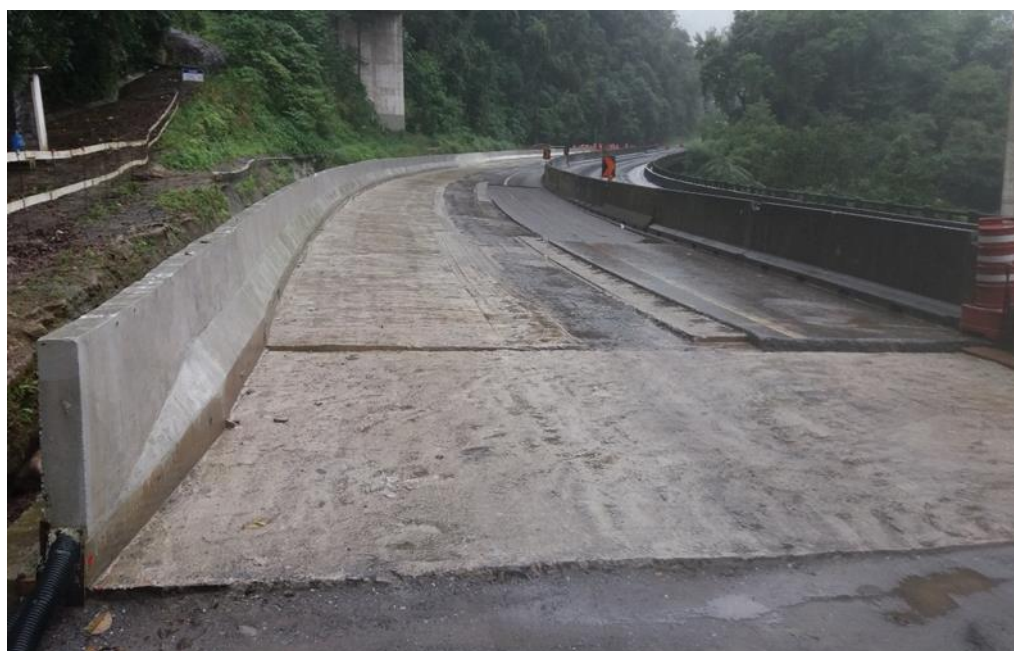
Figura 7 – Alargamento da OAE Km 357+900 –Vista geral
